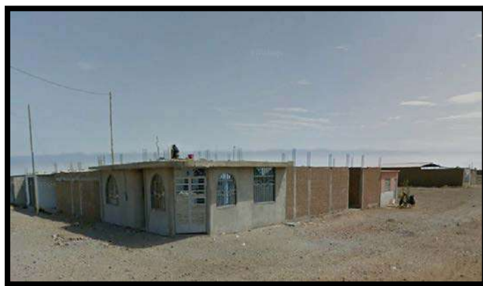
Figura 1. Viviendas pertenecientes a la Urb. Los Incas.
