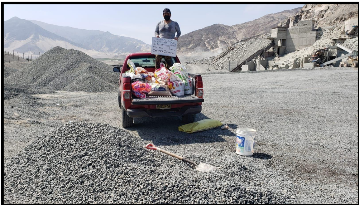
Figura 22. Traslado del agregado grueso desde la cantera Comincal
