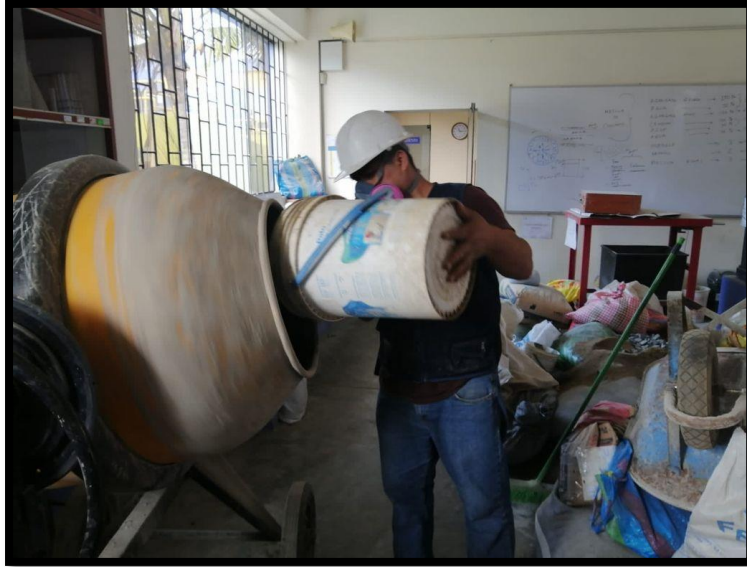
Figura 37. Vaciado del agregado grueso al trompo
