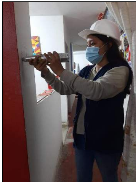
Figura 76. Aplicación De Esclerómetro Para Columna En Sentido Horizontal (Vivienda 1)
