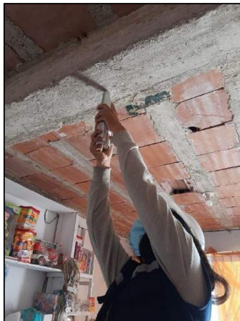
Figura 82. Aplicación De Esclerómetro Para Viga En Sentido Vertical (Vivienda 3)
