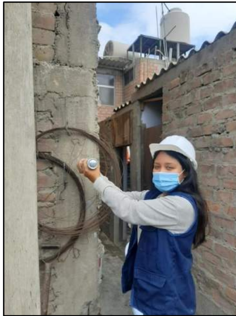
Figura 77. Aplicación De Esclerómetro Para Columna En Sentido Horizontal (Vivienda 2)
