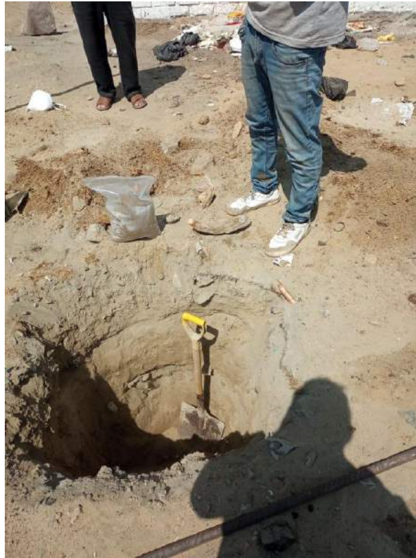
Figura 74. Retiro de muestra para estudio de suelos
