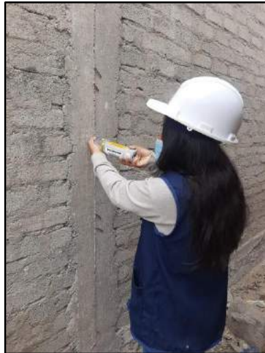
Figura 84. Aplicación De Elemento Estructural Columna (Vivienda 3)
