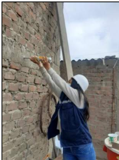
Figura 80. Aplicación De Esclerómetro Para Viga En Sentido Horizontal (Vivienda 2)
