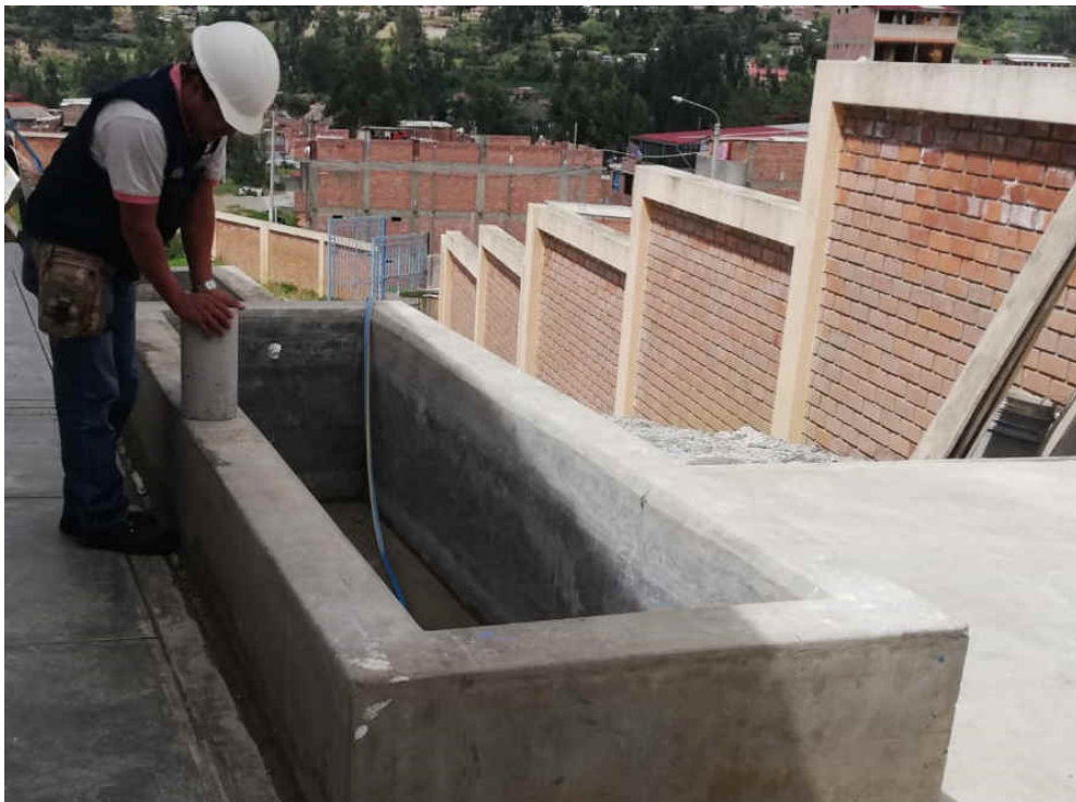
Figura N° 31: Almacenamiento de los testigos para su curado
