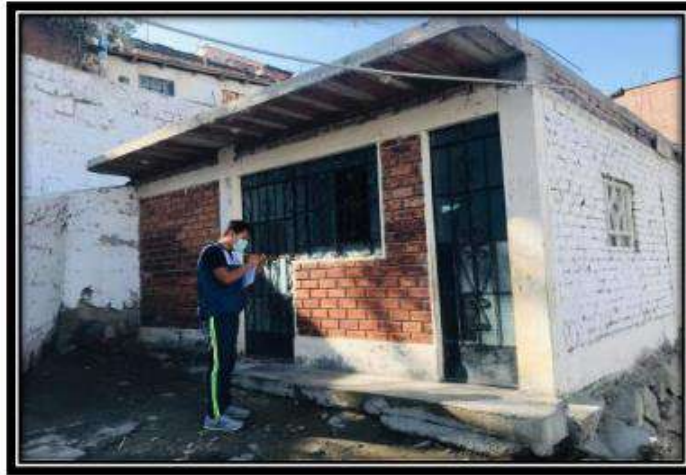
Imagen 01: Fachada de la vivienda B1 - 1
