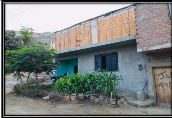
Imagen 01: Fachada de la vivienda B1 - 1
