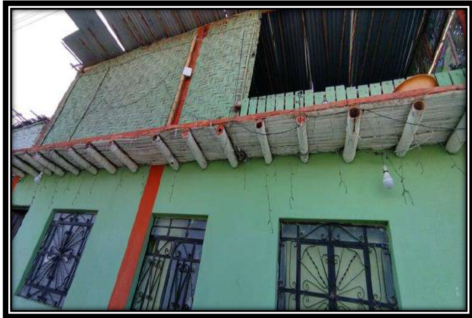
Figura 49: Vivienda autoconstruida de manera informal
