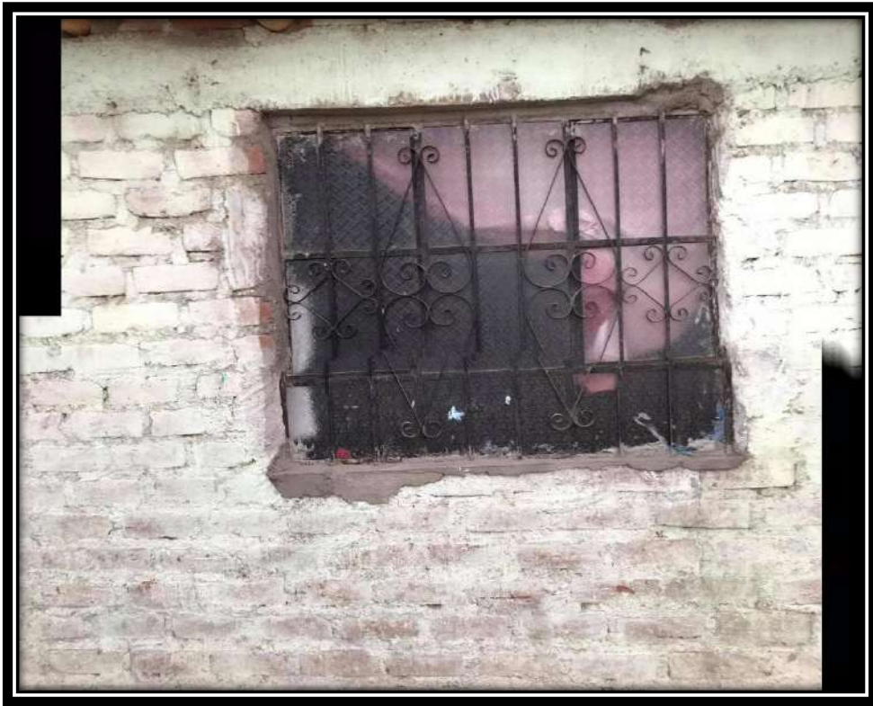
Figura 43: muro perforado para la colocación de ventana.
