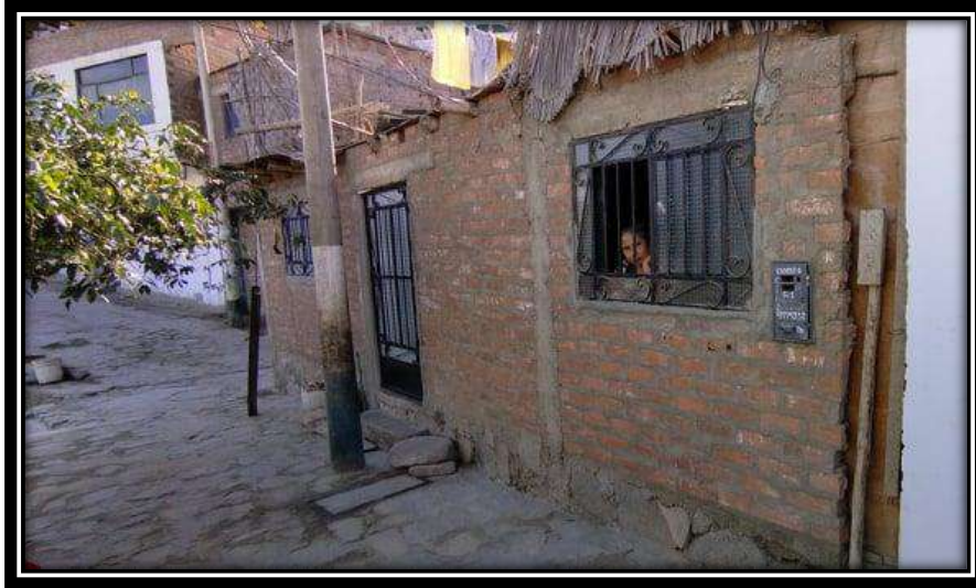
Figura 25: fachada de vivienda sin columna.
