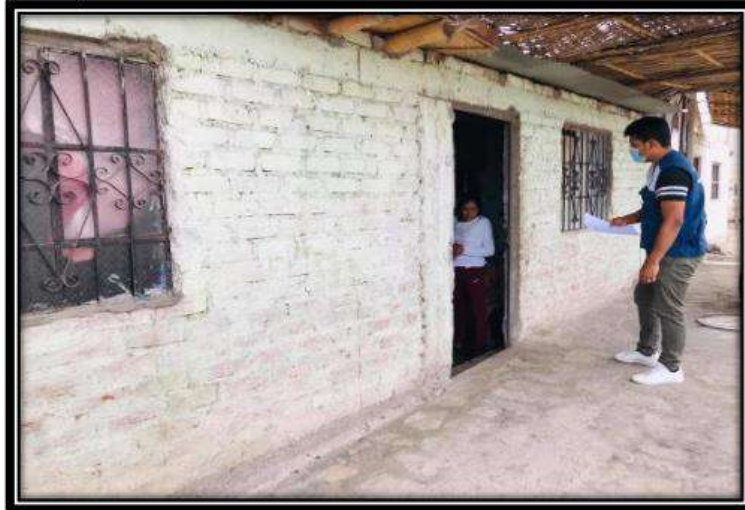
Imagen 01: Fachada de la vivienda B1 - 1
