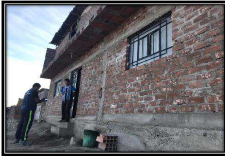
Imagen 01: Fachada de la vivienda B1 - I
