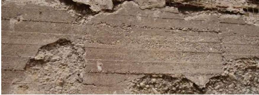
**Figura 25.** *Erosión del Concreto*
