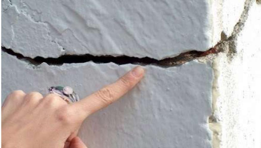
**Figura 7.** *Fisura en Muro de Albañilería*
