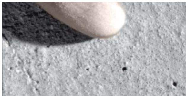
**Figura 24.** *Pulverización del Concreto*
