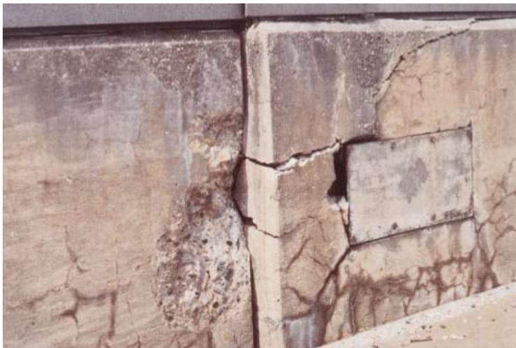
**Figura 15.** Desintegración de muro de albañilería
