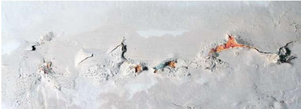
**Figura 21.** *Eflorescencia del Concreto*
