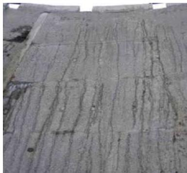
**Figura 22.** *Exudación del Concreto*
