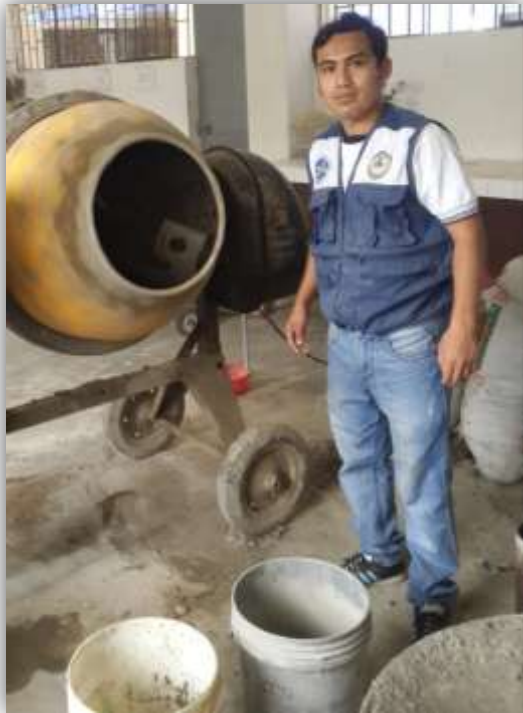
FIGURA N°35: Mezclando los materiales secos en trompo, luego se le agregó el agua.
