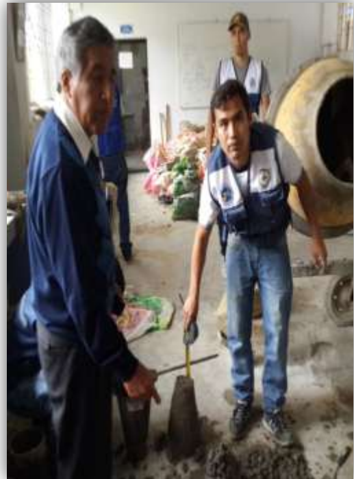
FIGURA N°36: Verificación de Asentamiento del Cono de Abrams bajo la Supervisión del Ing. Asesor. (Asentamiento= 3 pulg.)
