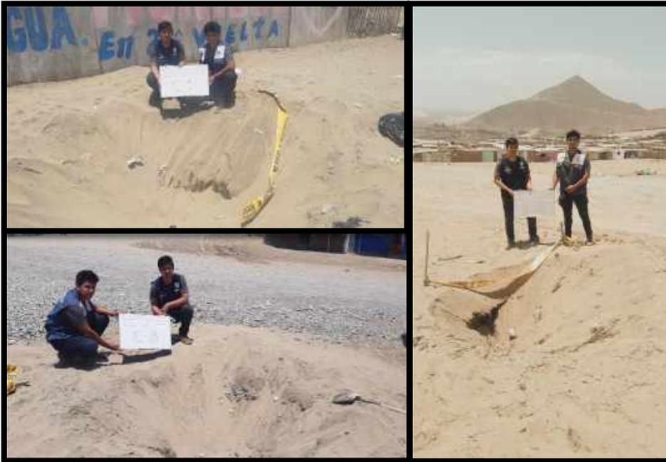
**Figura 15.** Procedí a realizar la Extracción de muestras de mis Calicatas, 3 Calicatas (C-1, C-2, C-3) para un Kilómetro L: 1m, A:1m, Prof: 1.50m (20 – 01 – 2020) – AA. HH Jesús de Nazaret, presencia del Ingeniero del Laboratorio de Suelos de la USP.
