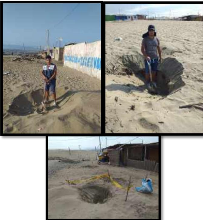
**Figura 14.** Procedí a realizar la Excavación de mis Calicatas, 3 Calicatas (C-1, C-2, C-3) para un Kilómetro L: 1m, A:1m, Prof: 1.50m (19 – 01 – 2020) – AA. HH Jesús de Nazaret
