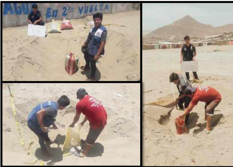
**Figura 16.** Procedí a realizar la Extracción de muestras de mis Calicatas (3 Sacos por cada Calicata), 3 Calicatas (C-1, C-2, C-3) para un Kilómetro L: 1m, A:1m, Prof: 1.50m (20 – 01 – 2020) – AA. HH Jesús de Nazaret, presencia del Ingeniero del Laboratorio de Suelos de la USP.
