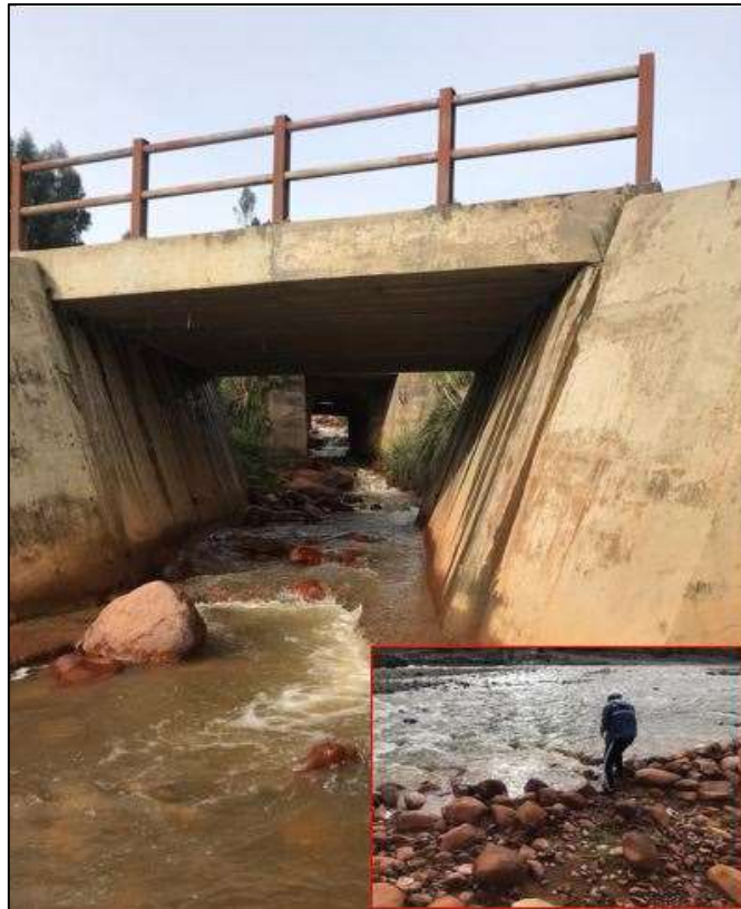
Figura 13. Zona de recolección de muestras de aguas del río Santa, cercanías del puente Simmer, Recuay.
