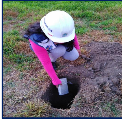
FIGURA N°69: INGRESO DE LOS ADOQUINES A LA ZANJA
