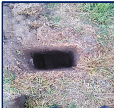
FIGURA N°68: ZANJA PARA LA COLOCACION DE LOS ADOQUINES
