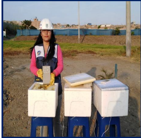
FIGURA N°63: COLOCACIÓN DE MUESTRAS
