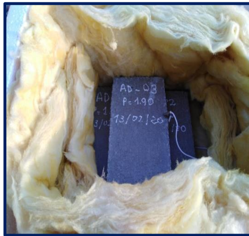
FIGURA N°64: COLOCACION DEL SENSOR EN EL ADOQUIN DE CONCRETO
