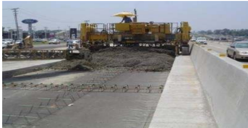
Figura N° 04: Proceso constructivo de un pavimento de concreto simple
