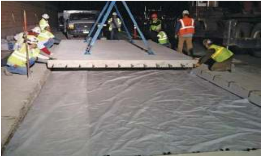
Figura N° 08: Losas prefabricadas en sistemas de pavimento rígido convencional o con pre tensionamiento
