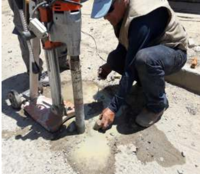
Extraccion de prueba de concreto (DIAMANTINA 3)
