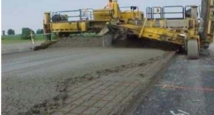
Figura N a 06: Proceso constructivo de pavimento de hormigón armado con acero y juntas.
