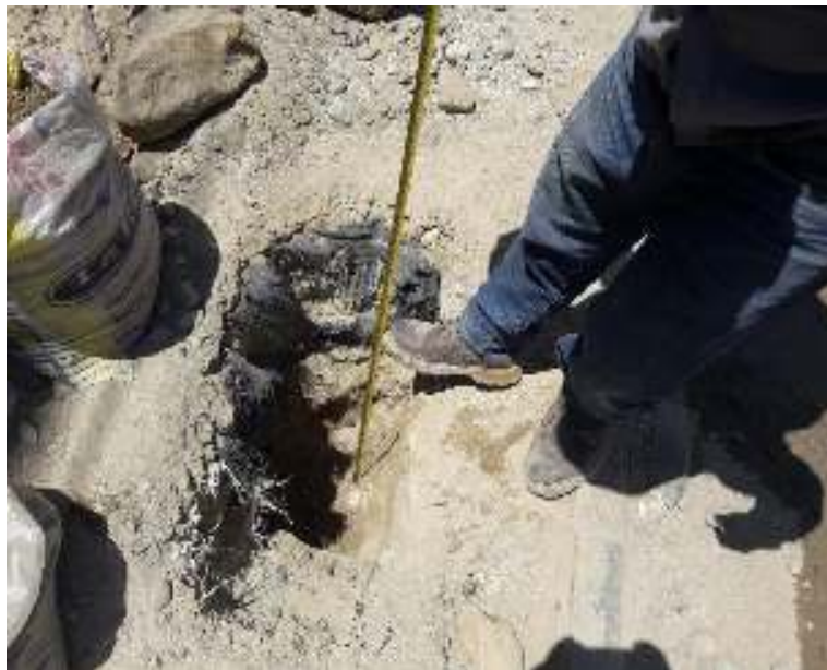
Muestra de suelo (Calicata)
