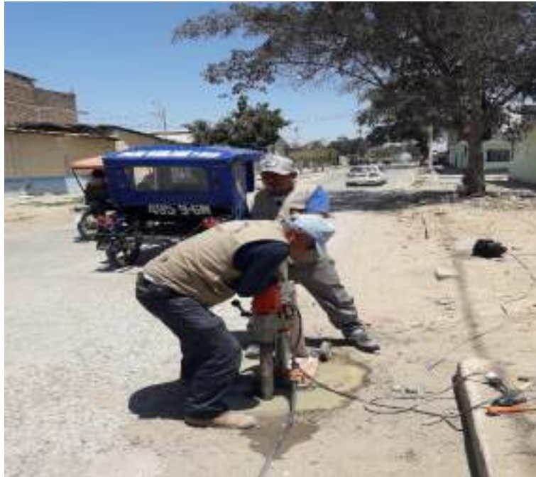
Extraccion de prueba de concreto (DIAMANTINA 1)
