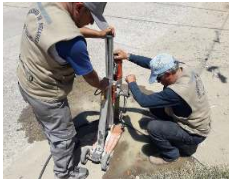
Extraccion de prueba de concreto (DIAMANTINA 2)
