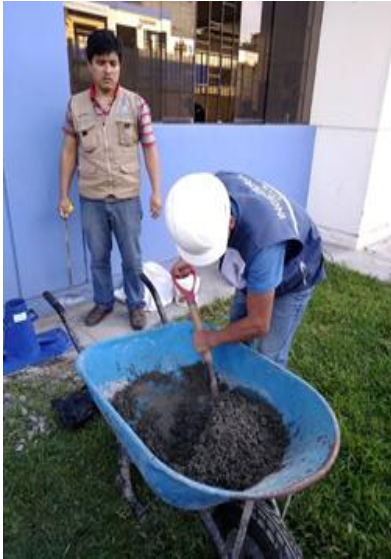
FIGURA N°27: Mezclando los materiales secos
