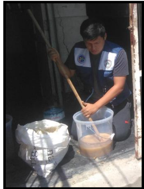
Figura 22. Disolvemos la arcilla con ayuda del palo de madera.
