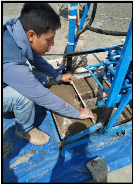
Figura 41. Después de la primera vibración se procede a retirar los excesos de mezcla de los bordes superiores del molde.
