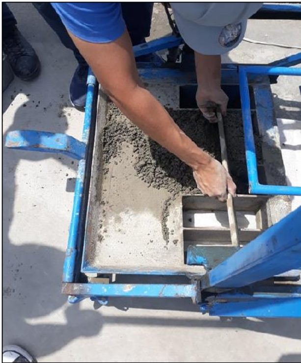
FIGURA N°13: Rellenando con la mezcla los moldes debido al asentamiento de la primera mezcla por el vibrado. Enrasado de los moldes.
