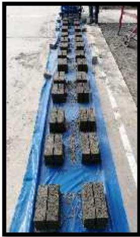
Figura 42: Se fabrico los ladrillos patrones empleando una maquina ladrilla
