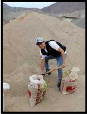
Figura 08: Obtención de agregado fino de la cantera
