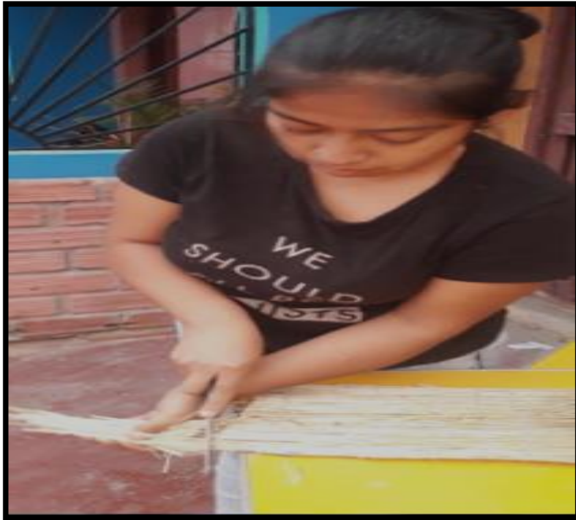
Figura 26. Habilitación del Stipa ichu a una longitud de 10cm para piso y techo.
