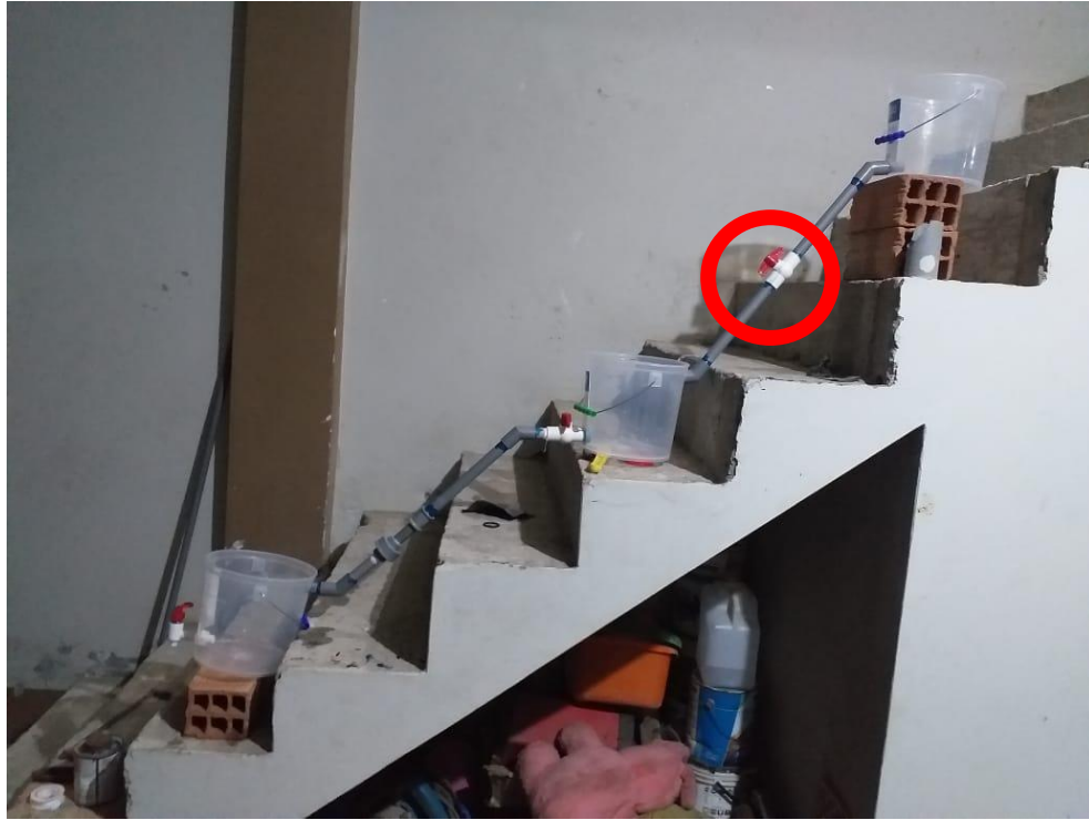
Figura 25. Llave de paso para controlar la entrada y salida de agua.
