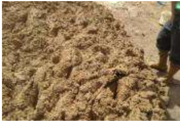
Figura 27. Pisado de la mezcla homogénea para hacerla más compacta.
