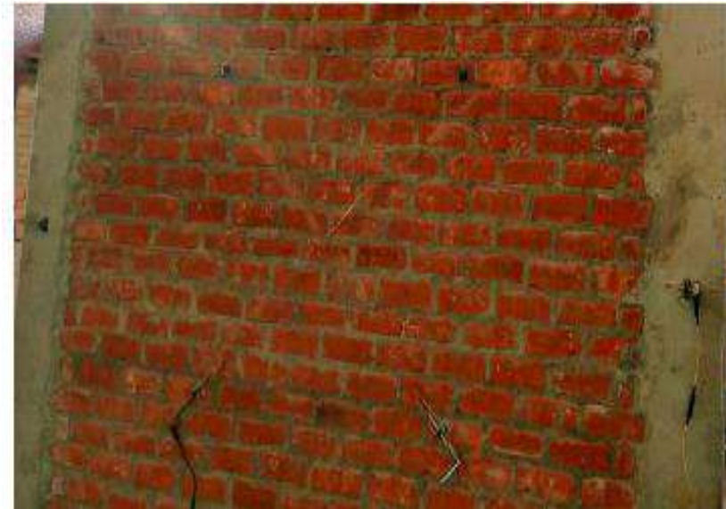
Figura 70.- Sensores en el muro de albañilería.
