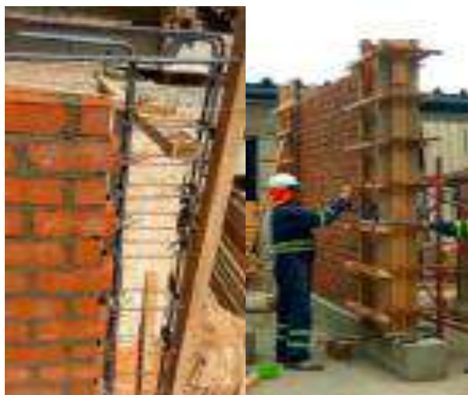
Figura 61. Verificación de refuerzos, estribos y encofrado de las columnas
