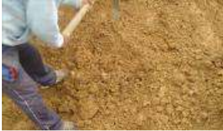
Figura 24. Tendido de material arcilloso.
