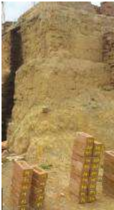
Figura 34. Toma de muestra de las unidades de albañilería.
