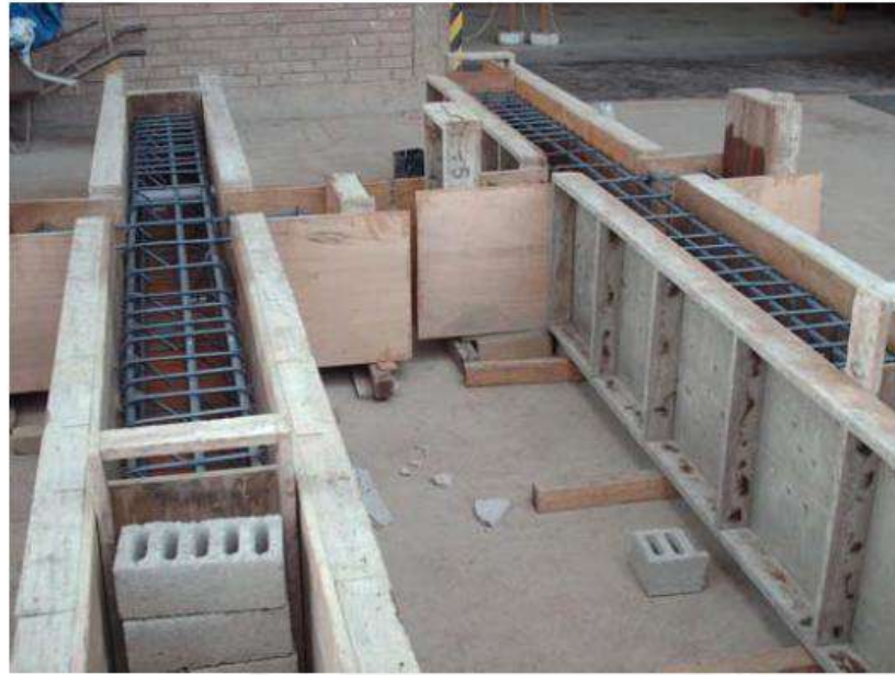
Figura 54. Habilitación del refuerzo y Encofrado de las Vigas de Cimentación
