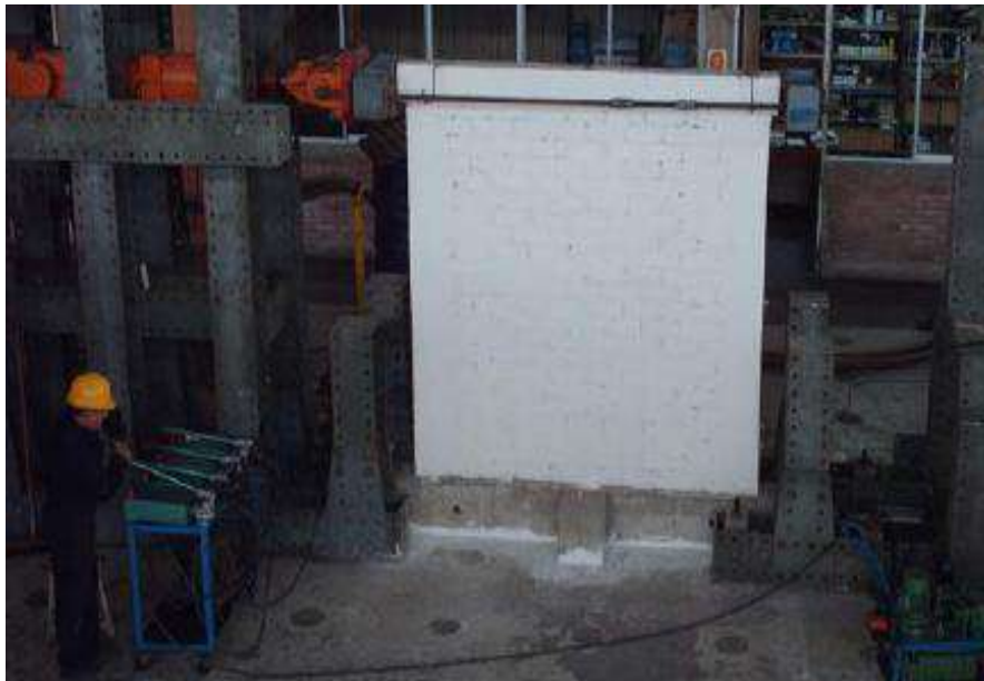
Figura 65.- Montaje e Instrumentación.
