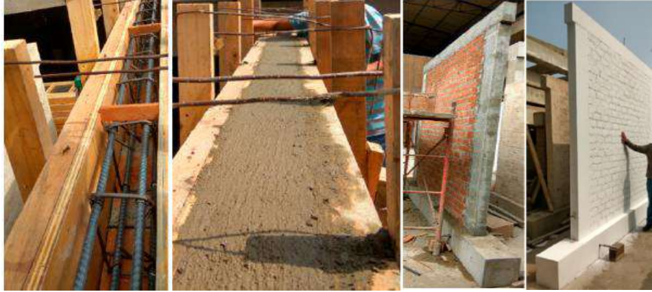
Figura 62.- Encofrado, vaciado, desencofrado de viga solera y muro listo para ser ensayado.
