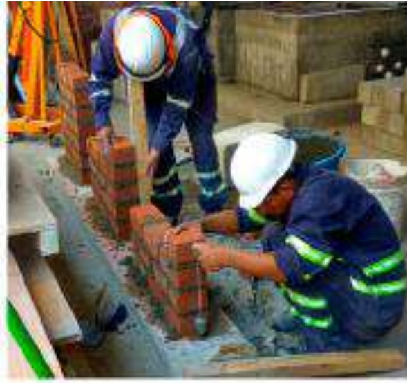
Figura 48. Construcción de muretes.
