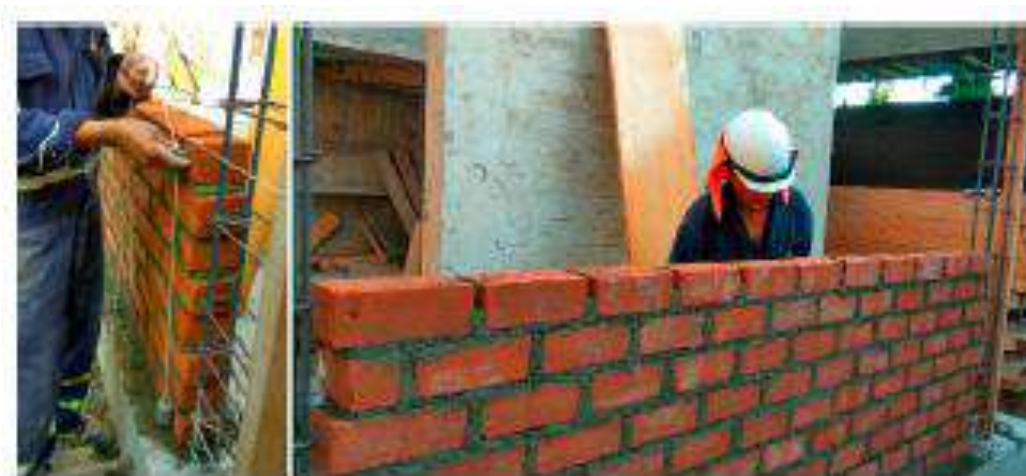
Figura 60. Control de verticalidad y primera jornada del muro.
