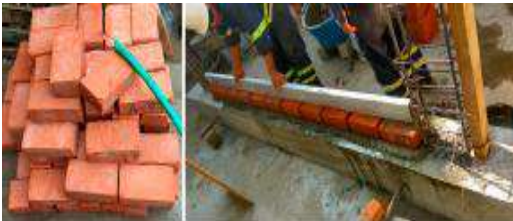
Figura 59. Regado y colocación de escantillón de albañilería.
