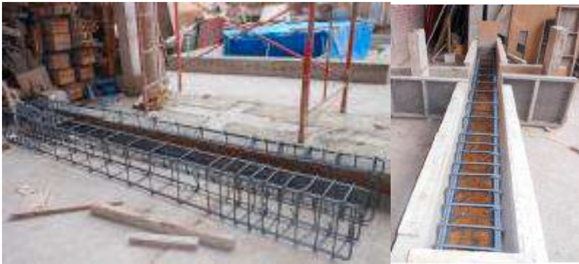
Figura 55. Habilitación y encofrado de Viga de Cimentación
