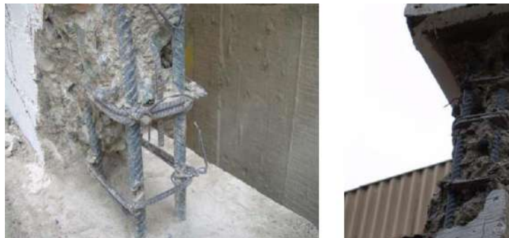
Figura 73.- Acero de refuerzo vertical.
