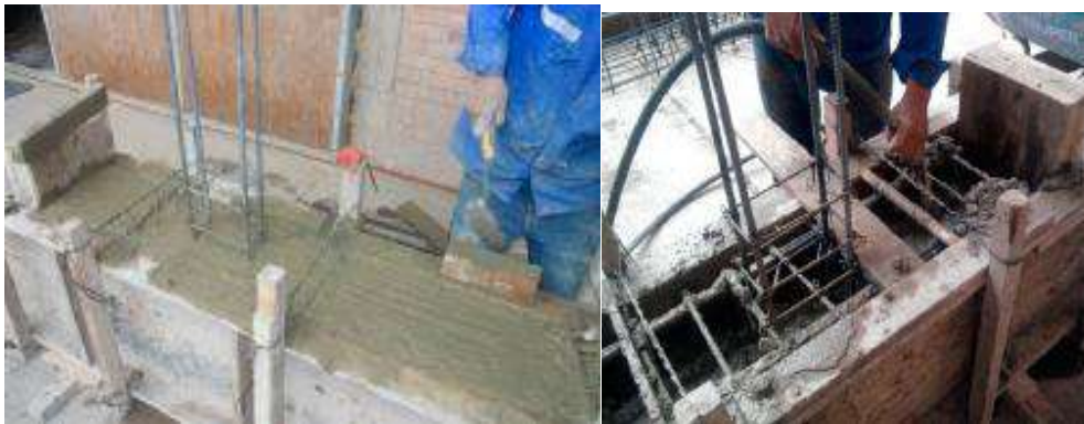
Figura 57. Vibrado y Alisado de Concreto Fresco
