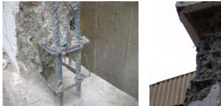
Figura 21.- Acero de refuerzo vertical.
