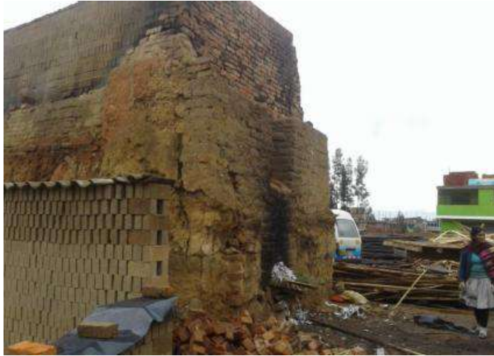
Figura 33. Horno hecho de arcilla.
