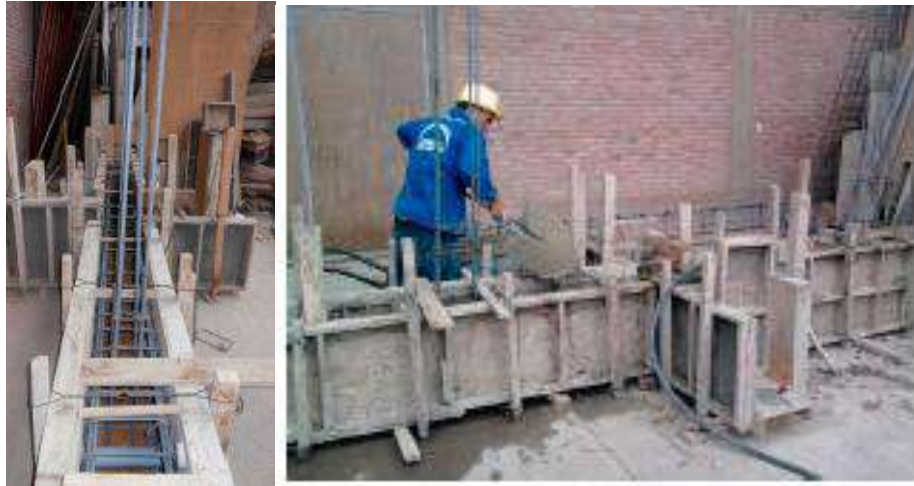
Figura 56. Colocación Acero de Columnas y Vaciado en Viga de Cimentación.
