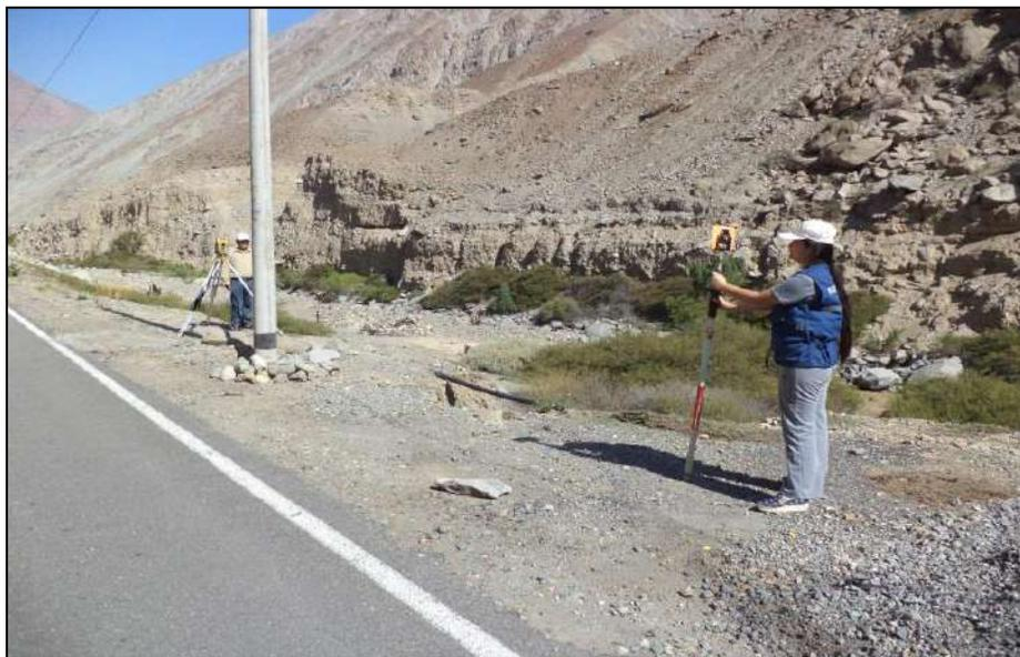
**Figura.** Toma de cotas en postes, terreno natural y pista.
