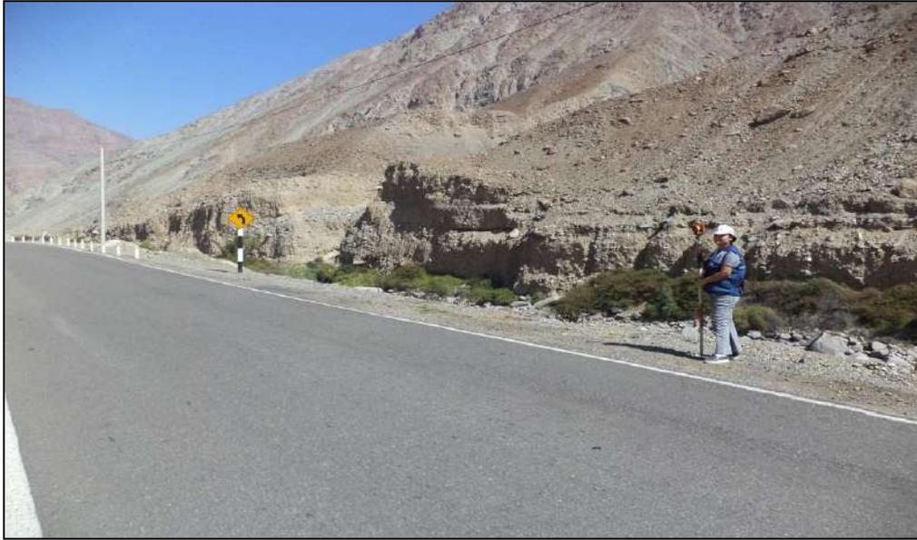
*Figura.* Toma de cotas en borde y centro de pista.
