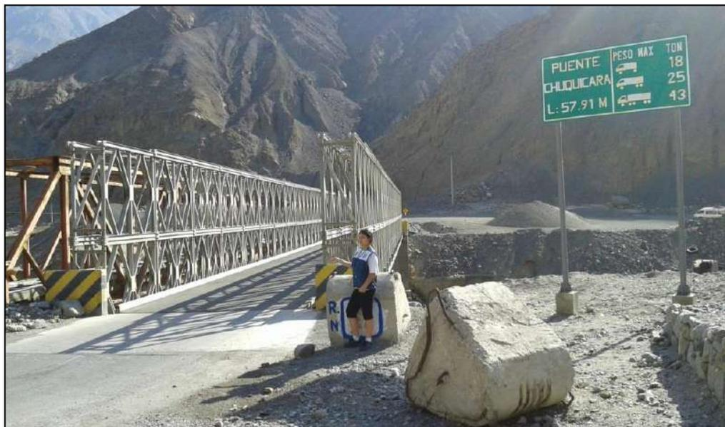
*Figura.* Vista del puente nuevo tipo Bailey en Chuquicara, longitud 57.91 m.
