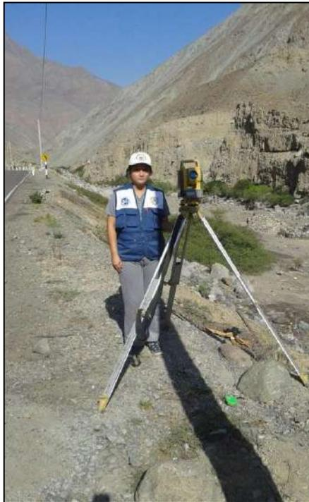
**Figura.** Primer estacionamiento de trípode y estación total, para toma de puntos.
