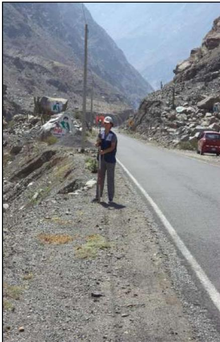
*Figura.* Toma de cotas en borde y centro de pista.
