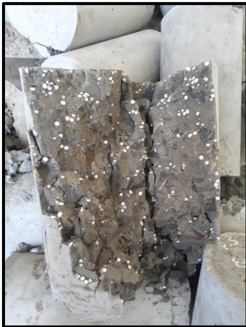
Figura N° 36: Concreto con las perlas de Tecnopor
