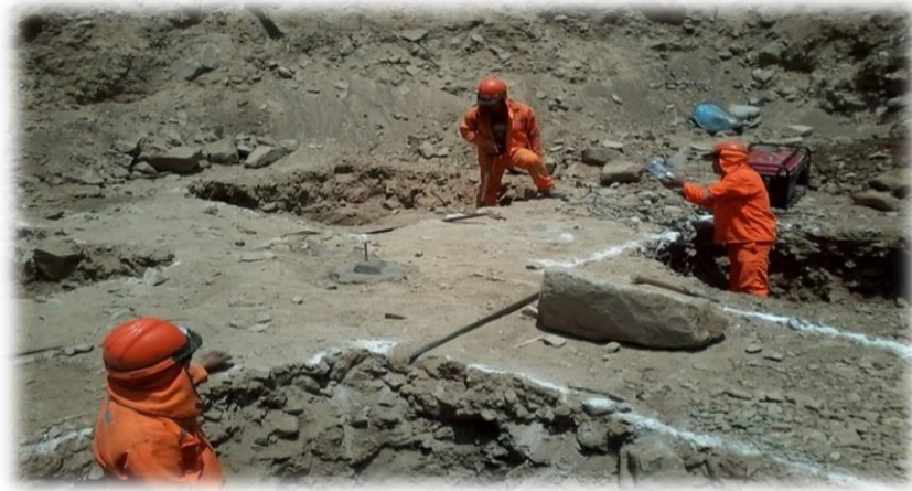
Figura N°50.- Excavación en suelo 1.
