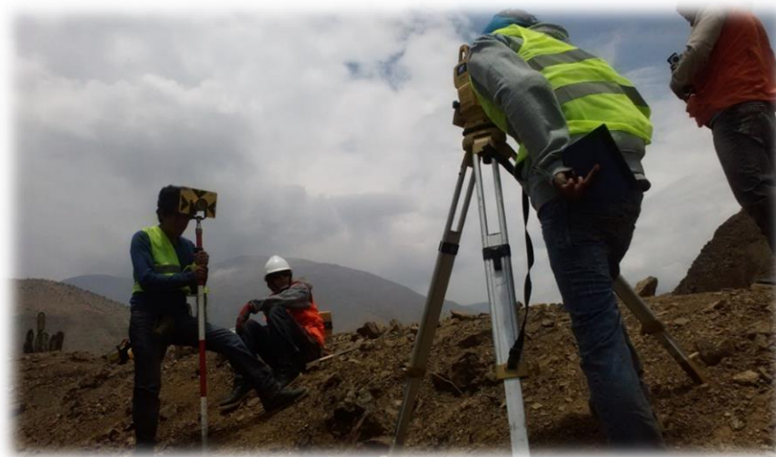
Figura N°48.- Seccionamiento Fuente: Linelcon.
