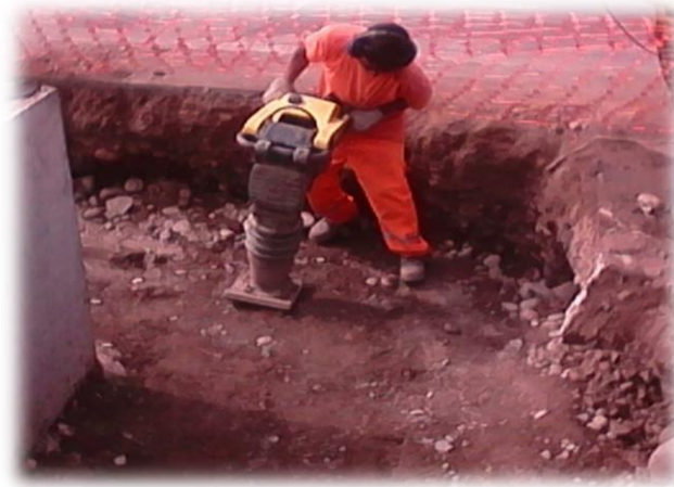
Figura N°63.- Relleno y compactación Fuente: Elaboración propia.
