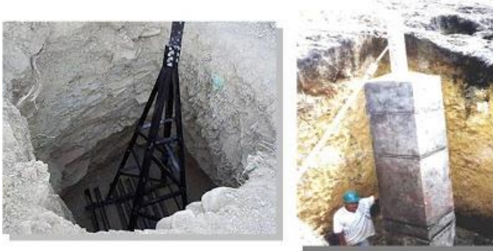
Figura 23.- Fundación en parrilla y zapata respectivamente.
