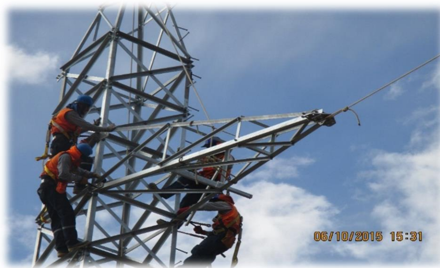
Figura N°65.- Montaje de ménsulas de torre
