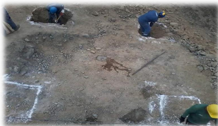
Figura N°51.- Excavación en roca fracturada.
