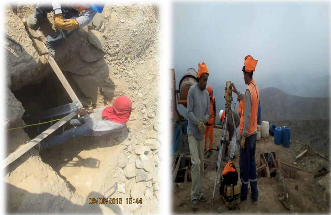
Nivelación y control de stub (propio).
