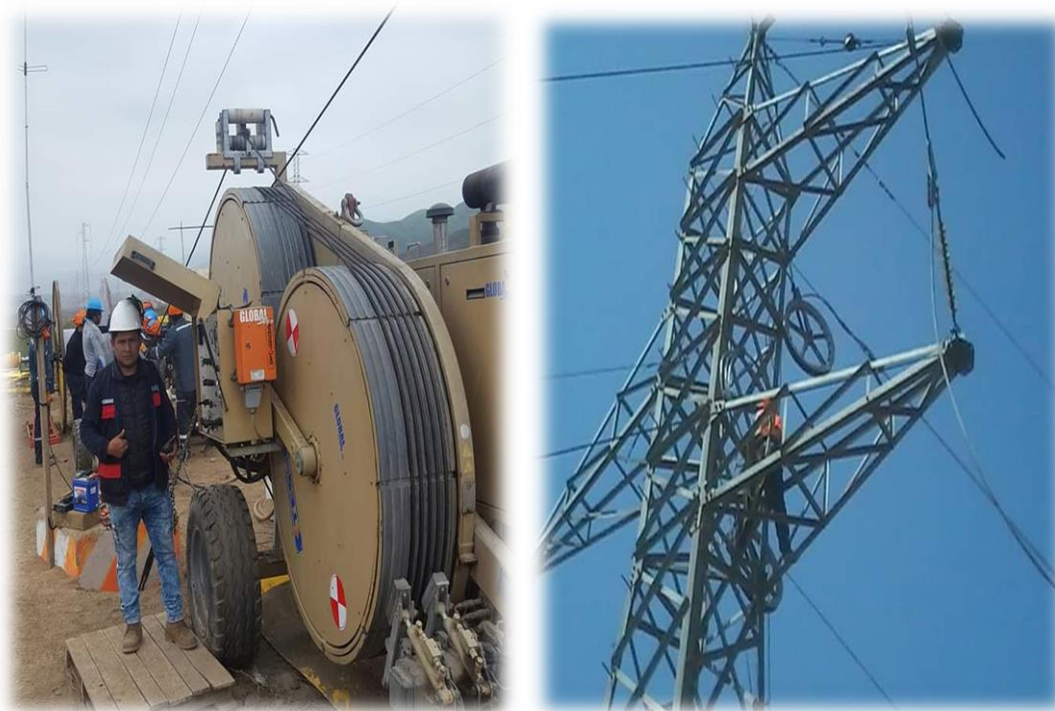
Winche, freno y tendido de conductor (propio).
