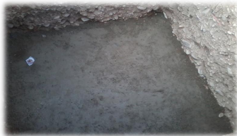
Figura N54.- Colocación de solado.
