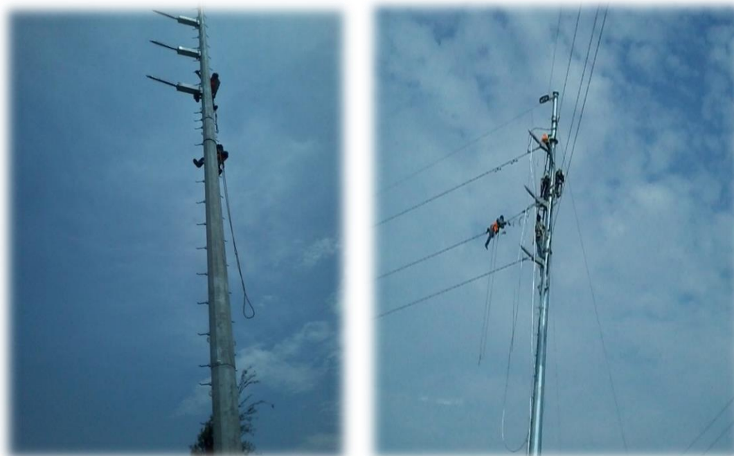
Tendido de conductor en postes tubulares de la línea de transmisión (propio).
