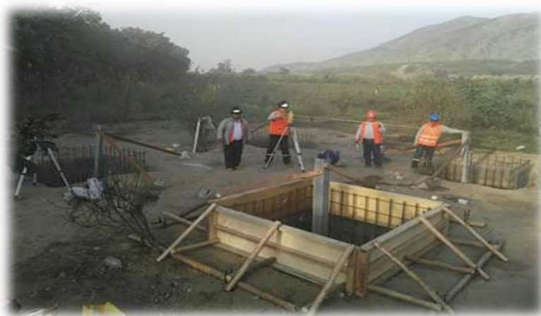
Figura N°55.- Nivelación de STUBS Fuente: Elaboración propia.
