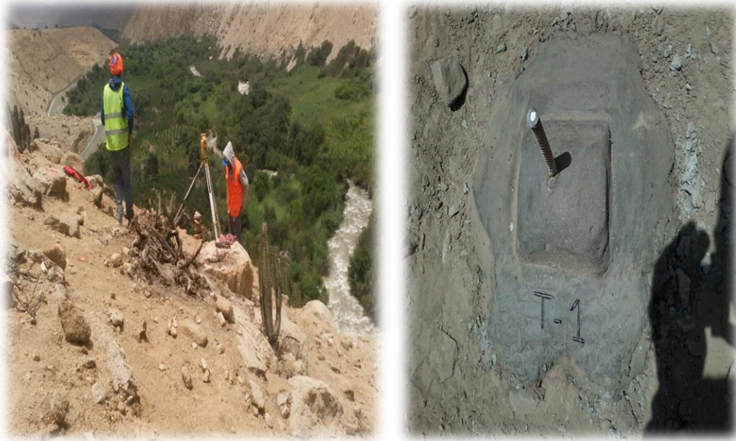
Replanteo y colocación de hitos ejes de torres (propio).
