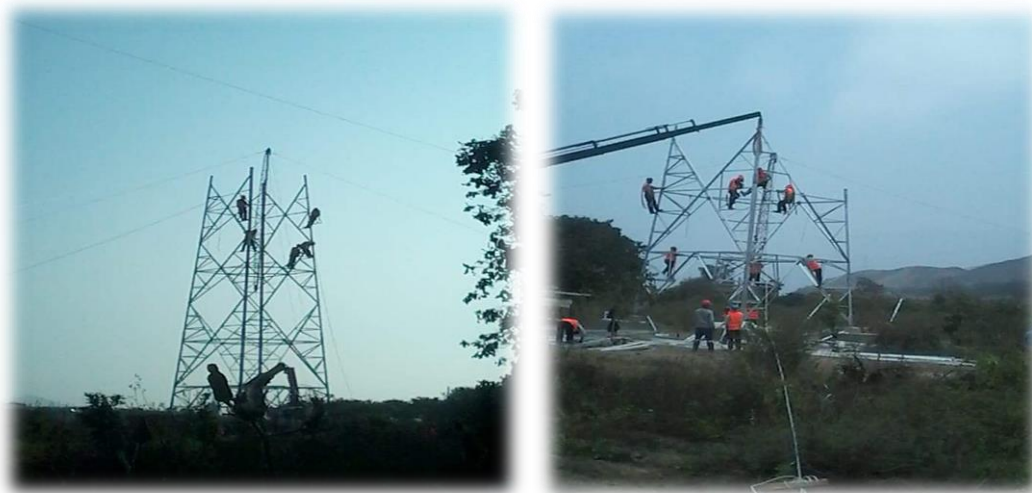
Figura N°64 (a). (b).- Ensamblado y montaje de torre
