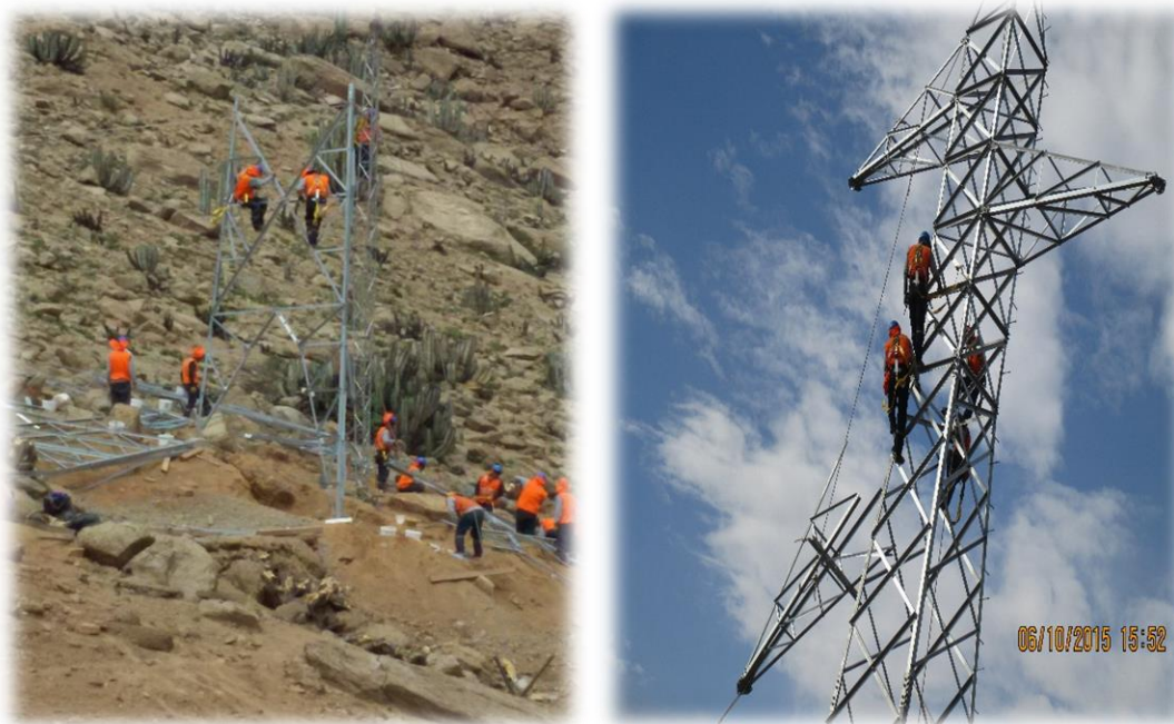
Ensamble y montaje de torres (propio).
