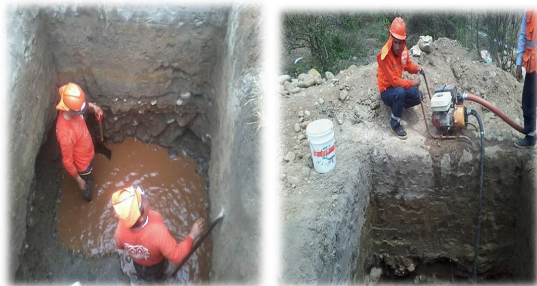
Figura N°52.- Excavación en terreno saturado.
