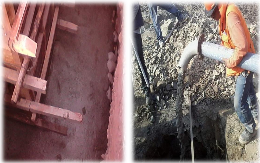
Concreto en fundaciones (propio).
