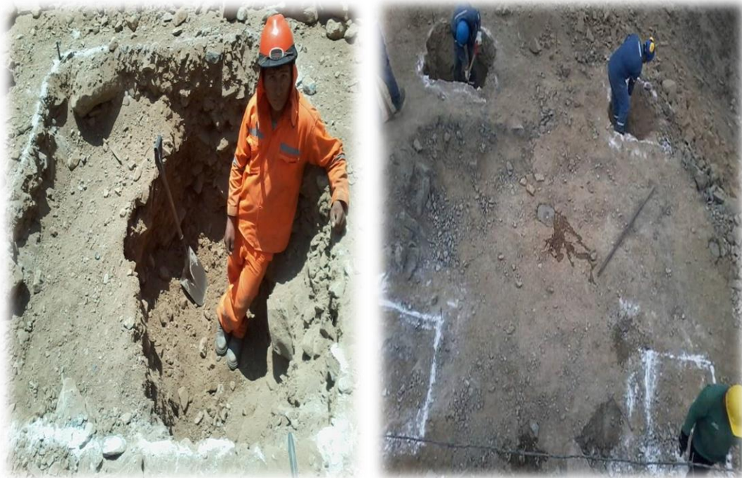
Marcación y excavación para cimentaciones (propio).
