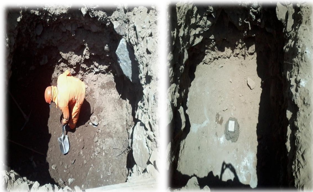
Perfilado de fondo y bloqueteo para stub (propio).
