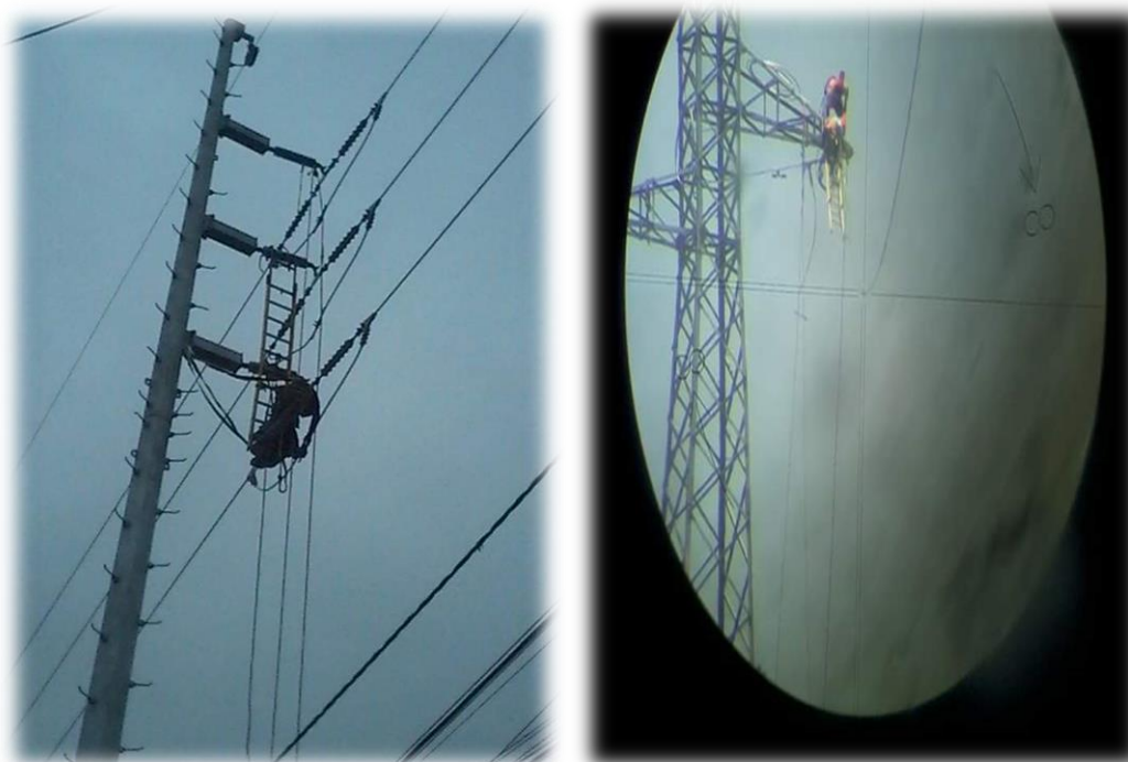
Flechado del conductor (propio)
