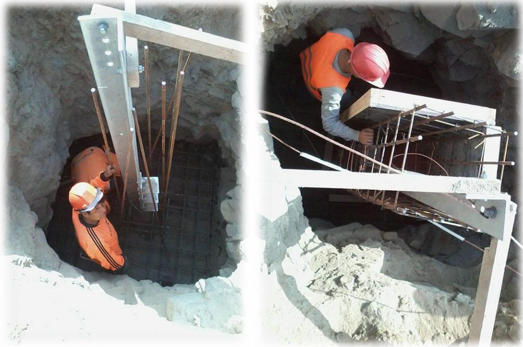
Acero, PAT, y encofrado zapata y pedestal (propio).
