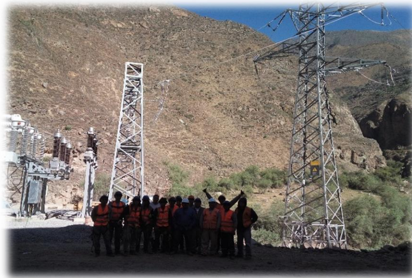
Figura 35.- Central Hidroeléctrica Chancay Fuente: Elaboración propia.
