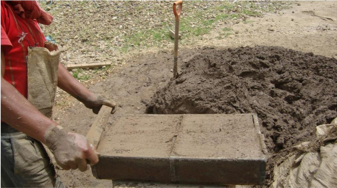
Figura N°12: Enrazado de la mezcla de arcilla.
