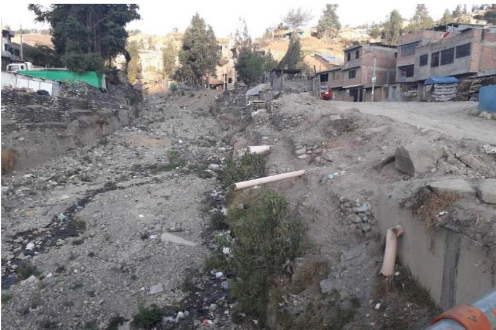
Figura 9. Se observa que las casas aledañas vierten sus aguas servidas a la quebrada río Seco margen izquierdo
