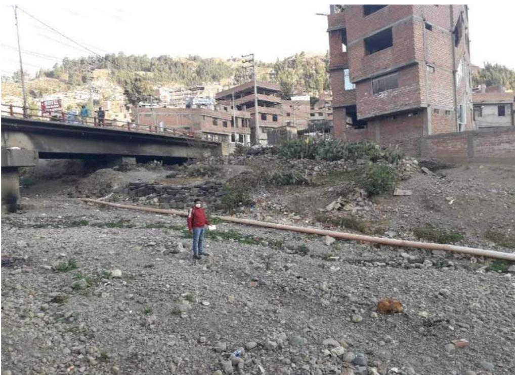
Figura 5. Estado de la quebrada río seco, altura del Puente Tacllan, se observa la exposición de tuberías de alcantarillado.
