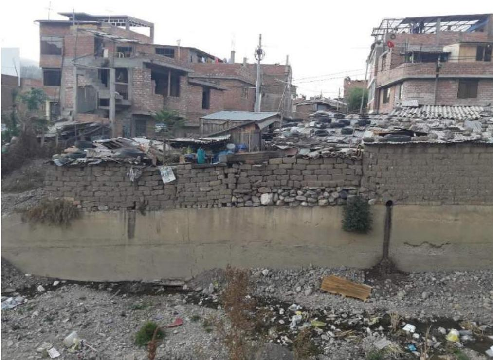
Figura 8. Se observa que las casas aledañas vierten sus aguas servidas a la quebrada río Seco margen derecho
