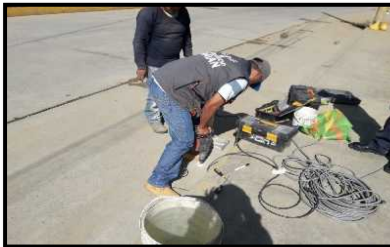
FIGURA 24: SE OBSERVA LA INSTALACION DEL EQUIPO DE DIAMANTINA EN LA AV. 28 DE JULIO DE LA PROVINCIA DE YUNGAY FUENTE: EL AUTOR
