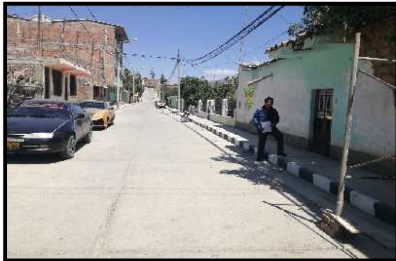
FIGURA 18: SE OBSERVA EL PAVIMENTO RÍGIDO Y VEREDAS DEL JR.2 DE JULIO FUENTE: EL AUTOR
