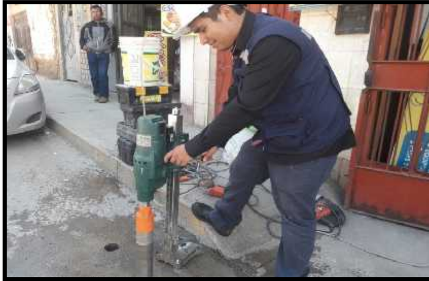
FIGURA 27: SE OBSERVA A MI PERSONA REALIZANDO LA EXTRACCION CON EL EQUIPO DE DIAMANTINA FUENTE: EL AUTOR
