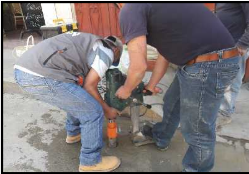
FIGURA 26: SE OBSERVA LA EXTRACCION DE MUESTRA EN EL SEGUNDO PUNTO DE LA AV. ARIAS GRAZZINI NORTE FUENTE: EL AUTOR
