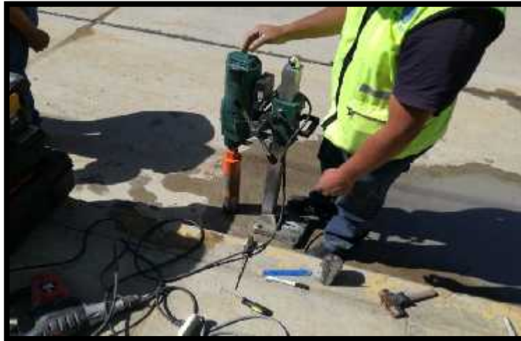
FIGURA 11: EXTRACCION CON EL EQUIPO DE DIAMANTINA FUENTE: EL AUTOR
