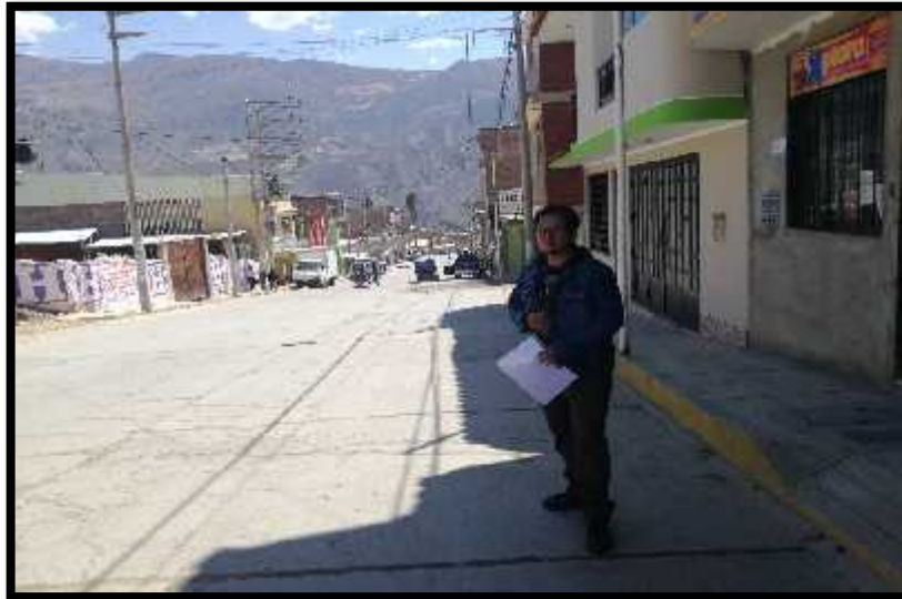
FIGURA 19: VISTA DEL TIPO DE FALLA LOSA DIVIDIDA Y GRIETA LINEAL RESPECTIVA EN AV.28 DE JULIO FUENTE: EL AUTOR
