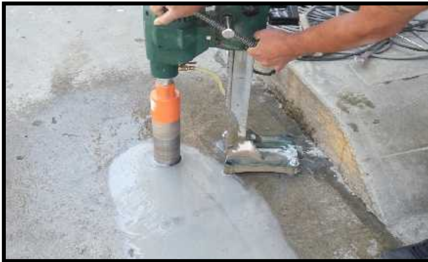
FIGURA 32: SE OBSERVA LA EXTRACCION CON EL EQUIPO DE DIAMANTINA FUENTE: EL AUTOR
