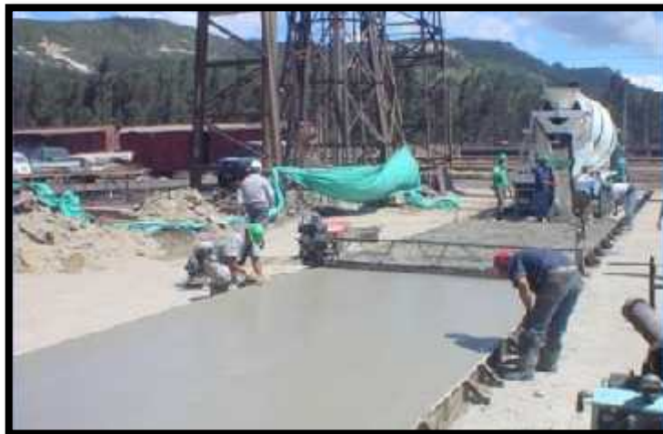
FIGURA 04: CONSTRUCCION DE UN PAVIMENTO RIGIDO FUENTE: JAVIER M (2010)- Deterioro en pavimentos rígidos y flexibles
