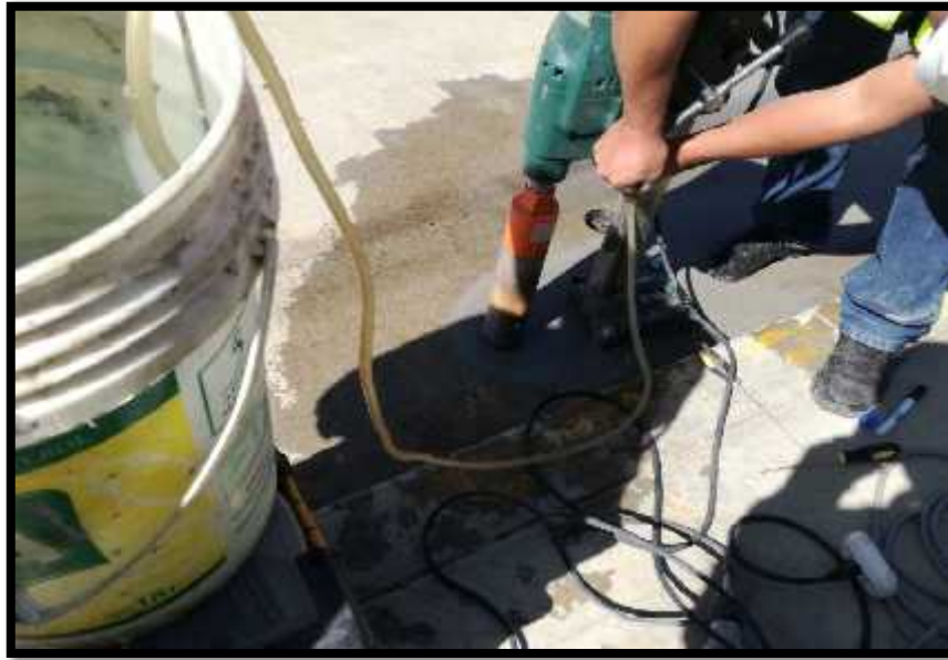
FIGURA 29: SE OBSERVA LA EXTRACCION CON EL EQUIPO DE DIAMANTINA FUENTE: EL AUTOR
