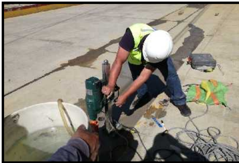
FIGURA 30: SE OBSERVA LOS PROCESOS DE EXTRACCION CON EL EQUIPO DE DIAMANTINA FUENTE: EL AUTOR
