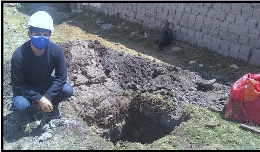
Figura 20 Muestreo mediante la excavación a cielo abierto de la calicata C-1
