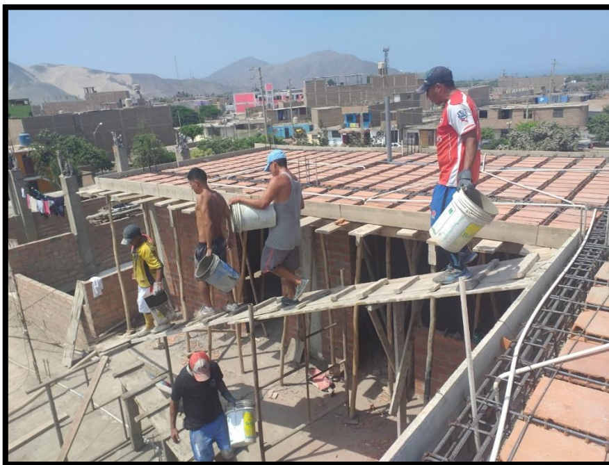
Figura 28: Llenado de losa aligerada sin EPP. Fuente. Fotografía, Cristina Ruiz.
