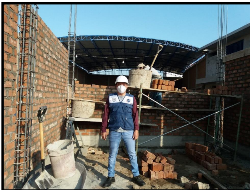
Figura 30: Inspección de andamios. Fuente. Fotografía, Danicsa Avalos.
