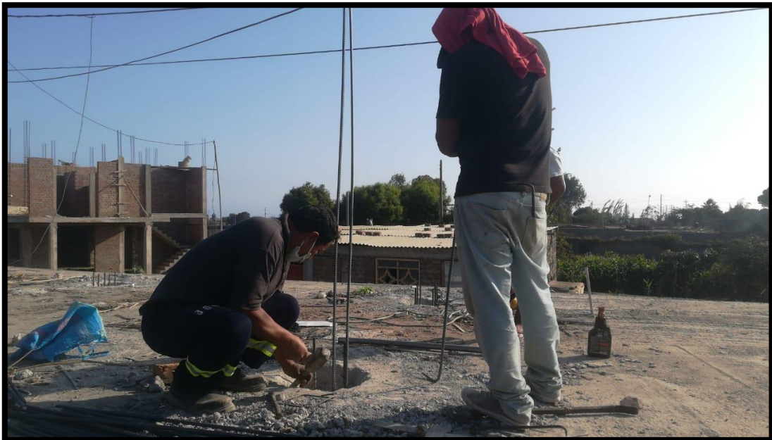
Figura 24: Colocación de varillas de acero Fuente. Fotografía, Luiggi Hurtado.
