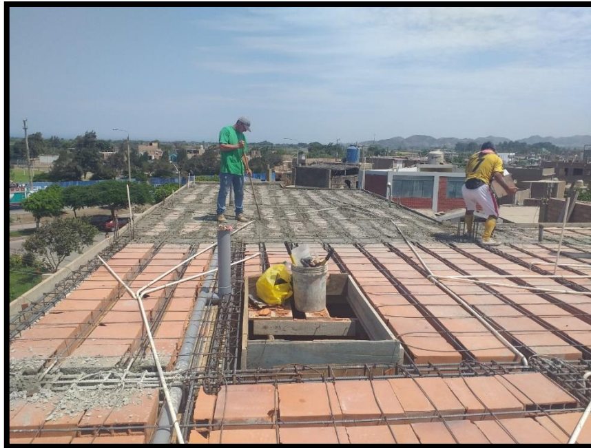
Figura 27: Trabajos en alturas. Fuente. Fotografía, Cristina Ruiz.
