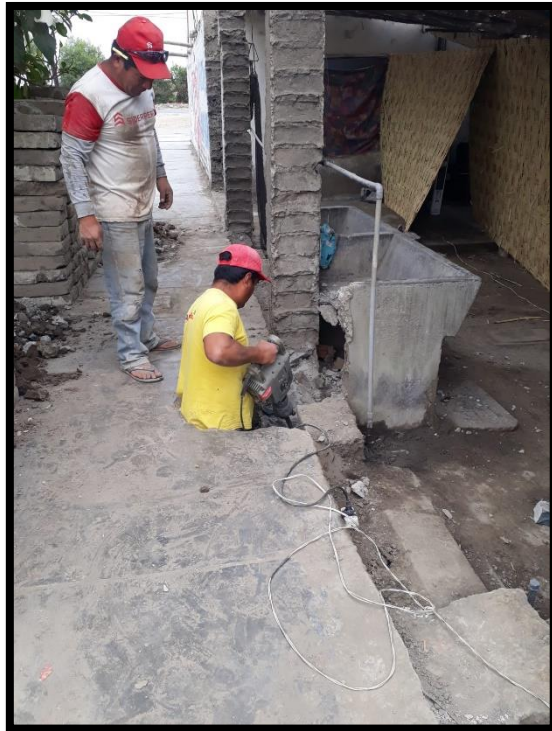
Figura 33: Excavación de zanja en espacios reducidos. Fuente. Fotografía, Luisa Juarez.
