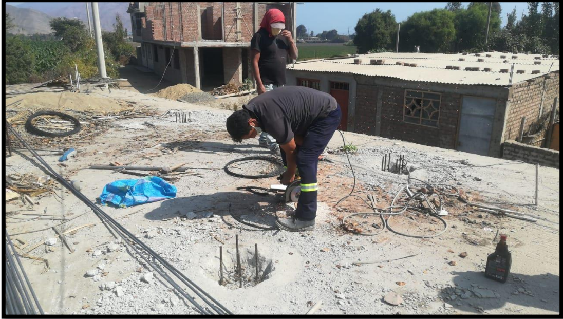
Figura 23: Corte de acero. Fuente. Fotografía, Luiggi Hurtado.
