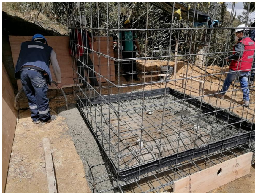
Figura 10: Reservorio sector Progreso la Toma (actualmente en reconstrucción)
