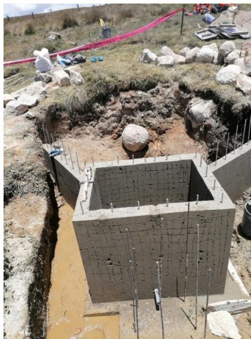
Figura 02 y 03: Captación de agua sector Progreso la Toma (actualmente en reconstrucción – estado de riesgo)
