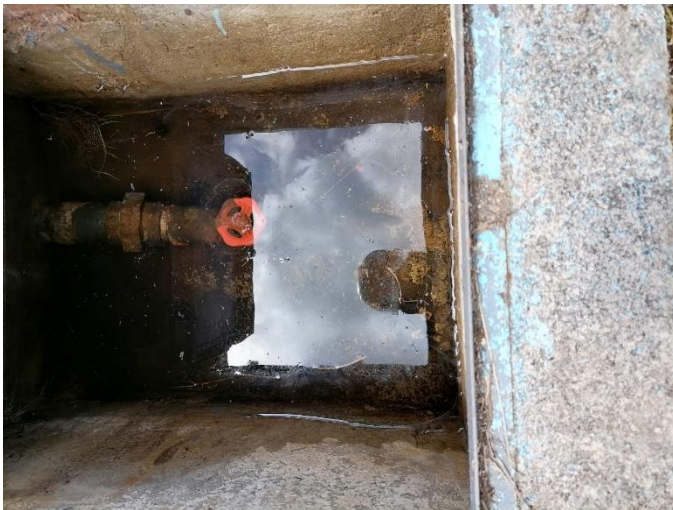
Figura 05 Y 06: Llaves de registro y cámara húmeda (reboce y tubería de salida) de la captación de agua del sector Tuyupampa (estado de riesgo)
