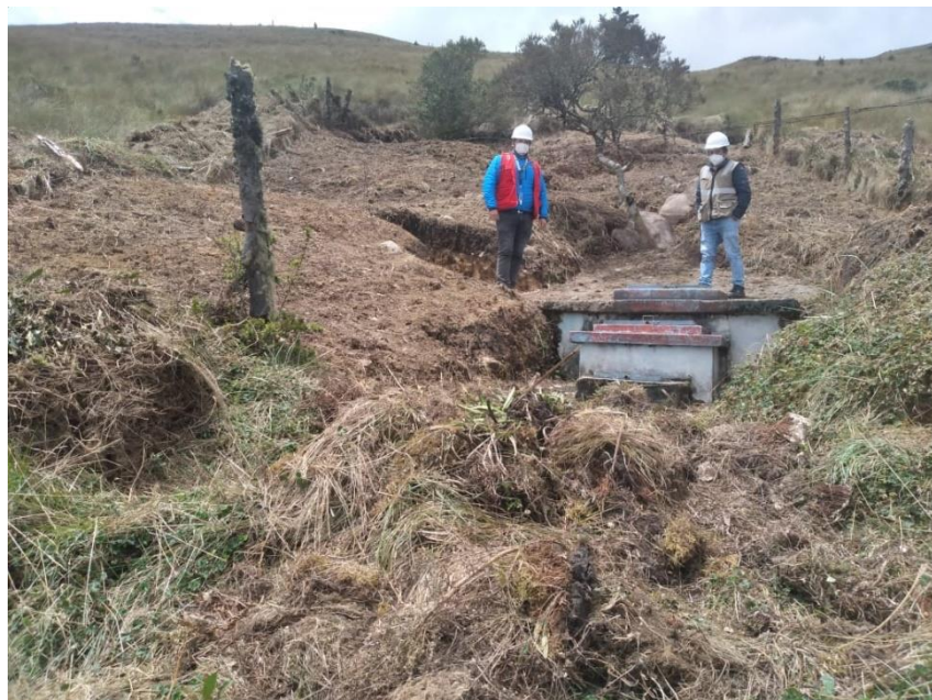
Figura 01: Captación de agua de Chim chim (estado bueno)
