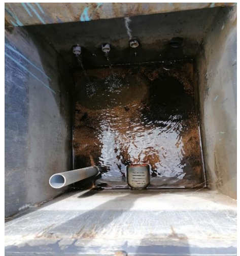
Figura 05 Y 06: Llaves de registro y cámara húmeda (reboce y tubería de salida) de la captación de agua del sector Tuyupampa (estado de riesgo)
