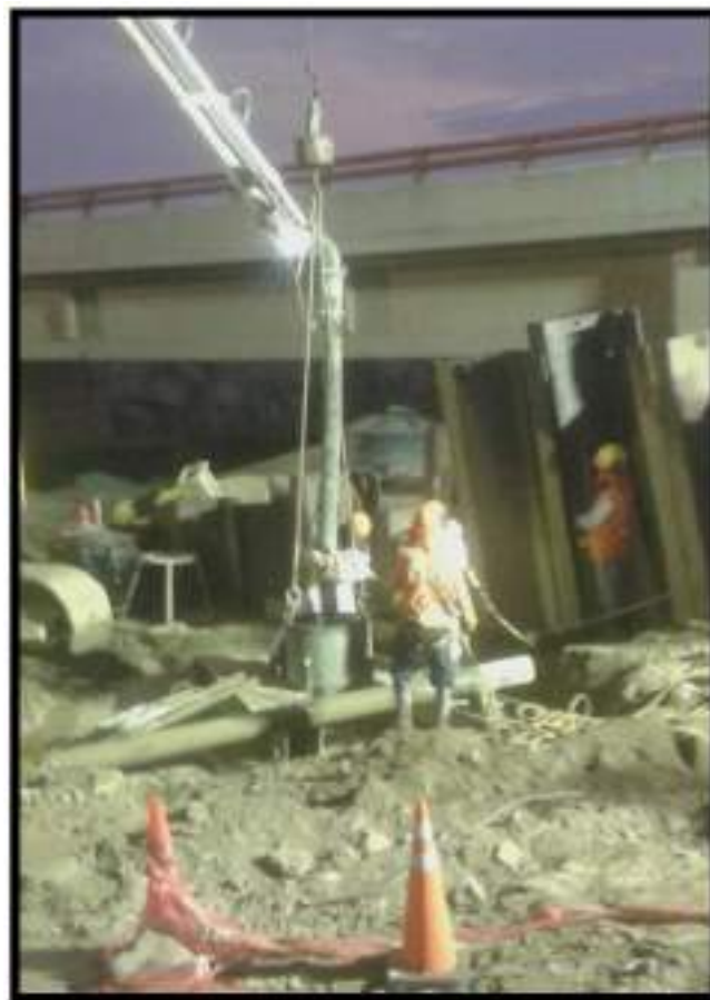
Fotografía N°03: Izaje y colocación de la armadura del pilote.
