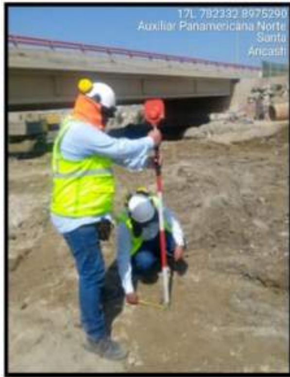
Fotografía N°05: Verificando la ubicación de los pilotes construidos, ante un posible desplazamiento durante su ejecución.
