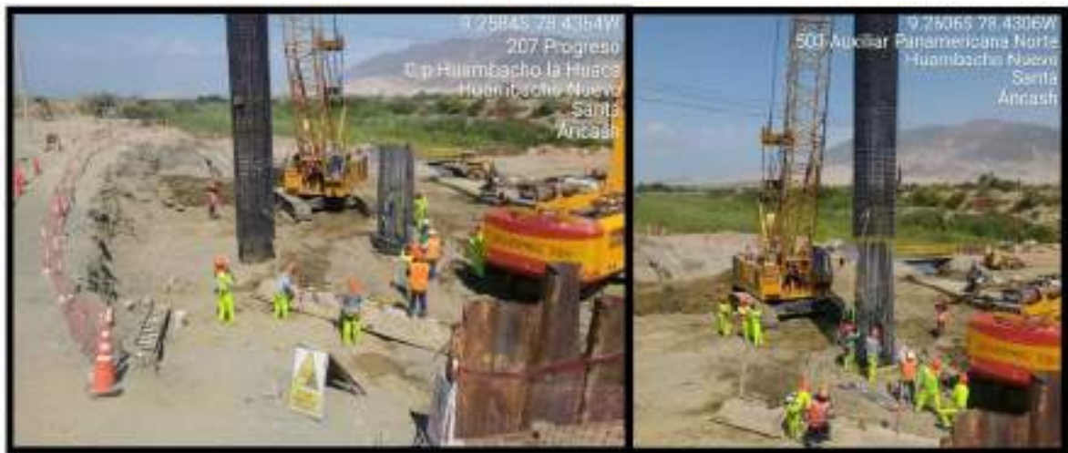
Fotografía N°03: Izaje y colocación de la armadura del pilote.
