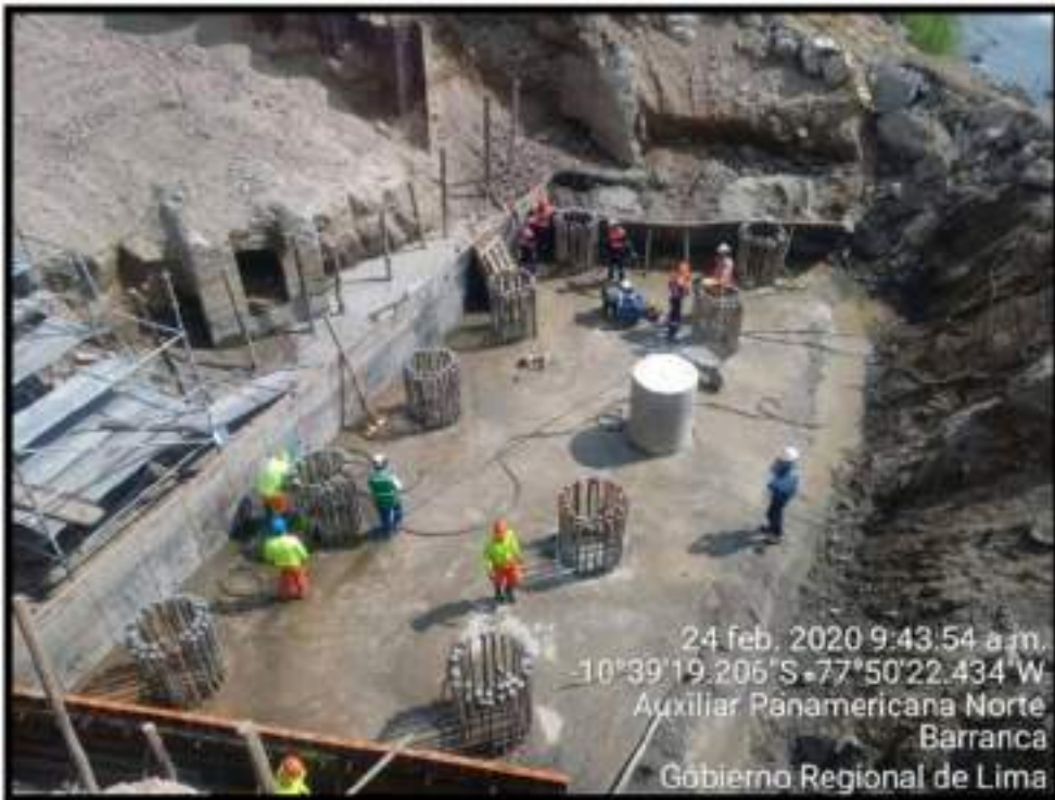
Fotografía N°04: Pilotes descabezados y fuste (concreto f'c=280 kg/cm 2 ) del pilote preparado para realizar la prueba de carga dinámica.
