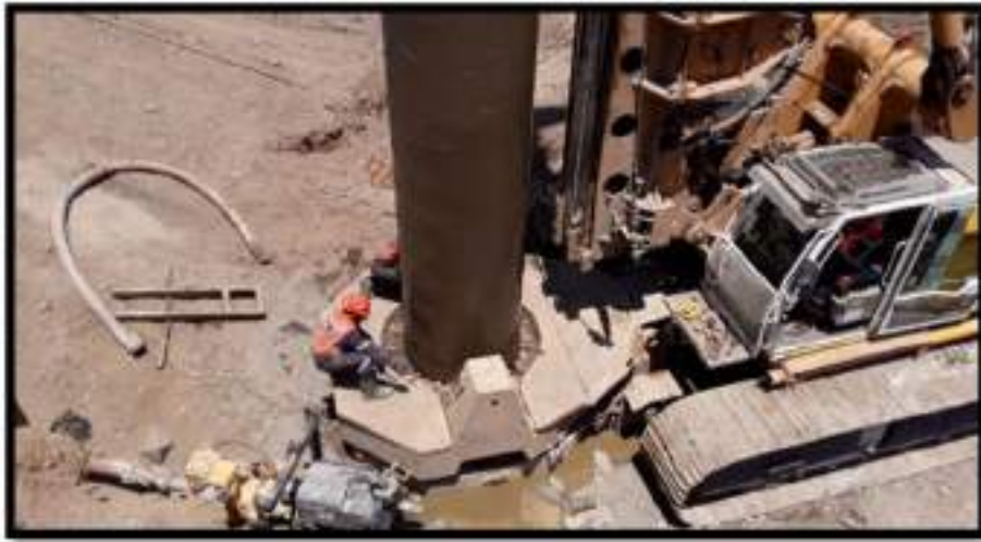
Fotografía N°01: Perforación de pilotes con pilotera Bauer BG 14 (Empresa TERRATEST).
