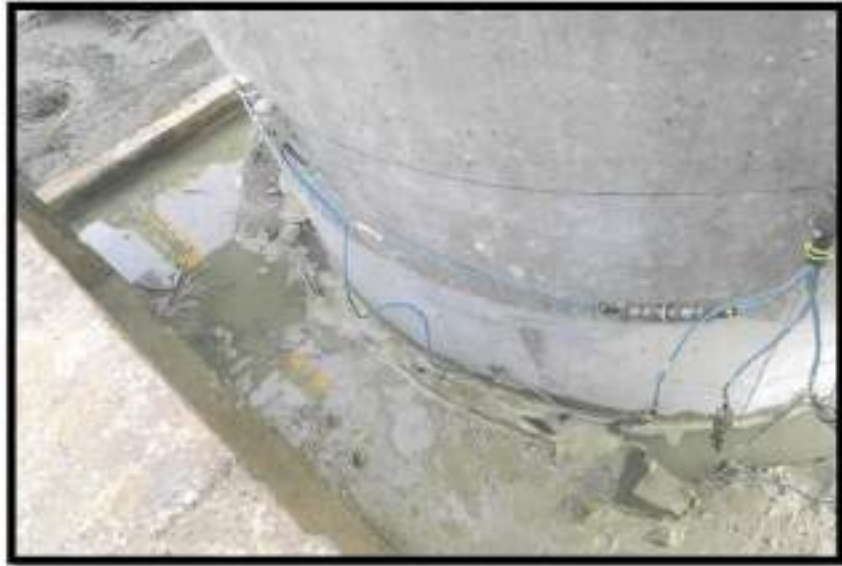
Fotografía N°07: Sensores colocados a 30 cm de la superficie del fuste, para tomar lectura de los resultados de la prueba de carga dinámica (astm d 4945).
