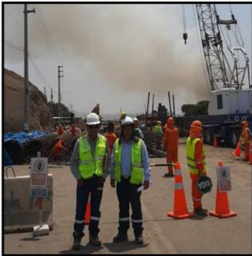
Fotografía N°02: Con el Especialista en puentes, estructuras de concreto y obras de arte de Autopista del Norte, verificando las armaduras de los pilotes.
