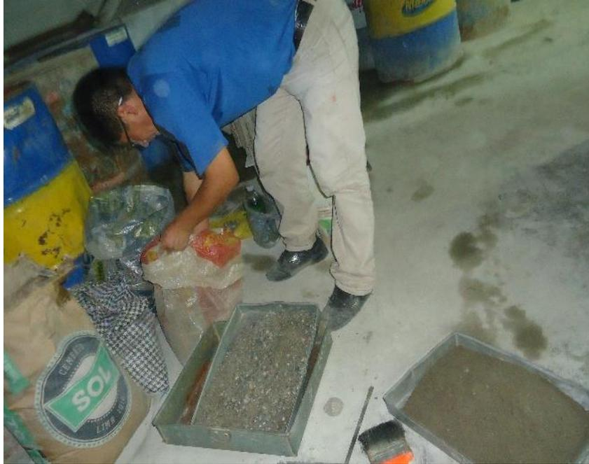
Figura 38. Preparación de los materiales para la mezcla del concreto para el adoquín
