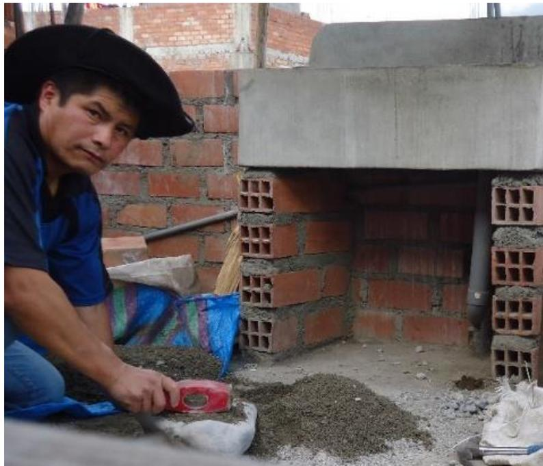
Figura 9. Trituración del residuo reciclado de demolición y construcción para convertirlo en agregado fino
