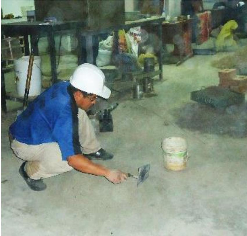
Figura 40. Mezclado de cemento y agua para elaboración de adoquines
