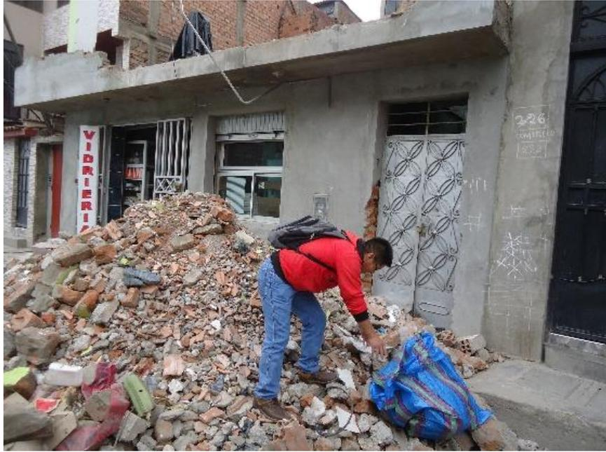
Figura 6. Recojo de residuos de construcción y demolición para usarlo como agregado
