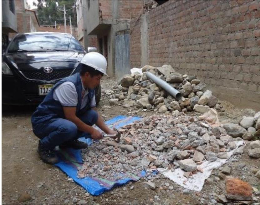
Figura 8. Proceso de trituración manual de los residuos de construcción y demolición
