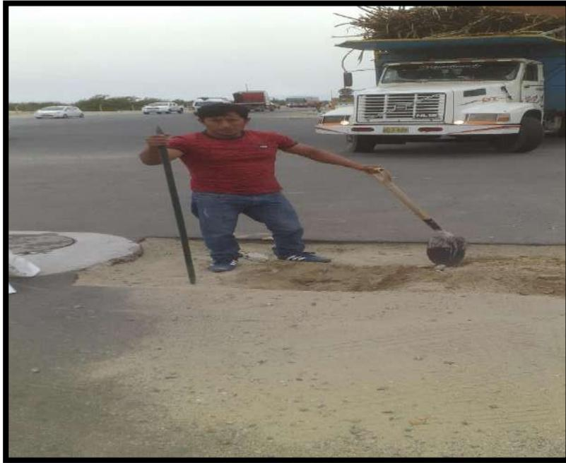
*Figura 9. Empezamos hacer la excavación de las calicatas*
