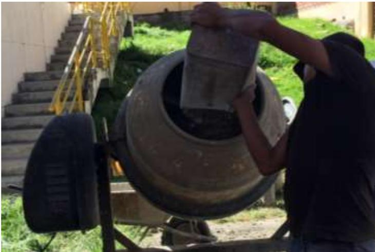
Figura 27. Baseado de agregado grueso a la mezcladora para su dosificación correspondiente.
