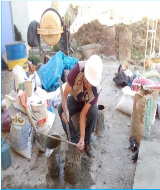
Figura 22 Medición de asentamiento.
