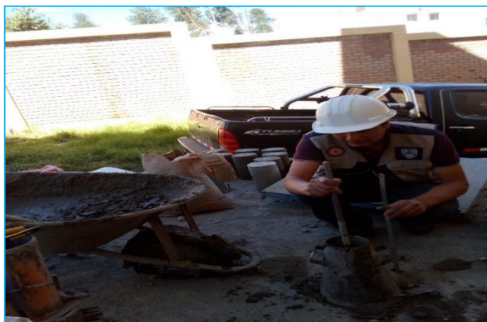
Figura N° 5: Se está midiendo la slump del concreto.
