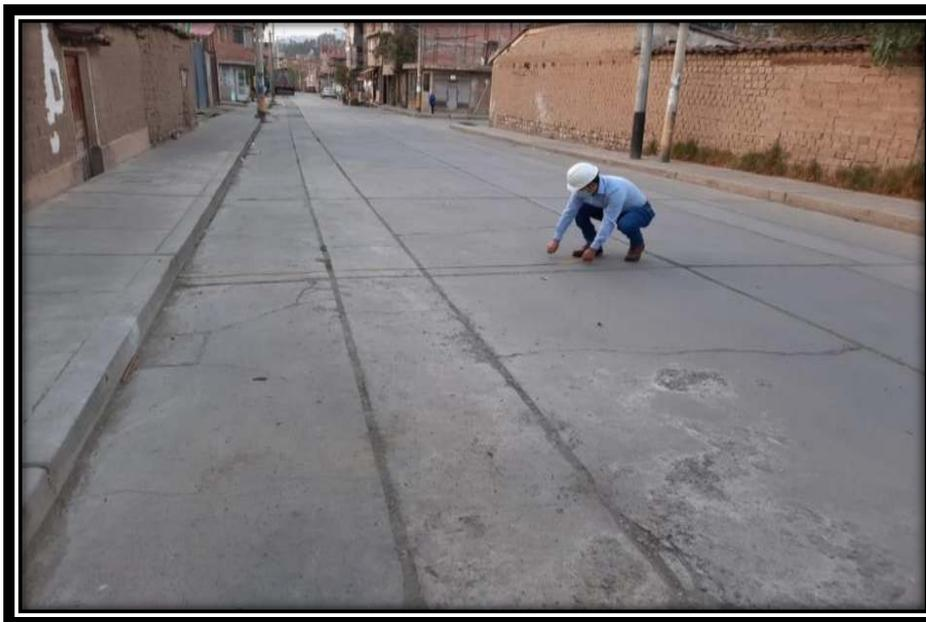
En esta imagen se puede apreciar la actividad que realizo, puesto a que tomamos medidas del paño del pavimento para luego proceder a identificar las patologías del pavimento rígido.
