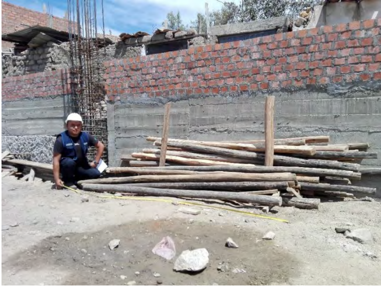
Figura 8. Inspeccionando la Edificación
