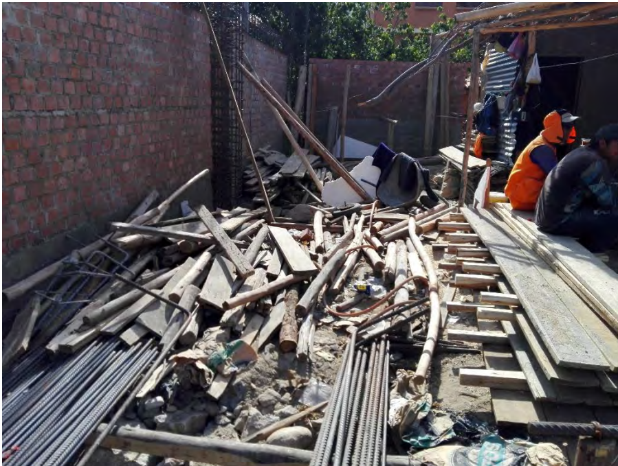
Figura 5. Materiales de construcción para el edificio
