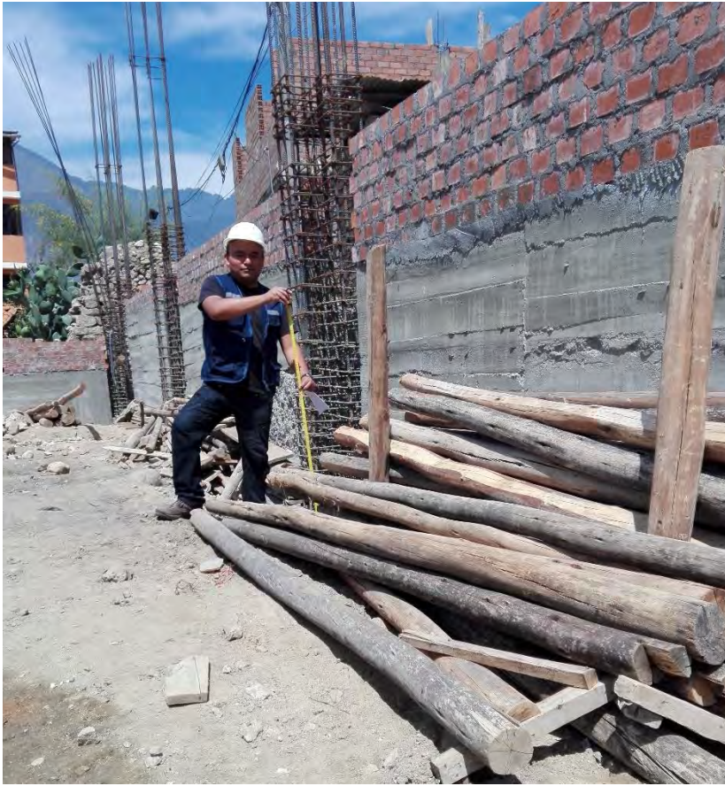
Figura 10. Medición de varillas para la Edificación
