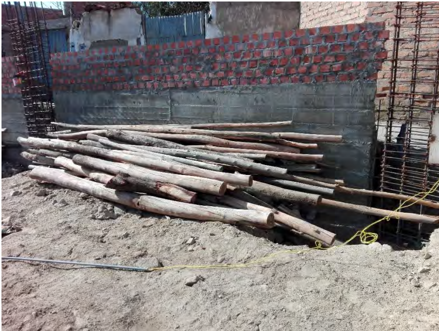
Figura 3. Madera en la obra de construcción
