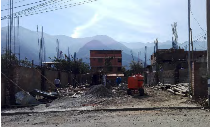
Figura 2. Residuos de construcción del edificio de dos niveles
