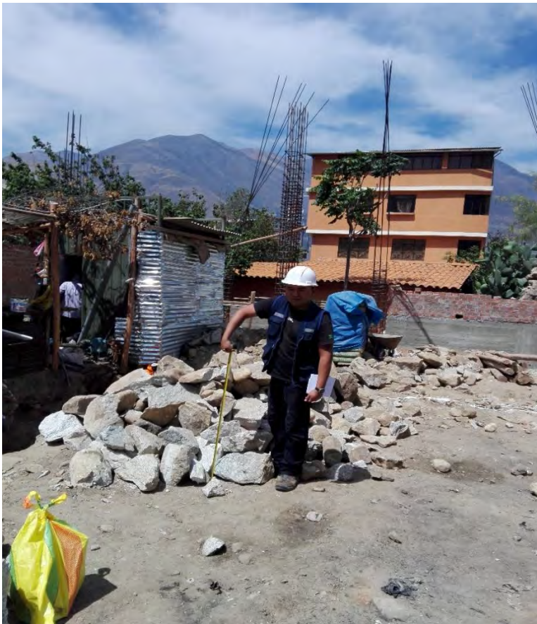
Figura 9. Verificando la construcción de la Edificación
