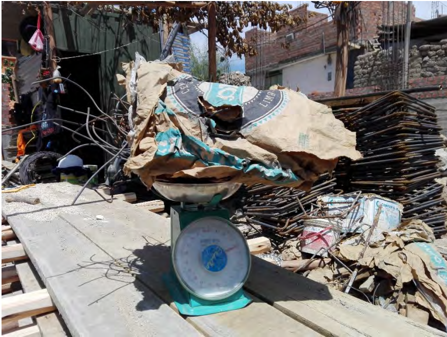
Figura 6. Pesado de los residuos generados en la ejecución de la obra
