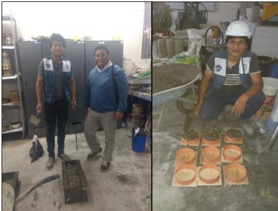
Figura 62: Colocación de la mezcla de concreto en el interior de los moldes. Fuente: El autor, 2020.
