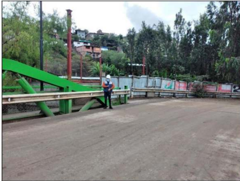
Figura N° 27. controlando el trafico puente chalaco.
