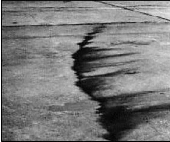
Figura N°18. Bombeo (pumping)
