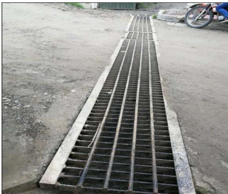
CALLE EL PUENTE ALCANTARILLA EN LA PROGRESIVA 0+047.63
