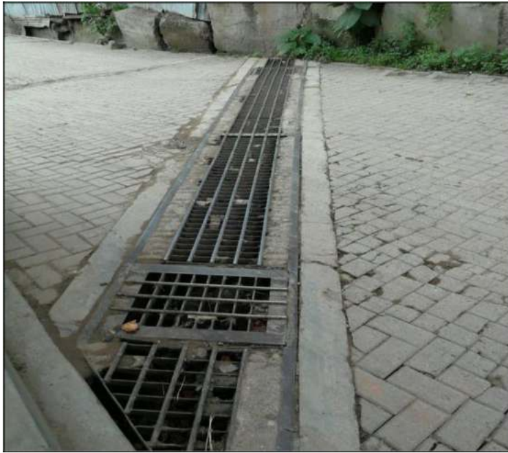
CALLE MORROPON ALCANTARILLA EN LA PROGRESIVA 0+240 – 0+260
