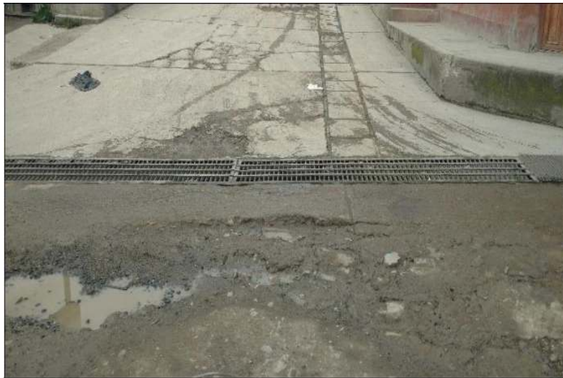
CALLE PUEBLO NUEVO ALCANTARILLA EN LA PROGRESIVA 0+146.81
