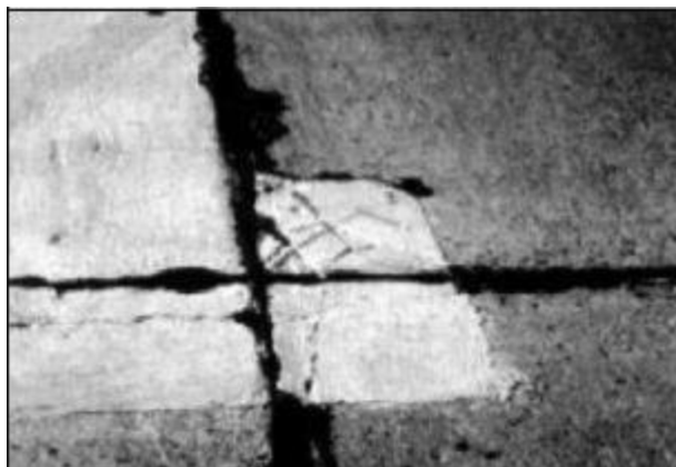
Figura N°15. Parcheo pequeño de mediana severidad.
