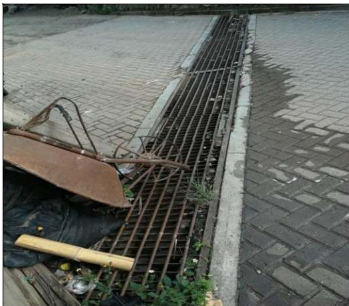
ALCANTARILLA EN LA PROGRESIVA 0+140.54
