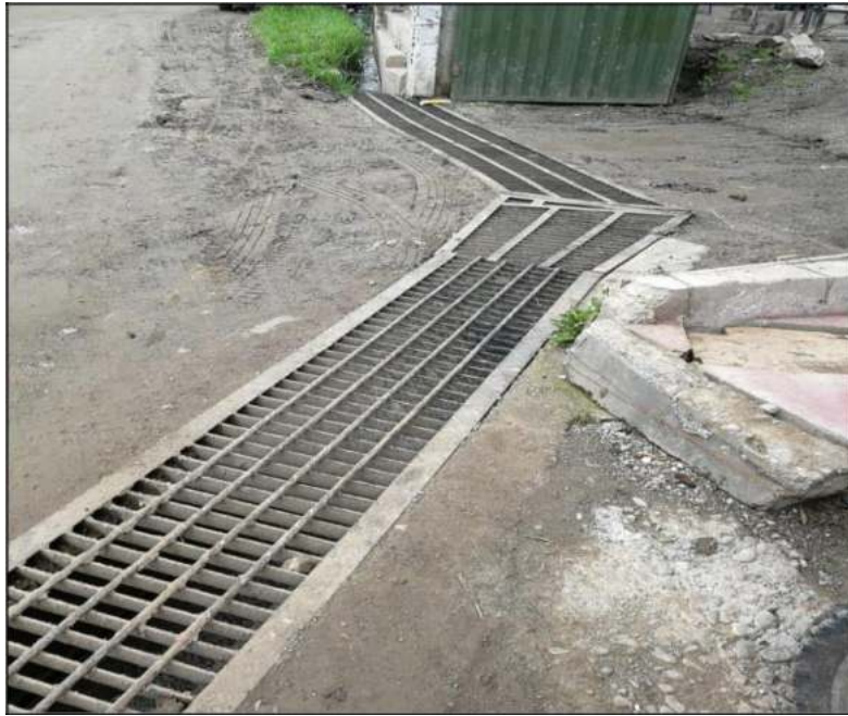
CALLE PAITA ALCANTARILLA EN LA PROGRESIVA 0+046.81
