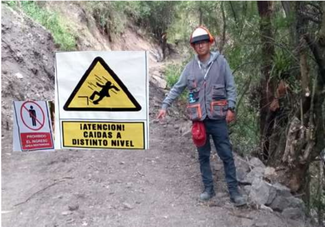
Figura 21 Señales preventivas en puntos estratégicos de la obra
