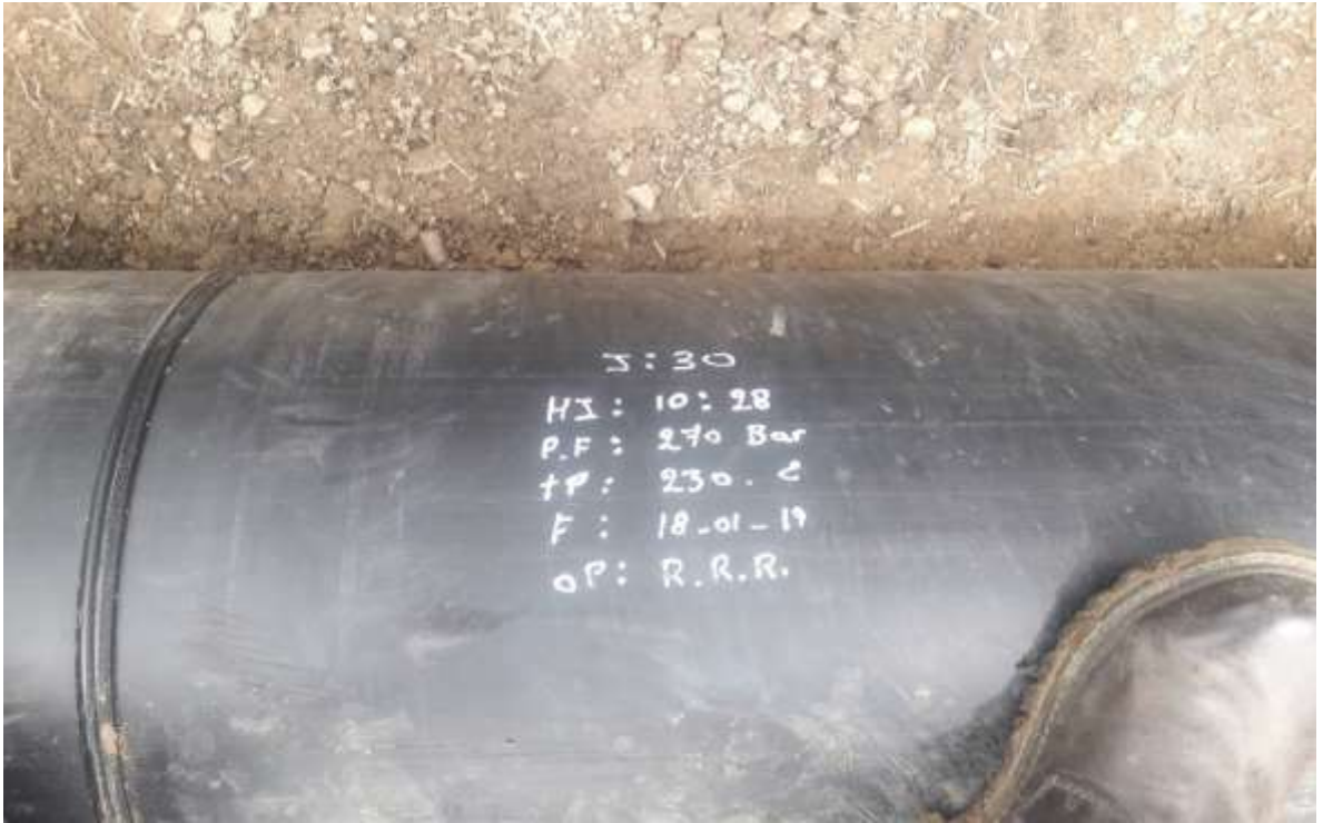
Figura 05. Se muestran imágenes de pegado de tubería (termofusion)
