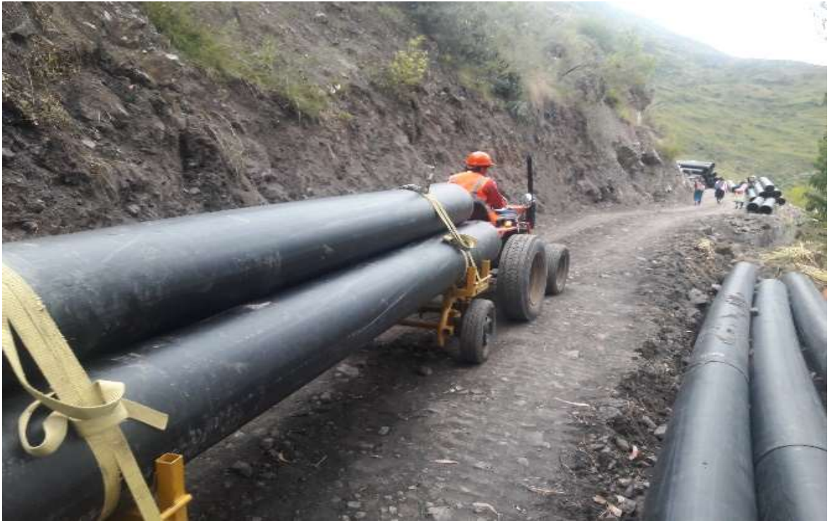
Figura 07. Se observa trabajos de traslado de la tubería HDPE.
