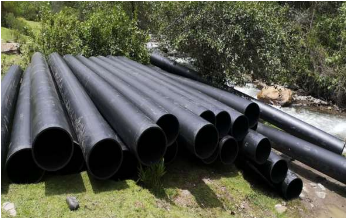
Figura 10. Se observa muestran images de la tubería HDPE 450mm.
