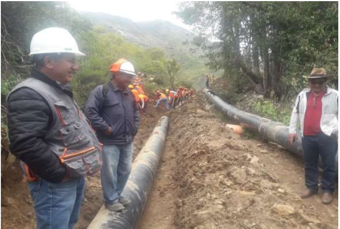
Figura 06. Se observa los trabajos de tapado con material popio en línea de conducción.
