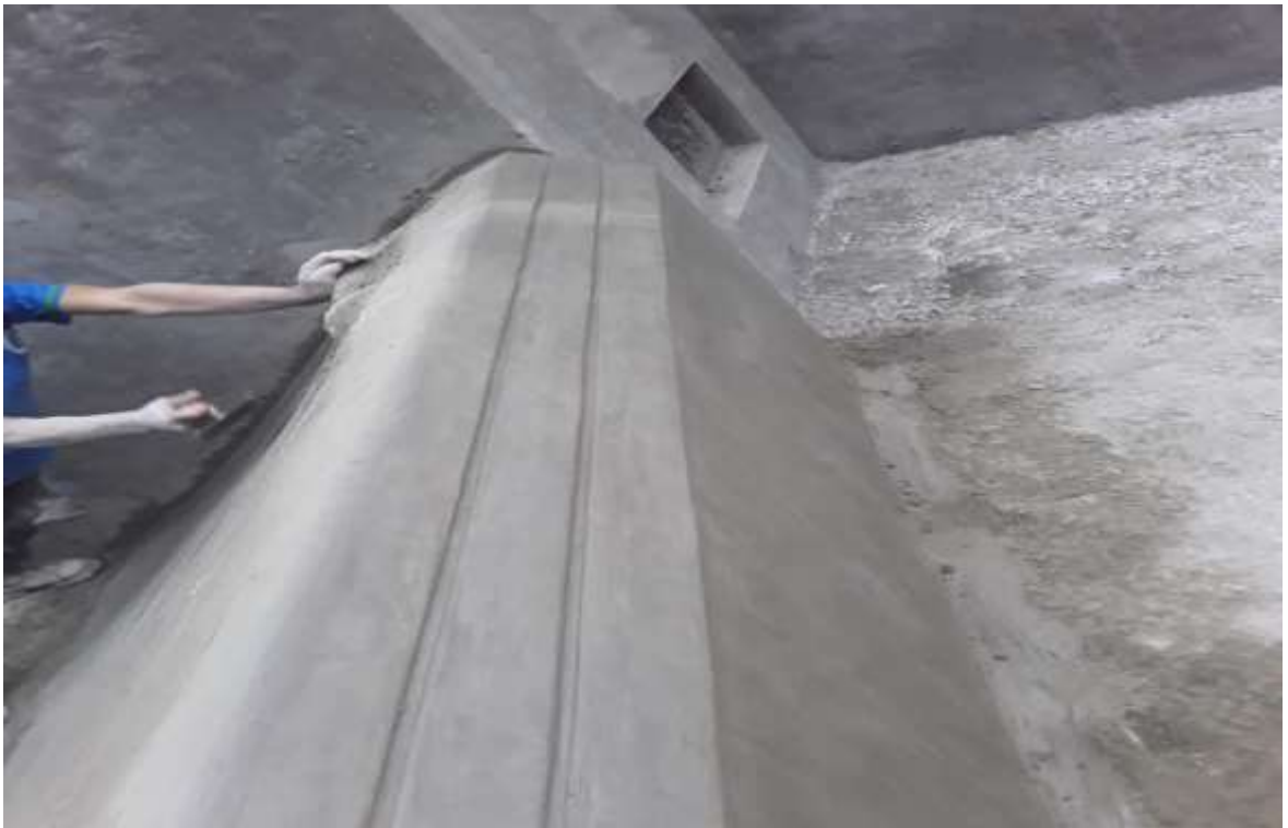
Figura 16. Se observa el barraje de tubería culminada.
