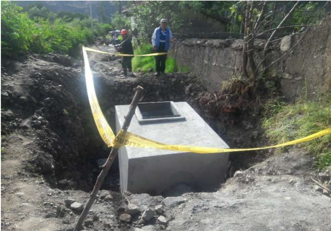
Figura 11. Se observa imágenes de acabdos de la toma lateral.
