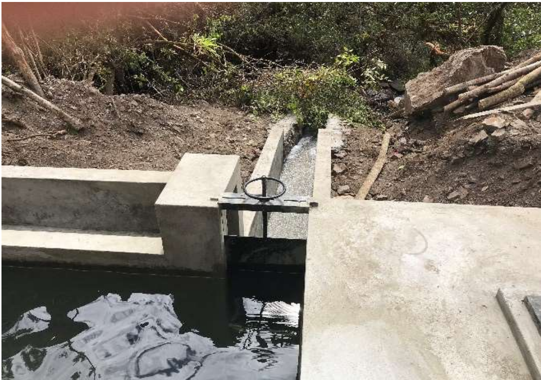
Figura 20. Desarenador.
