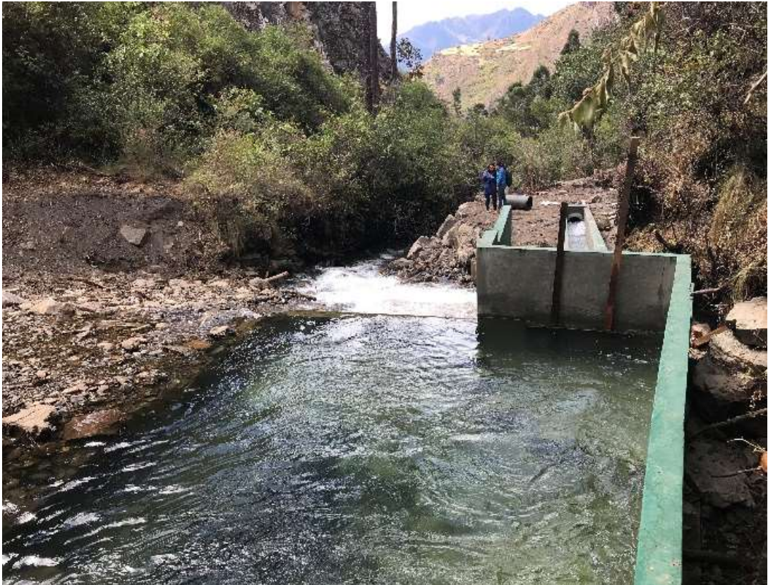
Figura 17. Se observa la culminacion de la bocatoma.
