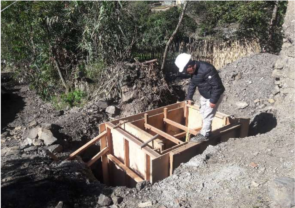
Figura 09. Se muestran imágenes de encofrado de tomas laterales.
