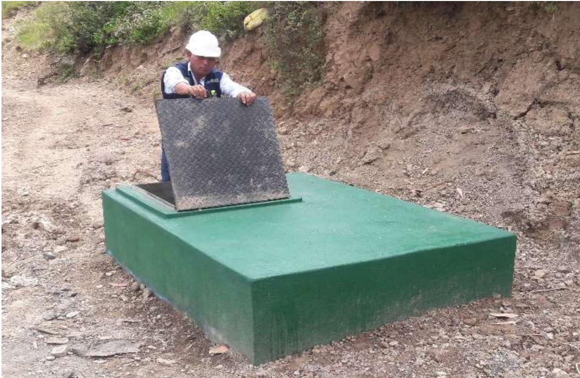
Figura 13. Se muestran imágenes de acabados de la poza disipadora.
