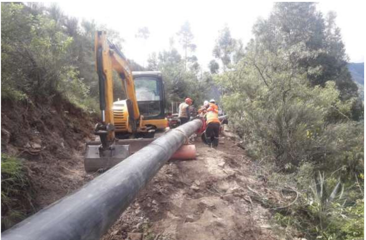
Figura 08. Se observa trabajos de traslado de tubería HDPE 450mm.
