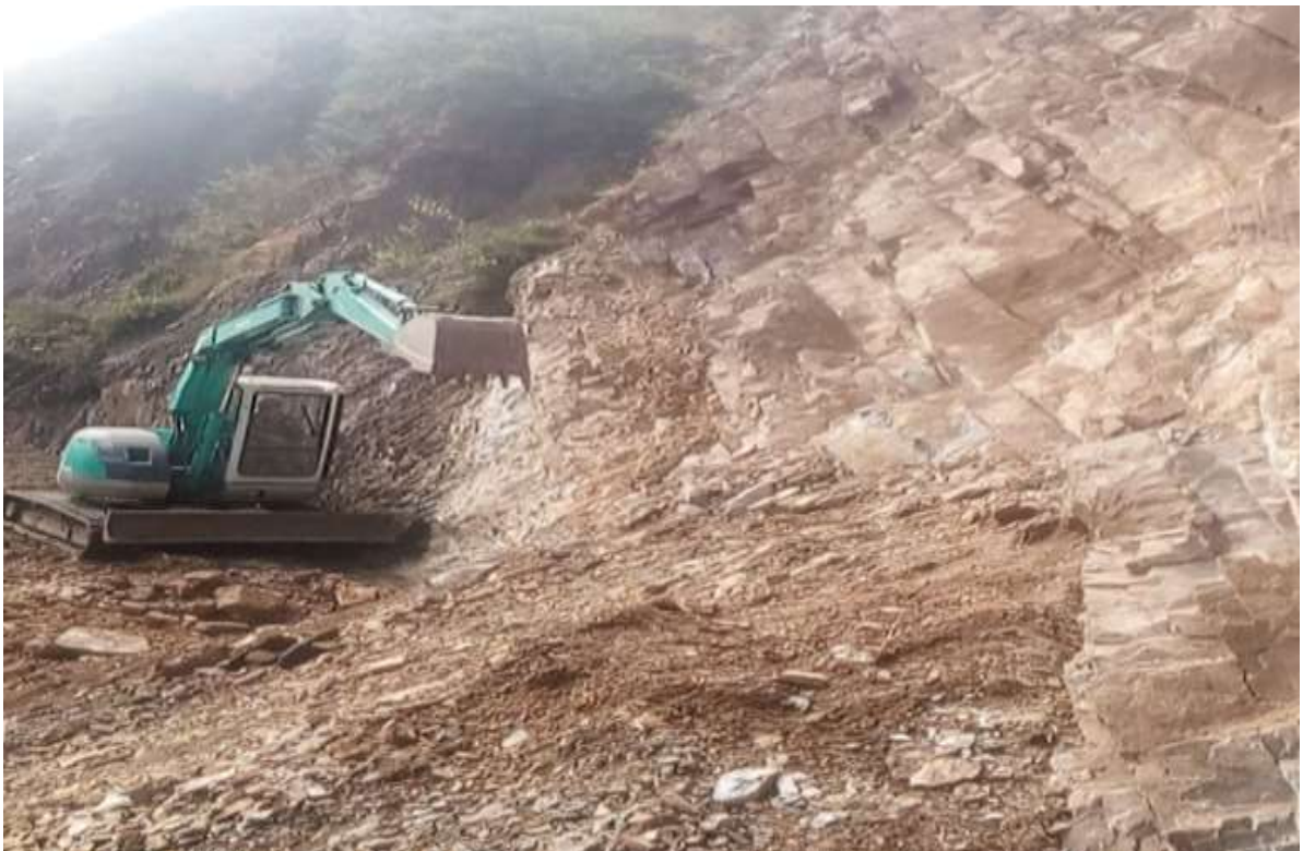
Figura 04. Se muestran imágenes de excavacion en zona rocosa.
