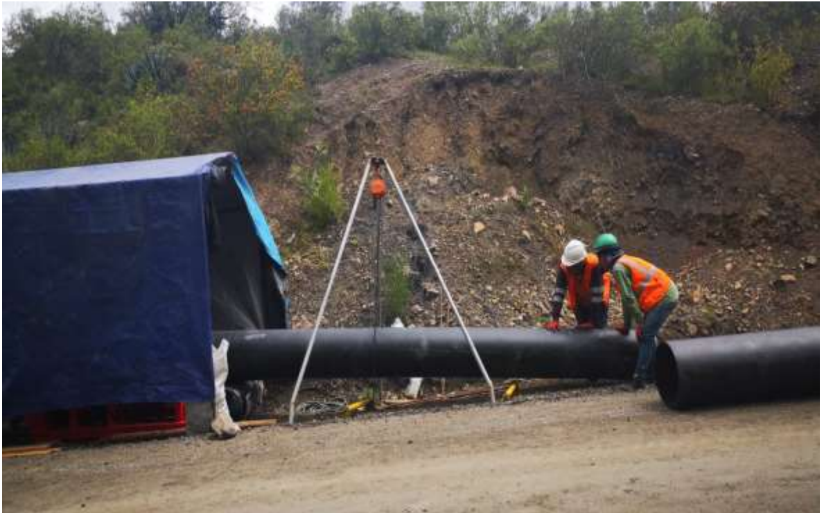
Figura 15. Se muestran imágenes de trabajos de termofusion de tubería.
