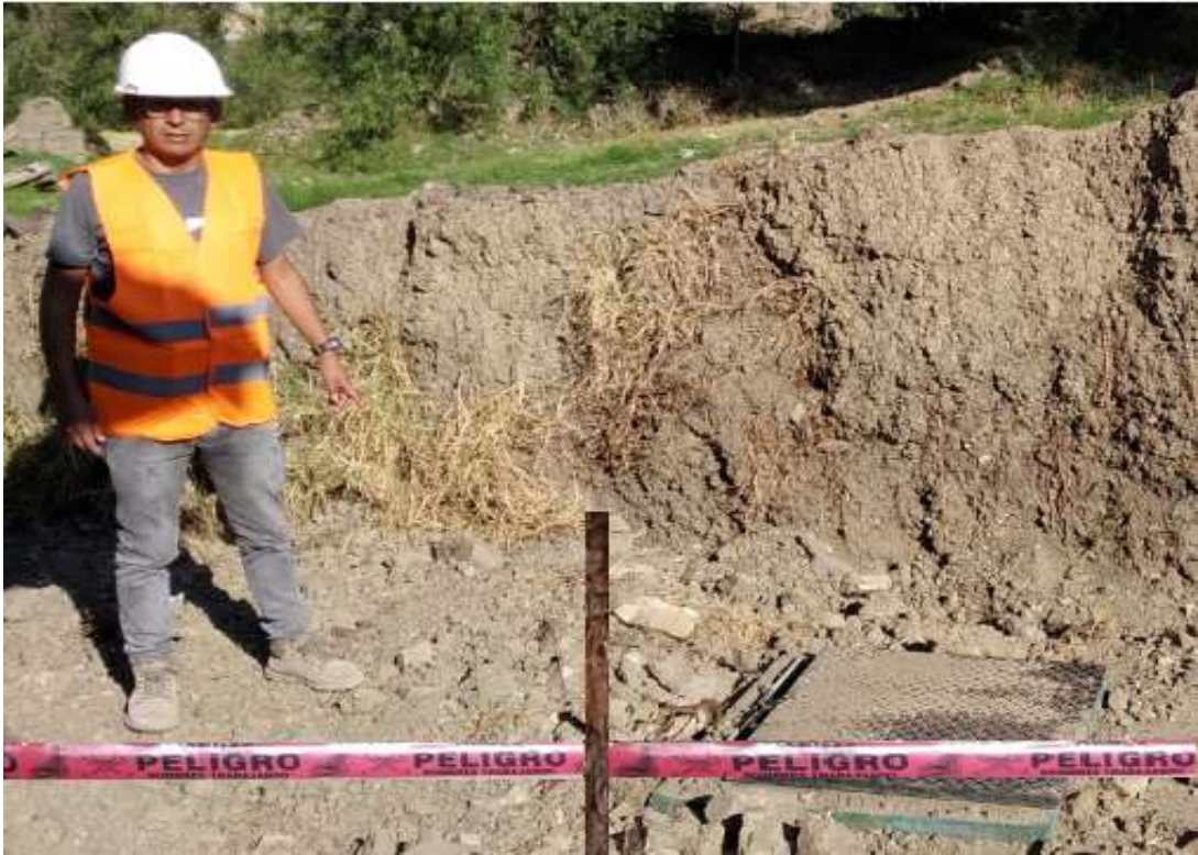
Figura 27 Verificación de señaléticas en los correspondientes lugares de trabajo
