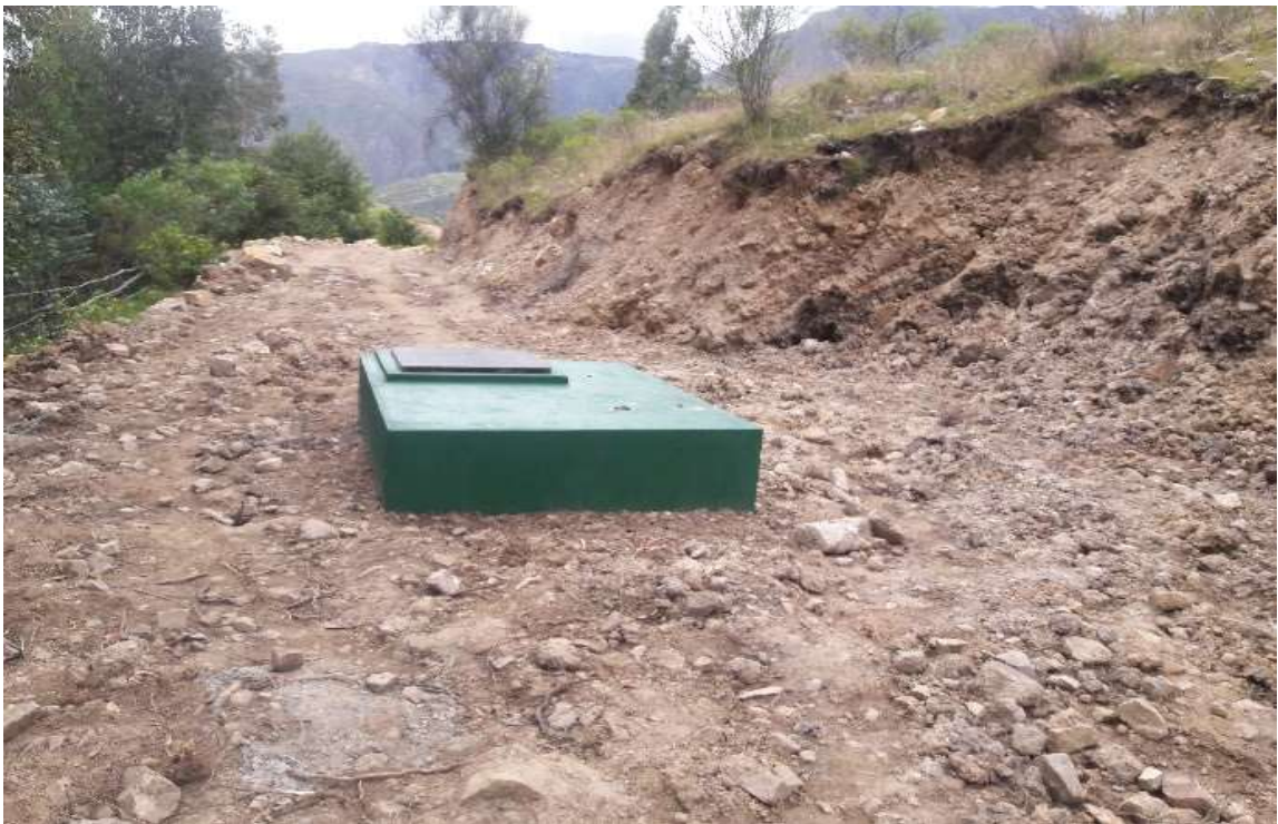
Figura 12. Se muestran imágenes de acabados de las tomas laterales.
