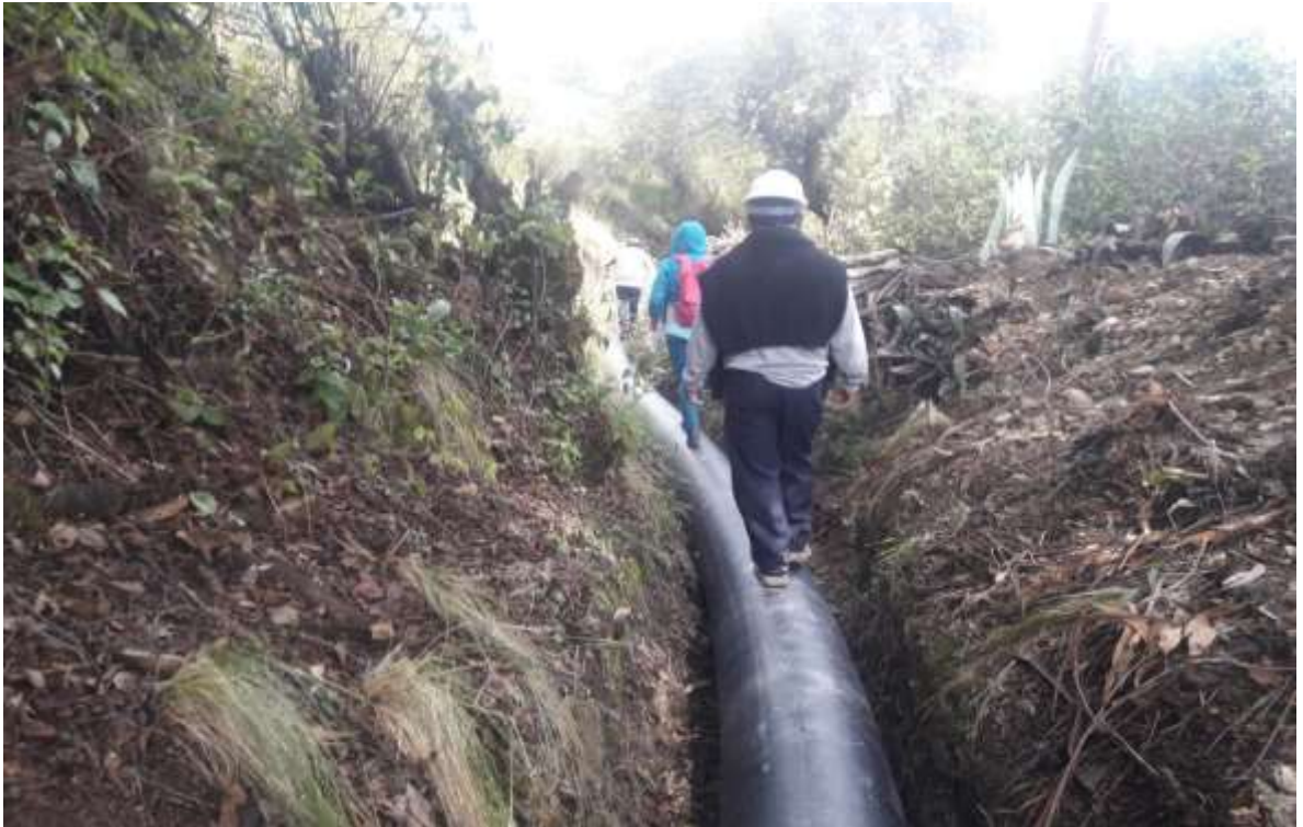
Figura 01. Se observa en tendido de tubería HDPE 450mm.
