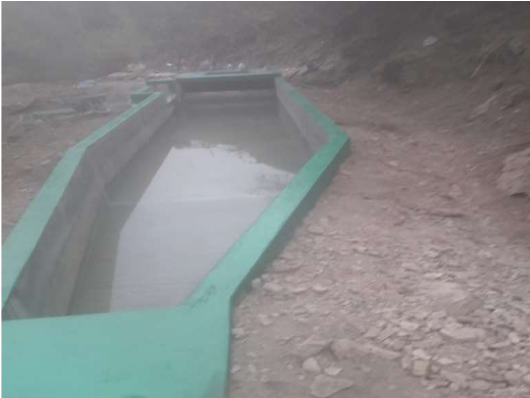
Figura 19. Se observa el desarenador acabado.
