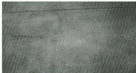
**Figura 19. Fisuración por retracción típica**
