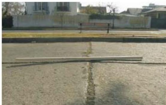
**Figura 27. Desnivel transversal de juntas y grietas (escala).**
