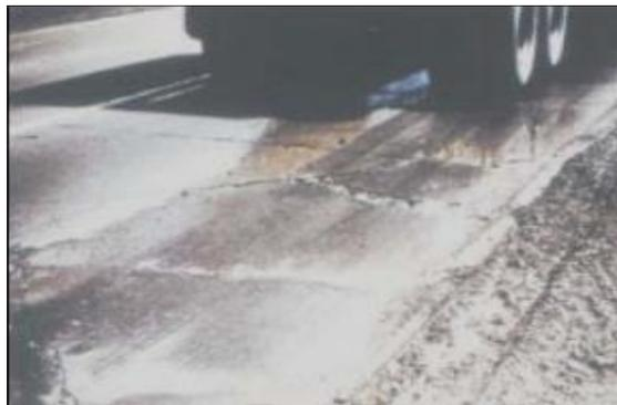
**Figura 32. Bombeo observado en la losa.**
