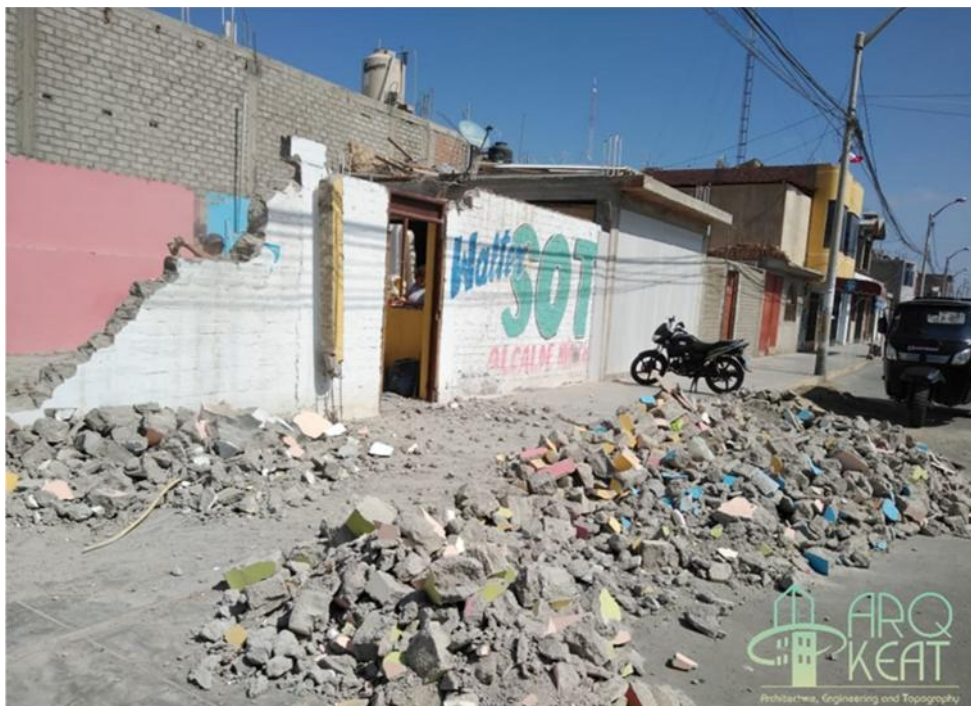
Anexo 2: Inicio de trabajos de demolición
