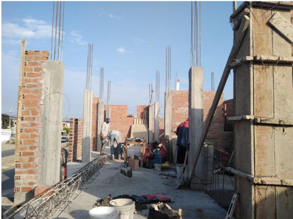
Anexo 16: Después de vaciado de columnas
