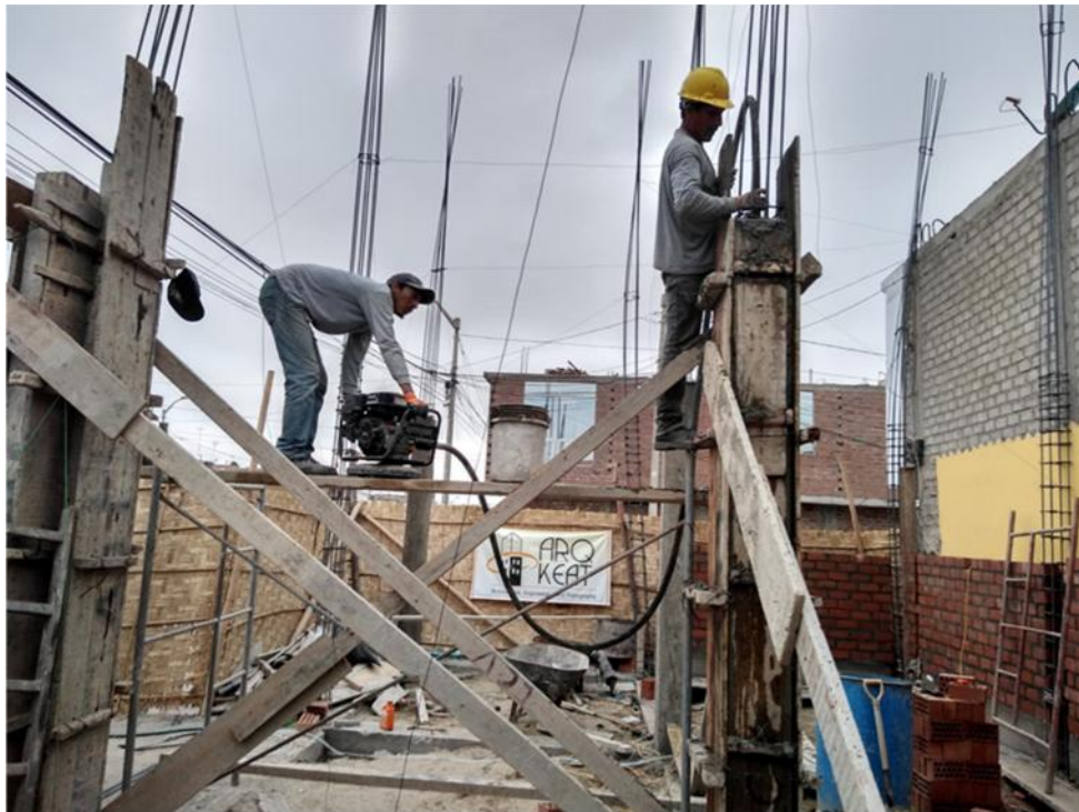
Anexo 8: Vaciado de concreto en columnas
