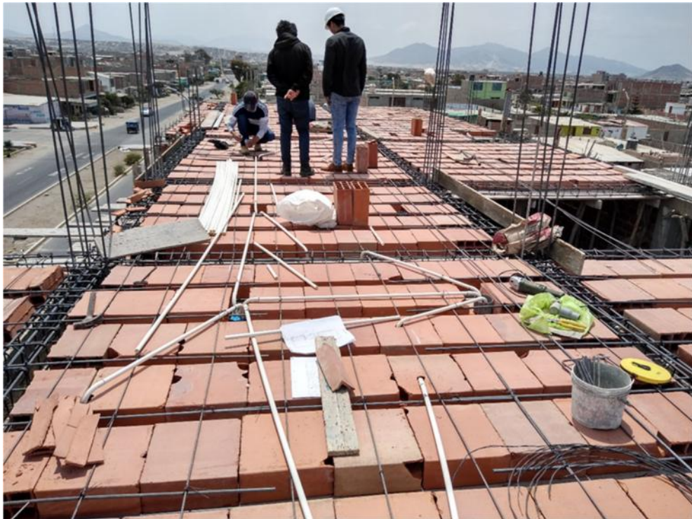
Anexo 22: Colocación de ladrillos para techo
