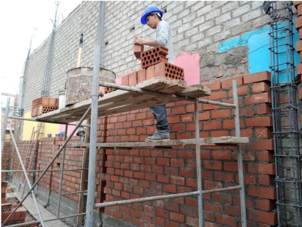
Anexo 7: Asentado de ladrillos en primer piso
