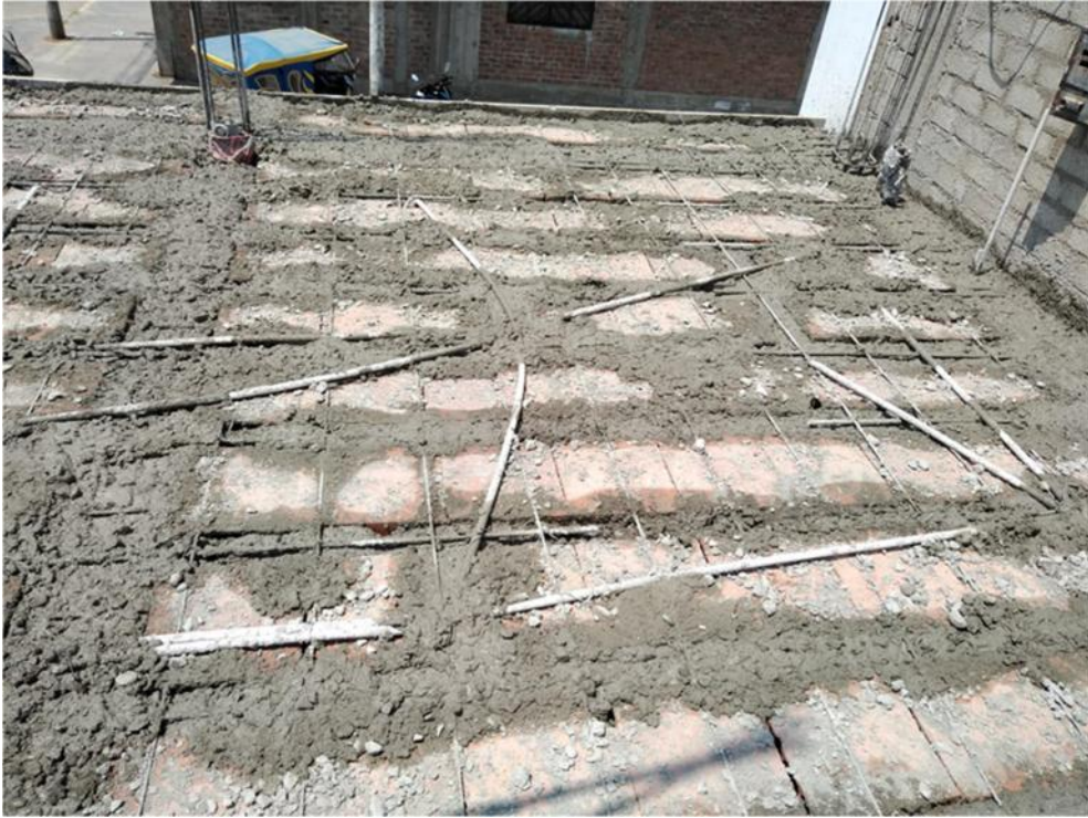
Anexo 13: Vaciado de techo
