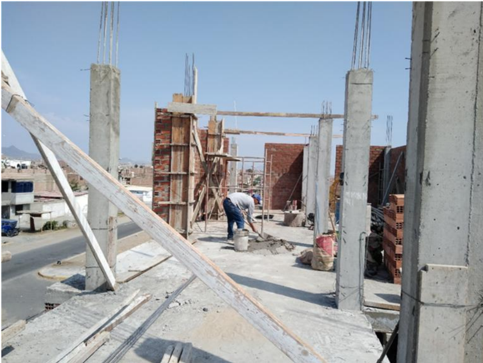
Anexo 20: Asentado de ladrillos, segundo piso
