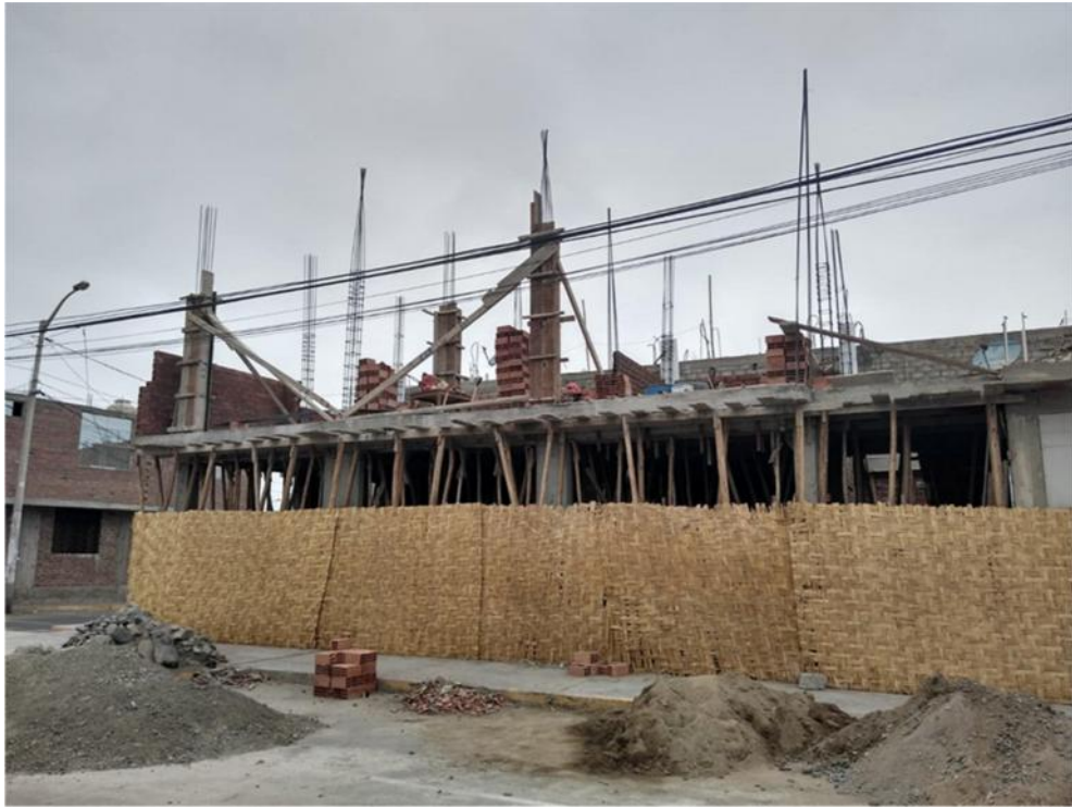
Anexo 15: Encofrado de columnas del segundo piso
