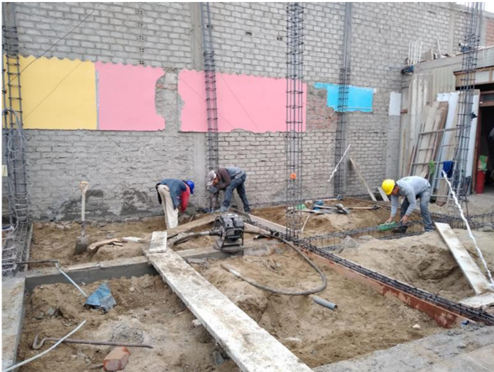
Anexo 6: Armado de vigas de cimentación
