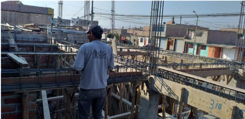
Anexo 11: Encofrado de vigas
