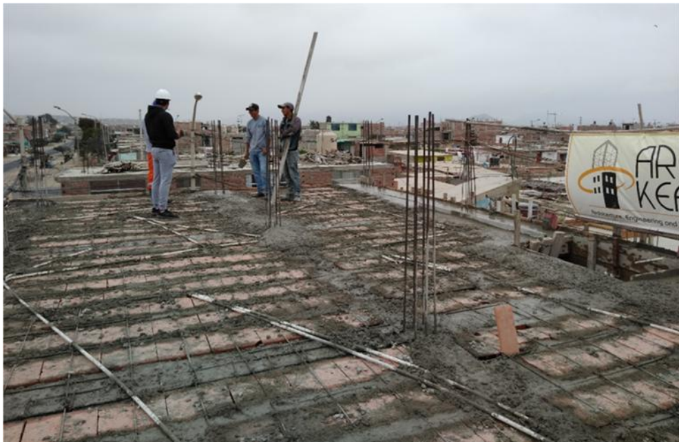
Anexo 18: Vaciado de techo, segundo piso
