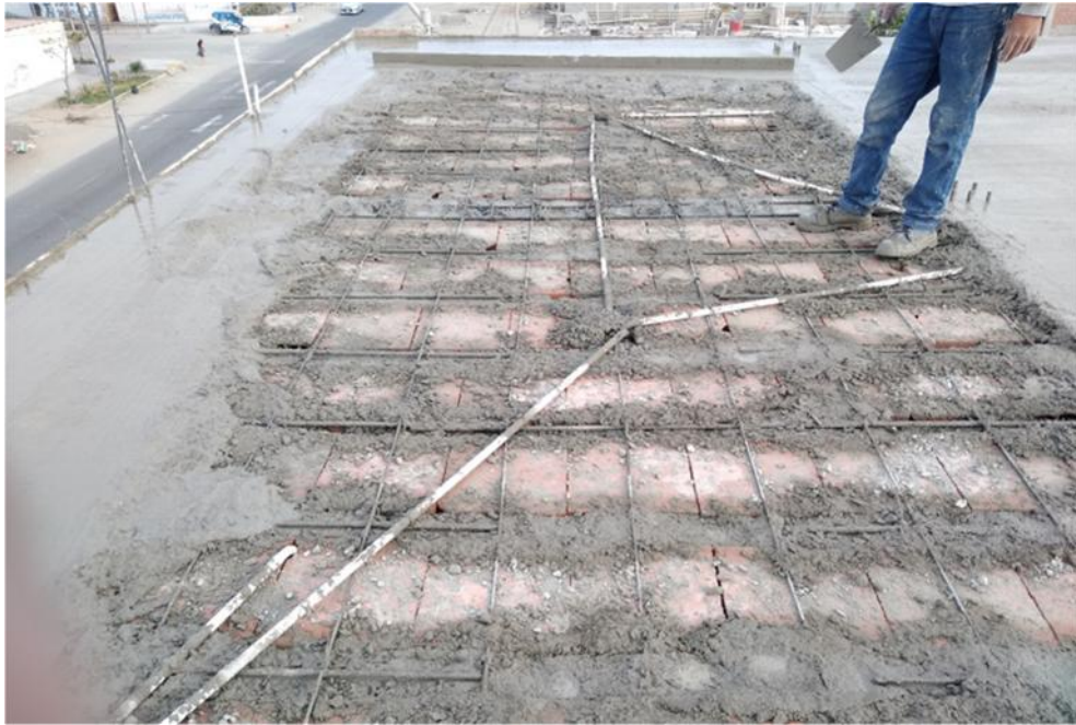
Anexo 23: Vaciado de concreto para techo
