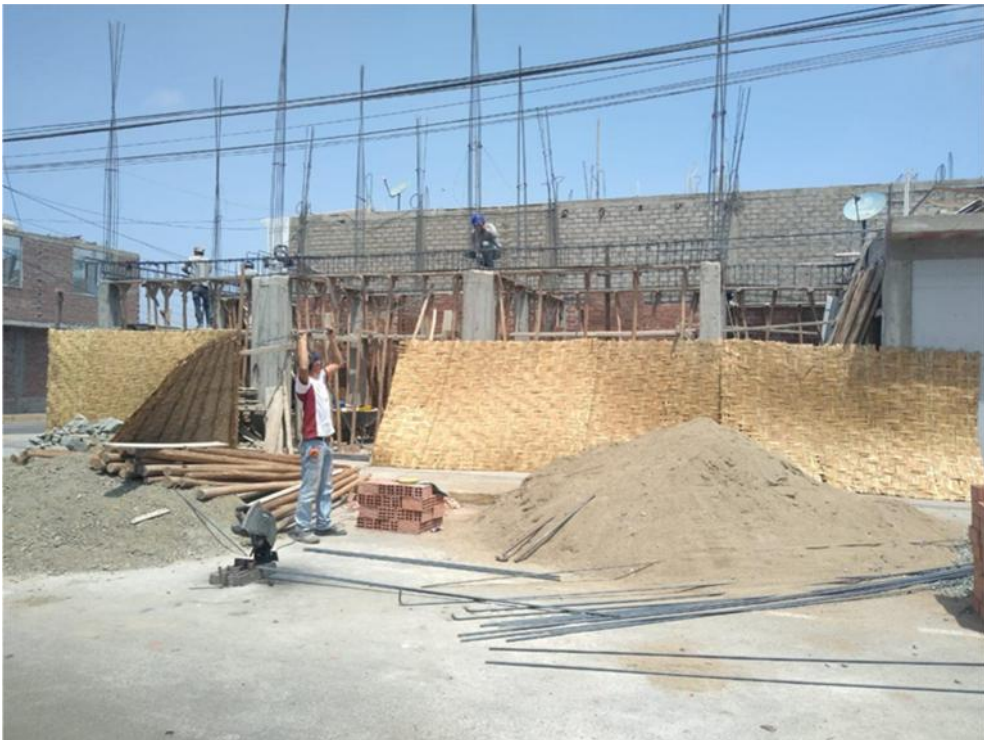
Anexo 10: Armado de vigas
