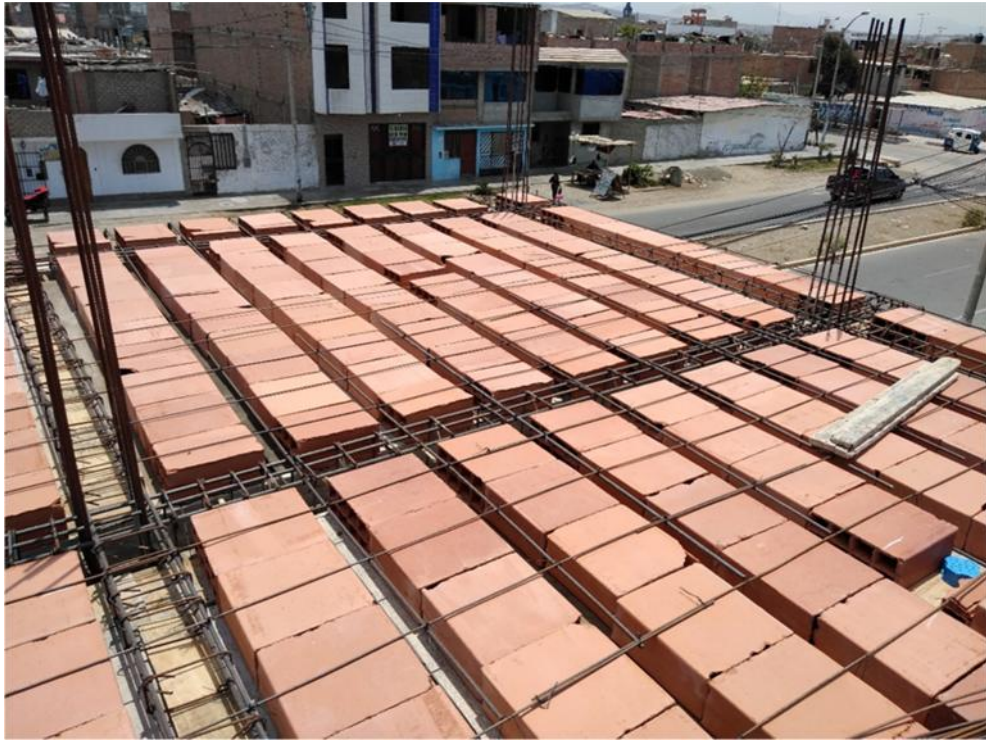
Anexo 17: Colocado de ladrillos para techo del segundo piso
