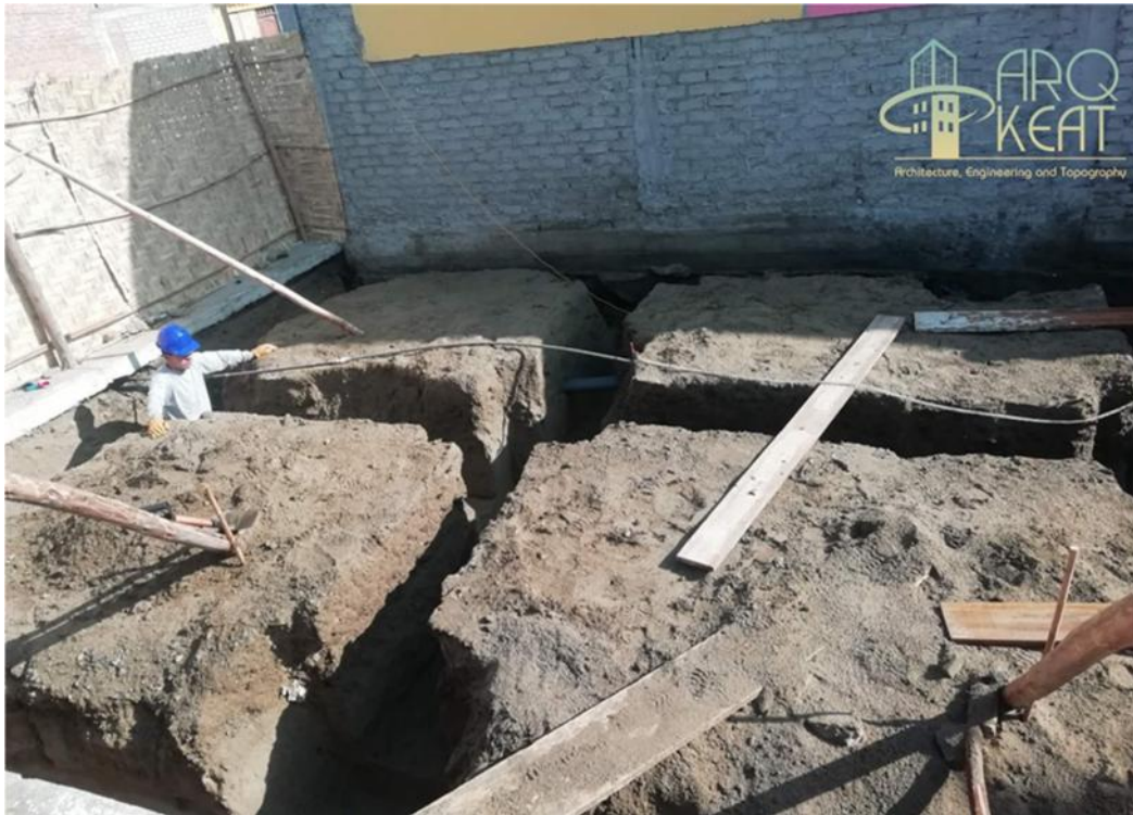
Anexo 4: Trabajos de excavaciones
