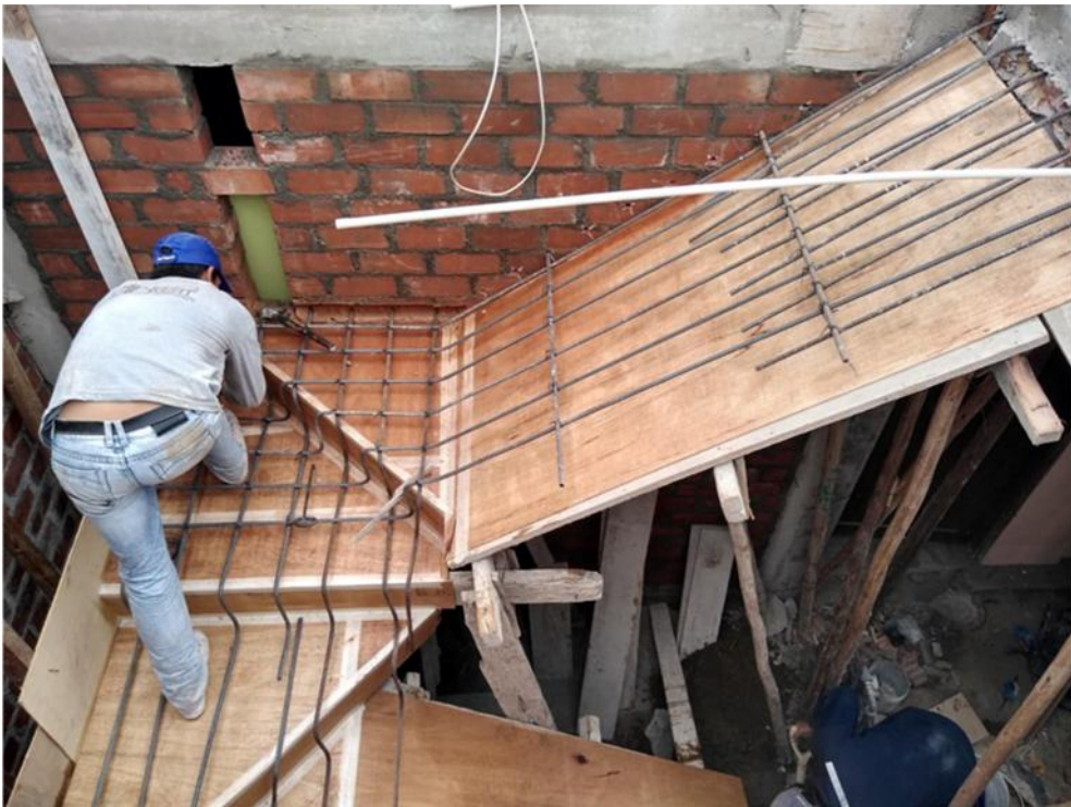
Anexo 14: Armado de escaleras
