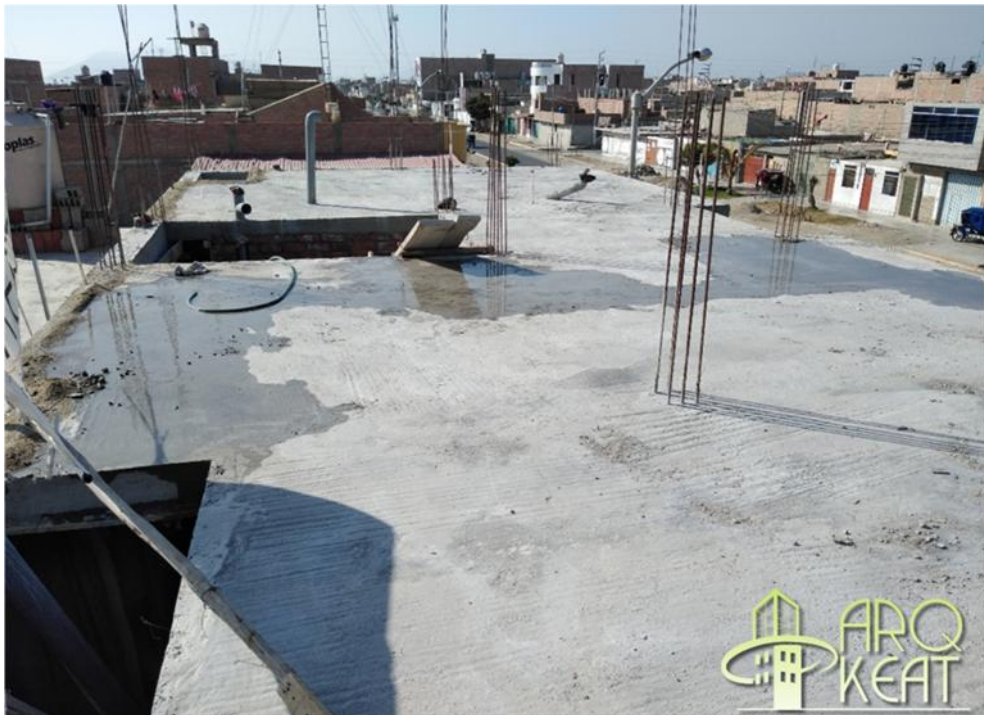
Anexo 24: Curado de techo del tercer piso
