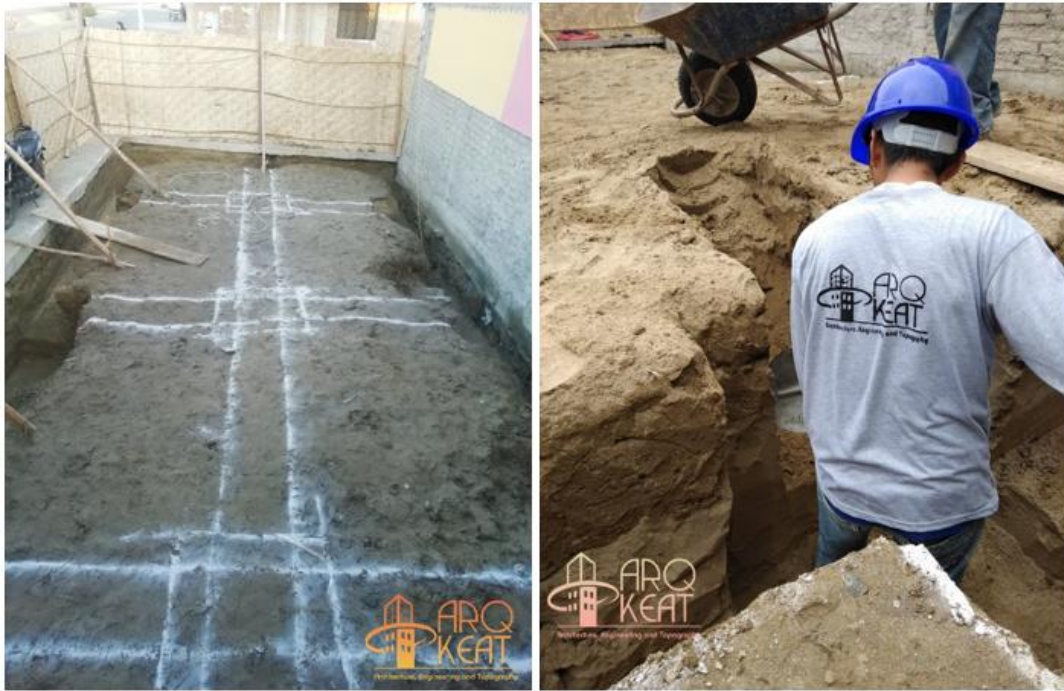
Anexo 3: Trabajos de excavación para cimientos
