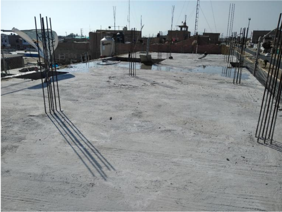
Anexo 19: Curado de techo, segundo piso
