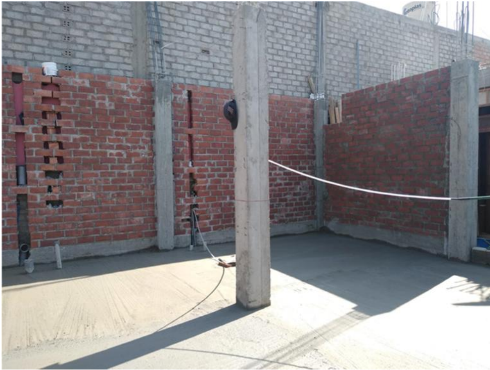
Anexo 9: Desencofrado de columnas
