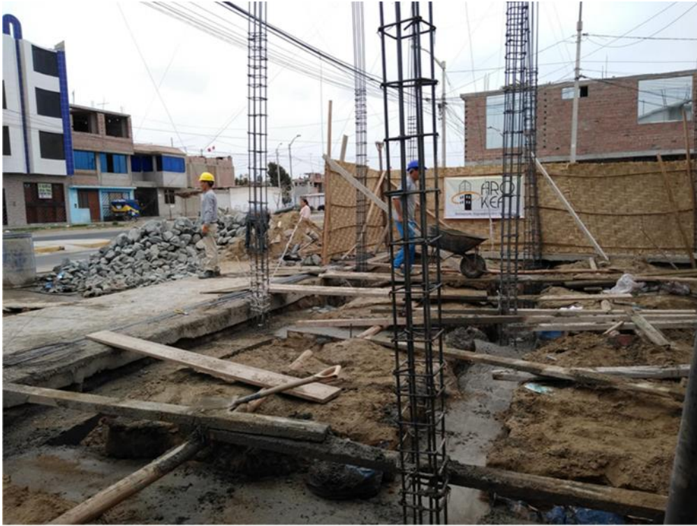
Anexo 5: Vaciado de cimentaciones
