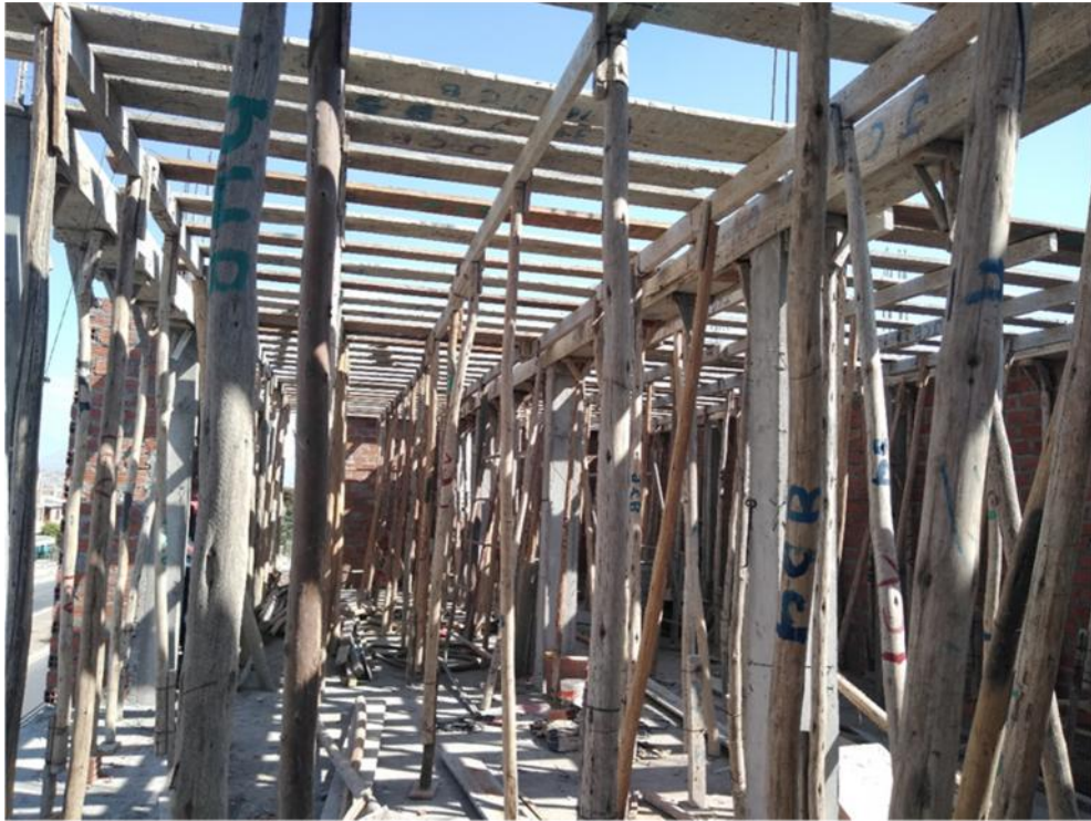
Anexo 21: Encofrado para techo del segundo piso
