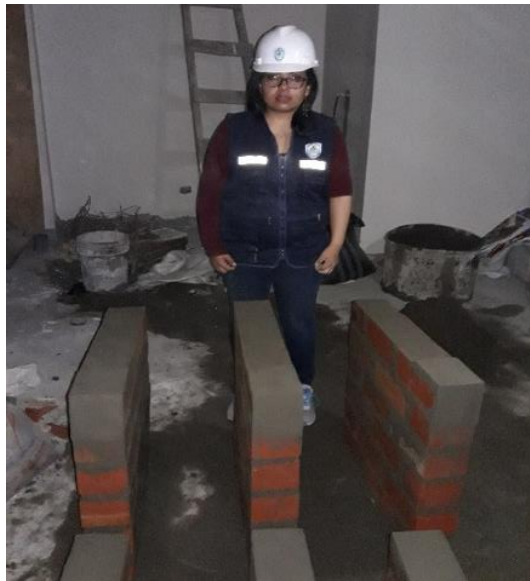
Foto N° 08. Vista de Muros y Pilas terminadas
