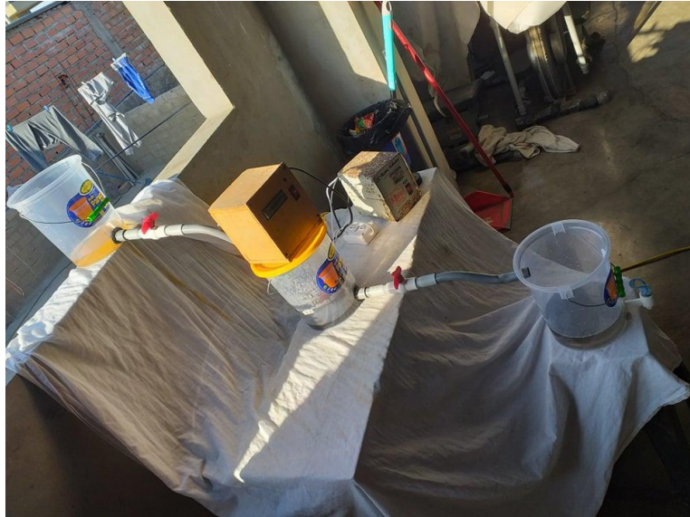
Figura 32. Biofiltro culminado, en pleno proceso de remoción.
