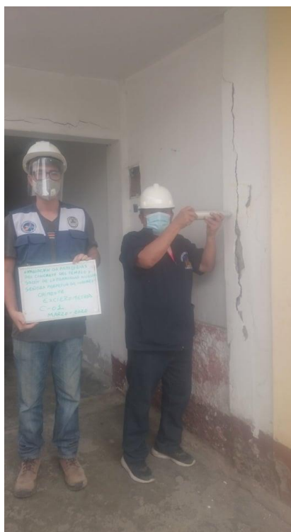
Figura N°16. Ensayo de esclerometría en la columna
