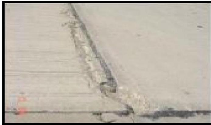
Figura 3. Juntas saltadas en pavimentos rígidos
