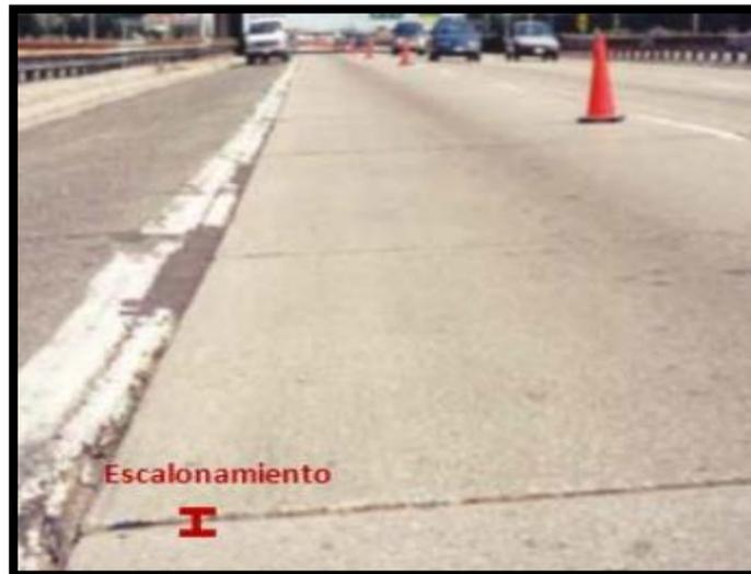
*Figura 9.* Escalonamiento de junta
