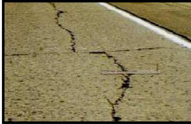
*Figura 7.* Grietas en la longitudinales en pavimento rígidos
