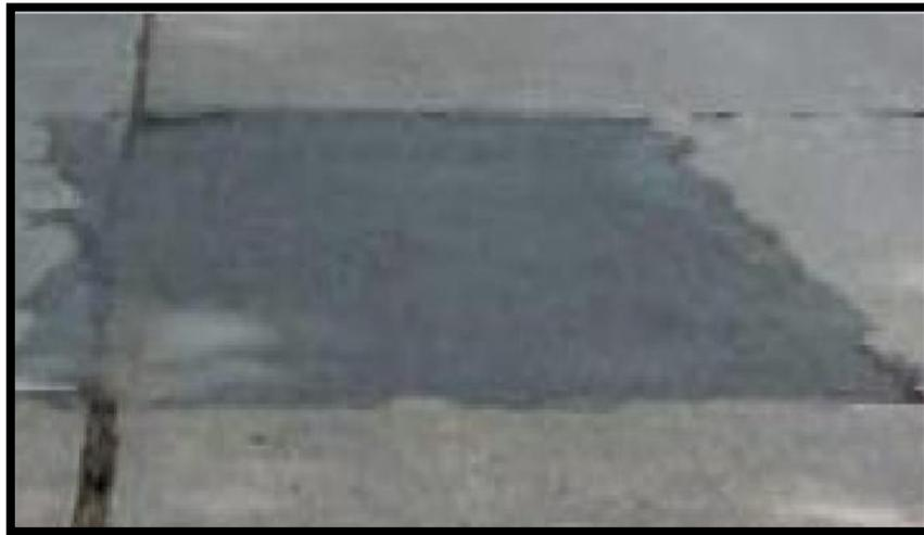
*Figura 14.* Parches deteriorados en pavimentos rígidos
