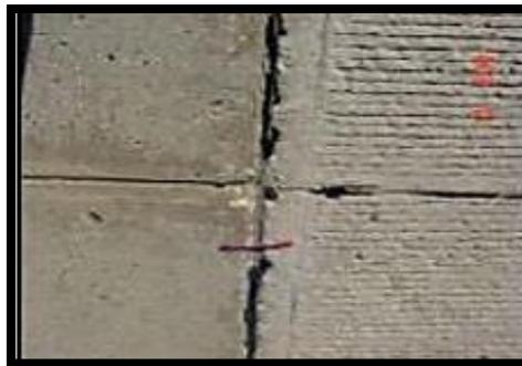
*Figura 2. Deficiencia de sellados en pavimentos rígidos*
