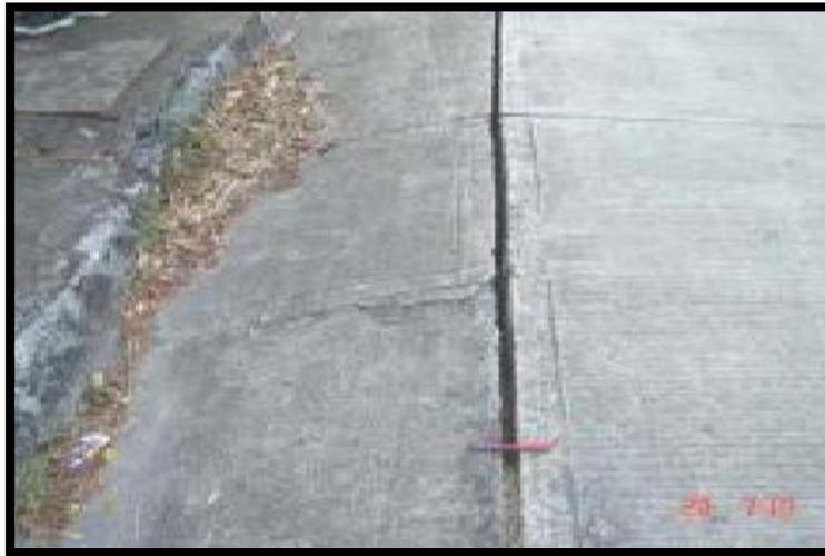
*Figura 17.* Separacion entre la berma y pavimento
