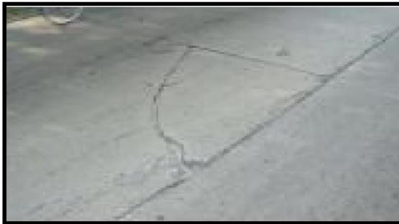
*Figura 6.* Grietas en la esquina en pavimento rígidos
