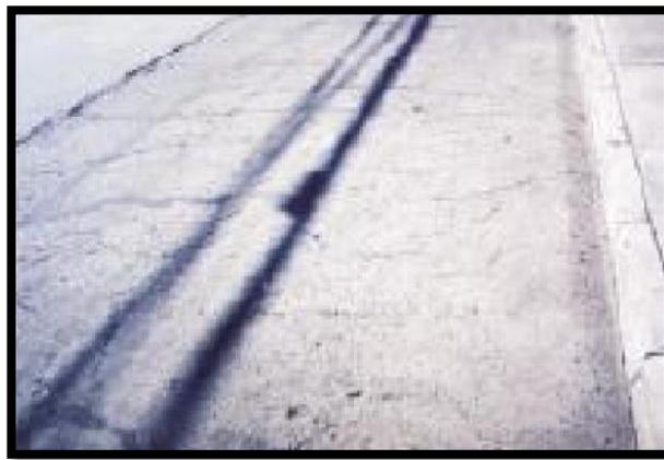
*Figura 10* Fisuramientos por retracción en pavimentos rígidos
