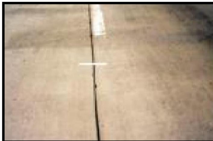
Figura 4. Juntas saltadas en pavimentos rígidos
