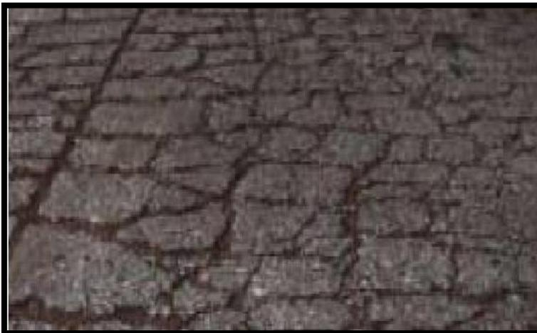
*Figura 16.* Fragmentacion multiple en pavimentos rígidos
