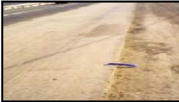
Figura 13. Descenso de la berma en pavimentos rígidos
