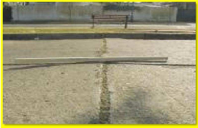
*Figura 18.* Levantamientos localizados en pavimentos rígidos
