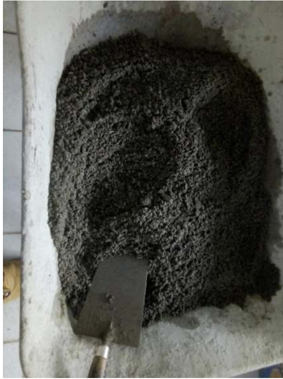
Figura N° 32: Mezclado preparara con la dosificación correspondiente.
