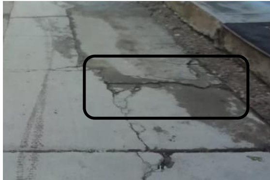
Figura 9. Grietas transversales
