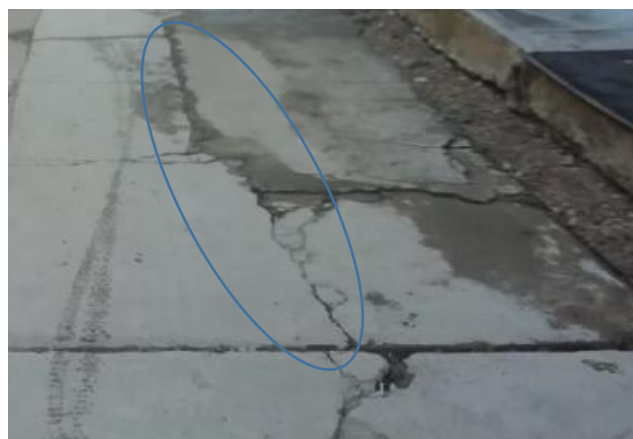
Figura 8. Grietas longitudinales
