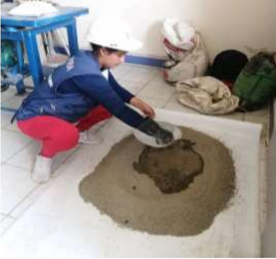
**Figura 32.** Luego de mezclar los agregados con el cemento se hecho el agua
