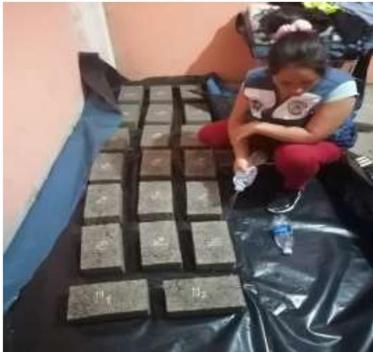
**Figura 36.** Curado de ladrillo rociando agua a los ladrillos
