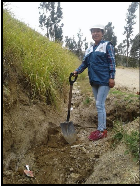
Figura 4. Excavación de la Calicata
