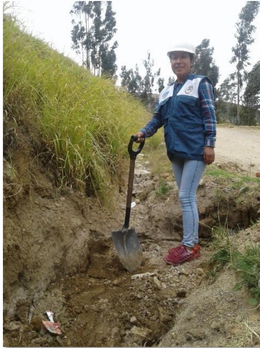
Figura 25. Excavación de la Calicata
