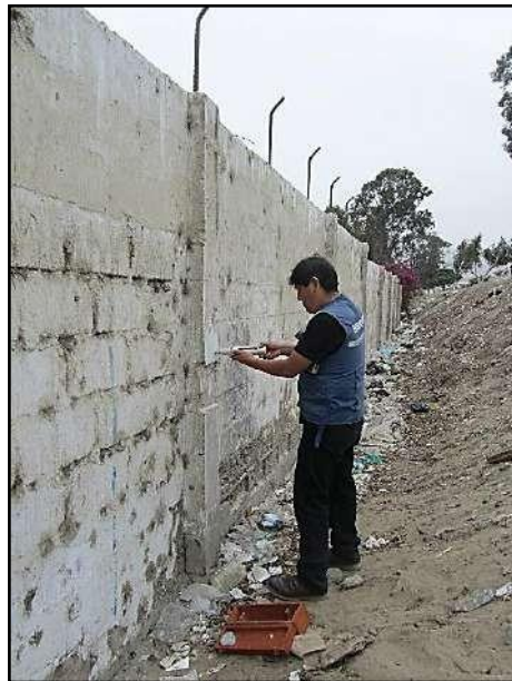
Fig. 86: ENSAYO DE ESCLEROMETRIA TRAMO CENTRAL DEL CERCO PERIMETRICO EXTERIOR
