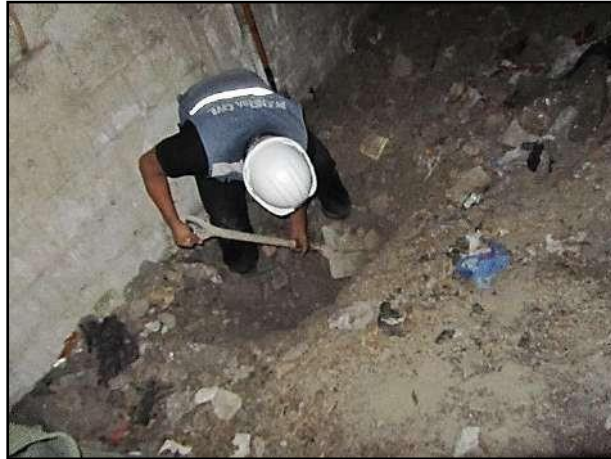
Fig. 79: EXCAVACION DE TERRENO (CALICATAS) PARA EXTRACCION DE MUESTRAS
