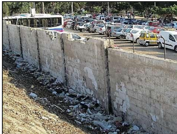
Fig. 76: OTRA VISTA ACTUAL DE CERCO PERIMETRICO EXTERIOR - FRENTE PANAMERICANA NORTE
