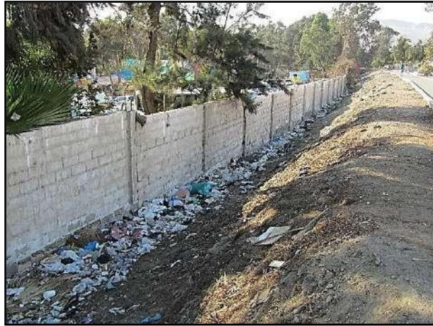
Fig. 75: TRAMO ACTUAL DE CERCO PERIMETRICO EXTERIOR - FRENTE PANAMERICANA NORTE
