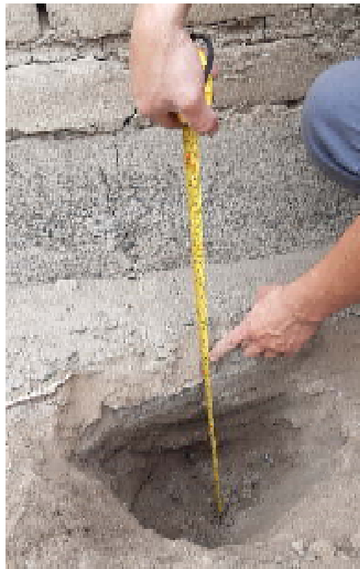
Figura 78: Cimentación de concreto.
