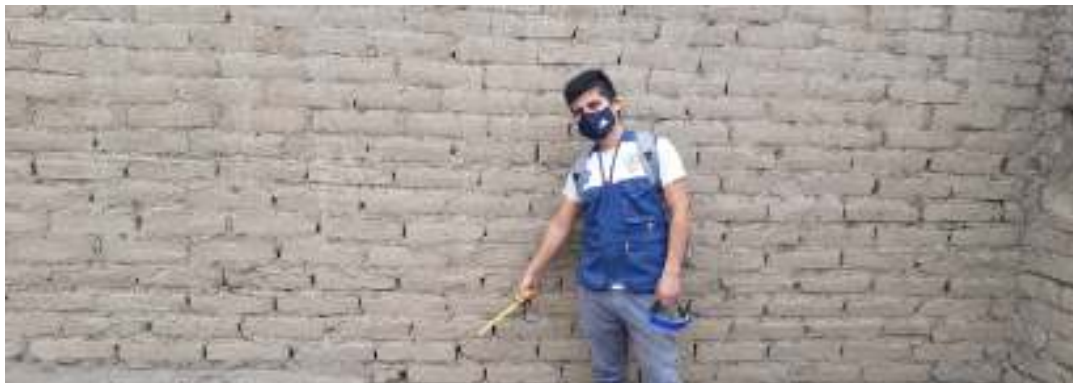
Figura 63: Vivienda con adobes en buen estado, pero sin mortero verticales.
