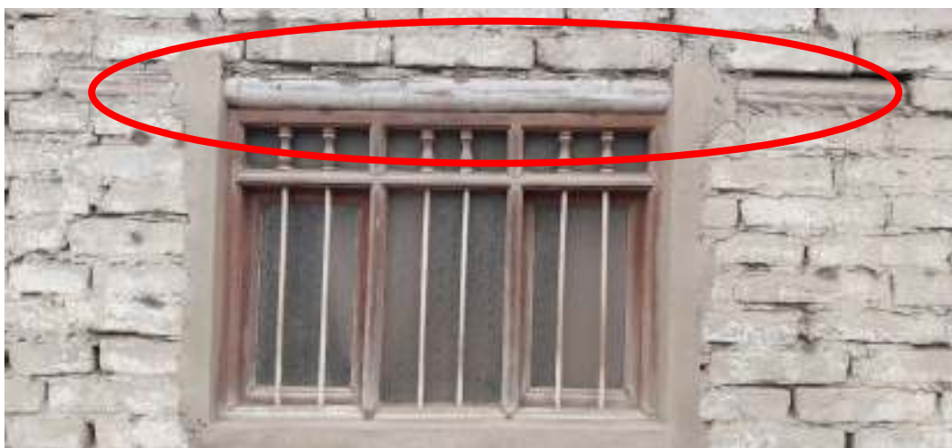
Figura 65: Vivienda con dintel de Guayaquil de 4" de diámetro.
