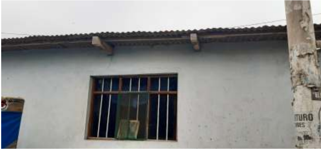
Figura 60: Vivienda con cubierta de eternith con viguetas de listones de madera.
