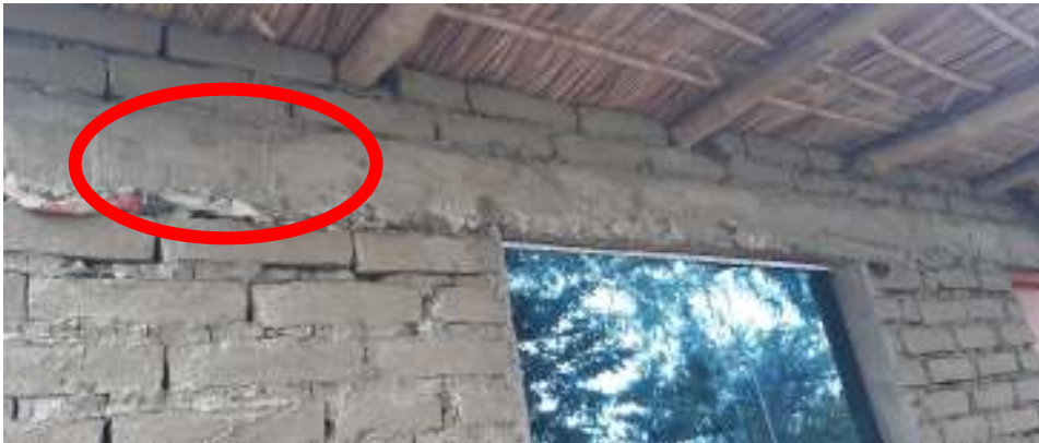
Figura 58: Vivienda con viga de arriostre de concreto armado.
