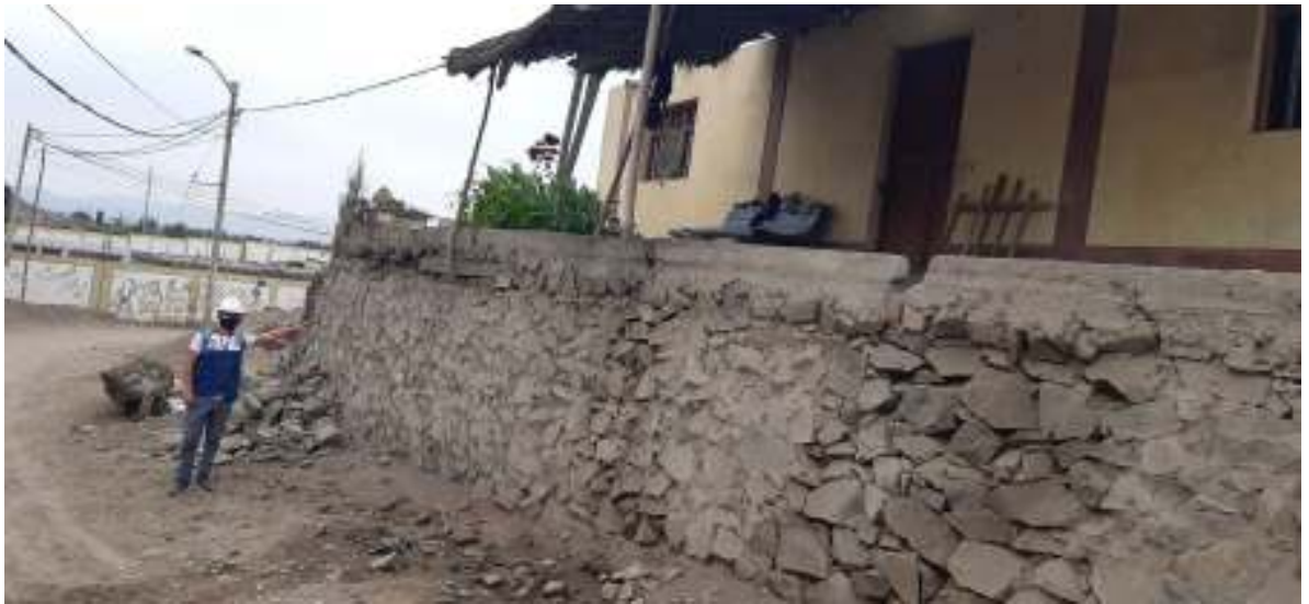
Figura 70: Vivienda con relleno de piedra presentando pendiente.
