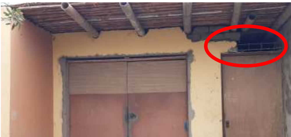
Figura 59: Vivienda con arriostre de acero y barro.
