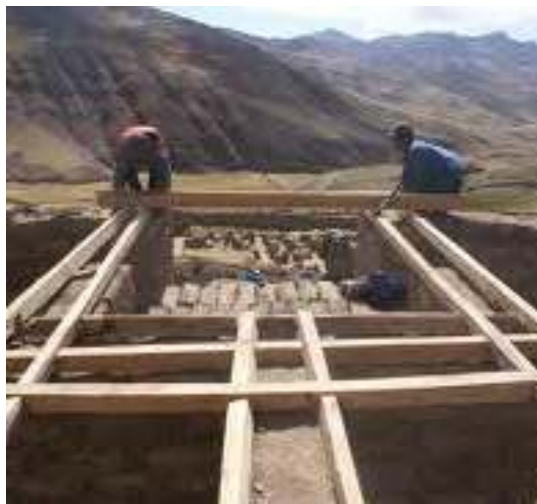
Figura 44. Arriostre horizontal o viga collar.
