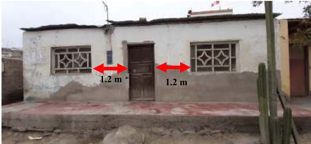
Figura 67: Vivienda con vanos separados de ventana a puerta de 1.20m.
