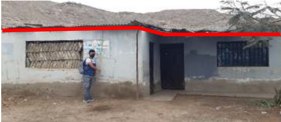
Figura 57: Vivienda con arriostre de listón de madera.
