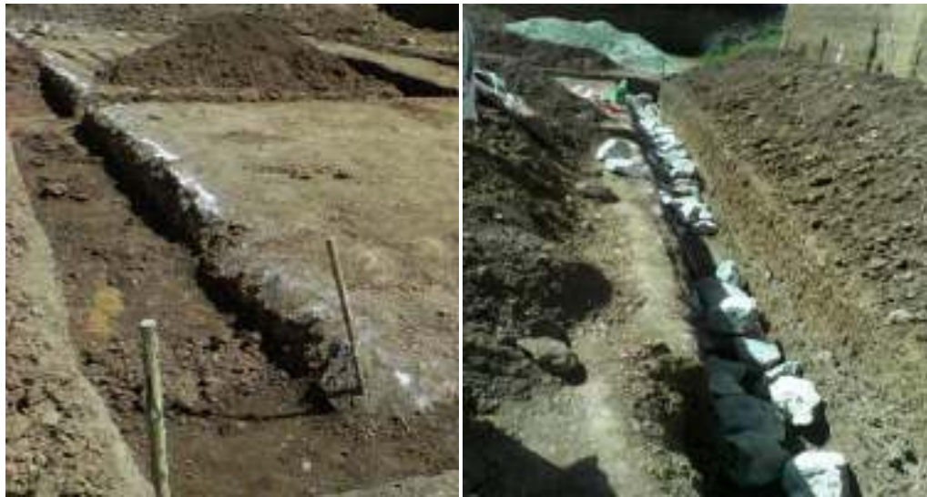
Figura 41. Proceso constructivo de cimientos.
