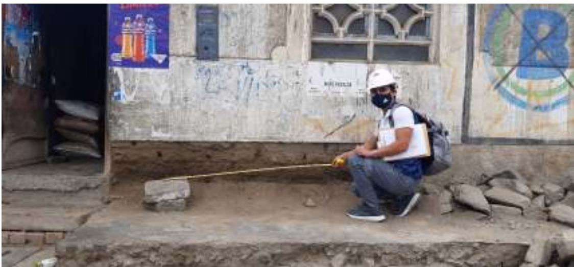
Figura 73: Vivienda con muro salitrados.
