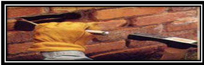
**Ilustración 20: Extracción de ladrillo - retiro de motero de pega y limpieza.**
