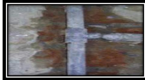
**Ilustración 6: Fugas de agua en tuberías (empalme y/o deterioro).**
