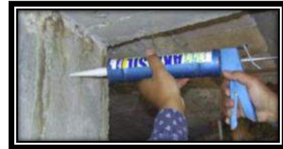
**Ilustración 24: Inyección de resina epóxica con pistola de inyección manual.**
