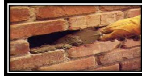
**Ilustración 21: Colocación de nuevo mortero.**
