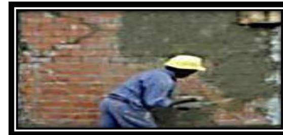
**Ilustración 39: Pañeteo del muro.**
