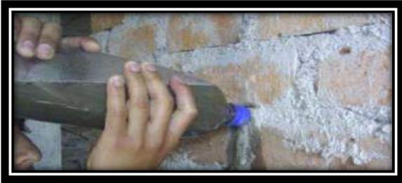
**Ilustración 14: Inyección de lechada de cemento de manera manual a las grietas.**
