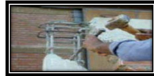
**Ilustración 38: Picado del nudo viga - columna.**
