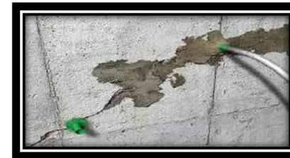
**Ilustración 13: Inyección de lechada de cemento con presión de 10 a 30 PSI.**
