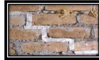
**Ilustración 12: Colocación de cinta mástil en las grietas.**
