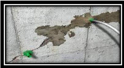
**Ilustración 15: Inyección con lechada de mortero.**
