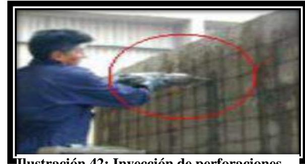
**Ilustración 42: Inyección de perforaciones.**
