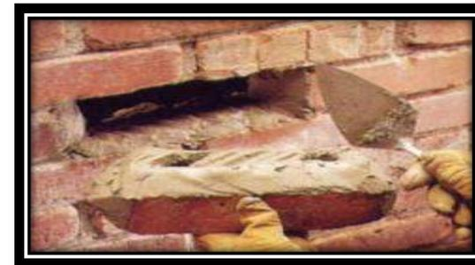
**Ilustración 22: Colocación de nuevo ladrillo.**
