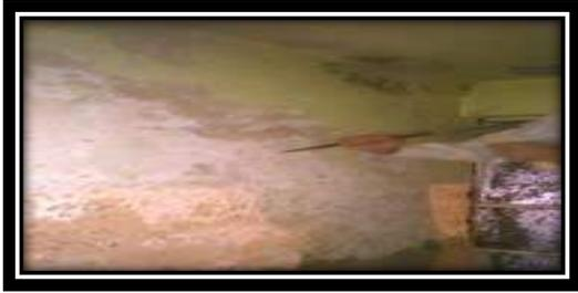
**Ilustración 5: Picado de muros.**
