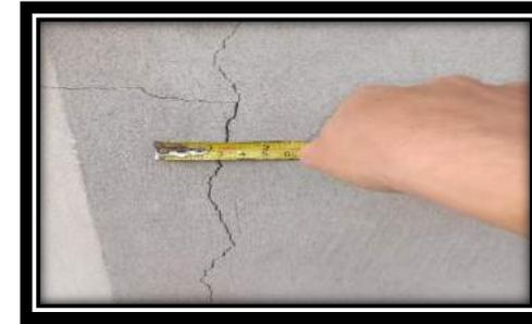
**Ilustración 7: Espesor de grietas.**
