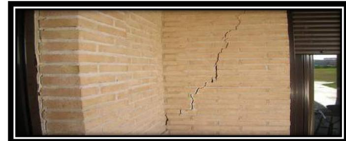
**Ilustración 16: Grietas con grosor mayor a 1.5 mm de grosor.**
